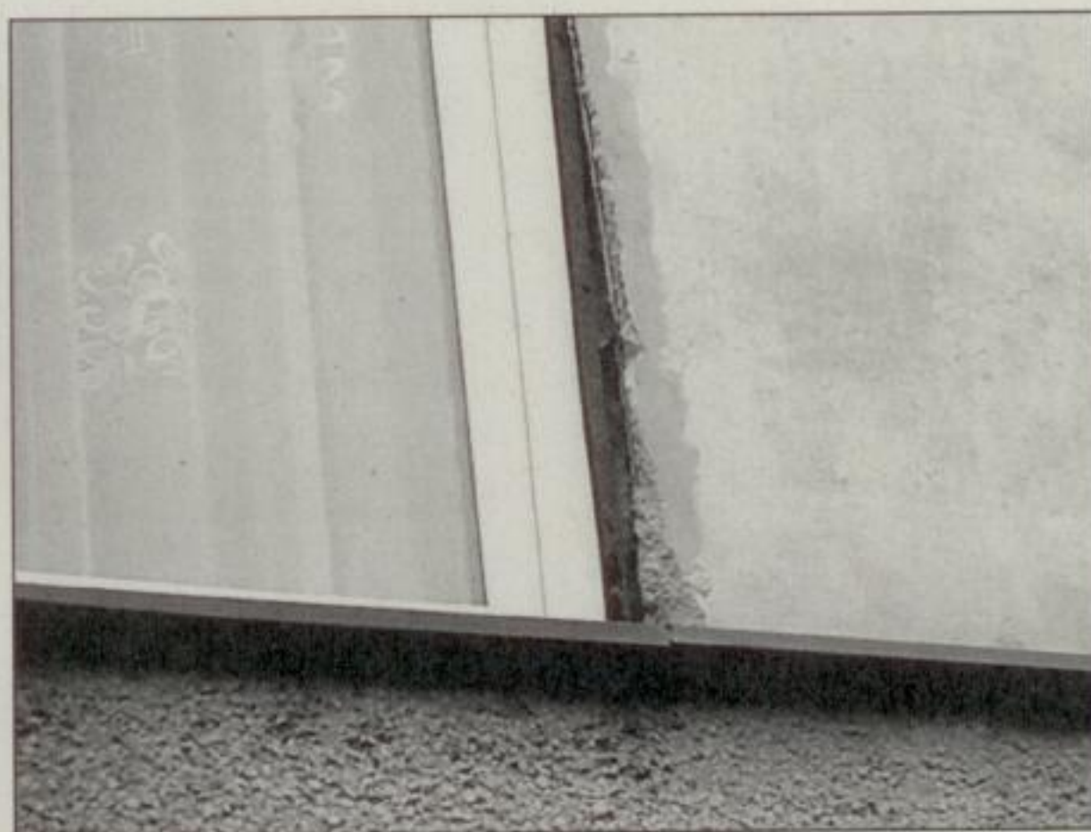
č. 8 - 10 Detaily utěsnění štěrbin okolo rámu oken
