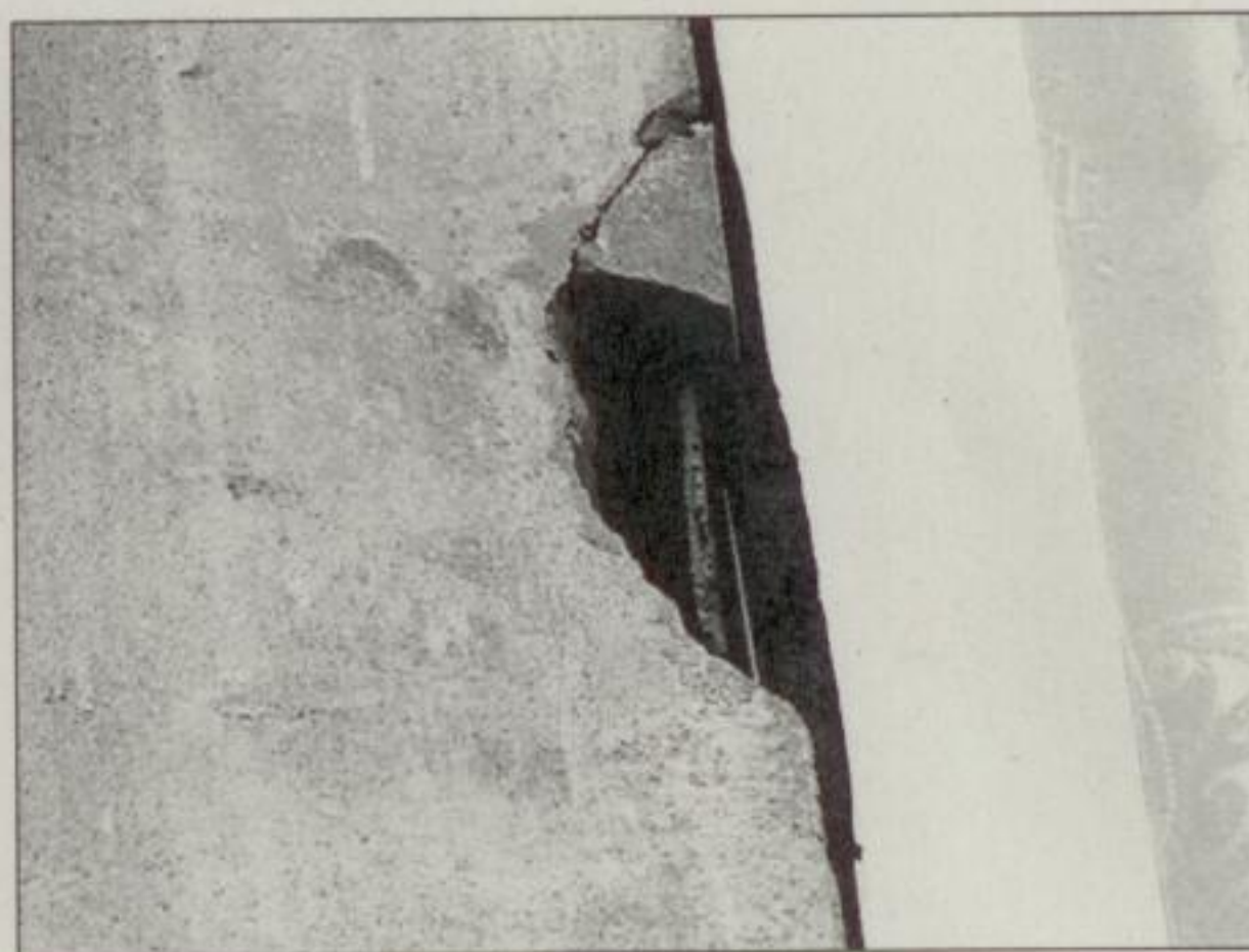
č. 8 - 10 Detaily utěsnění štěrbin okolo rámu oken
