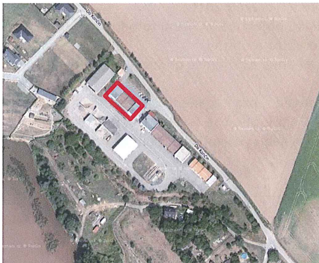
Obr. 2: Letecký pohled na administrativní budovu SÚS KHK Jaroměř (zdroj: mapy.cz)
