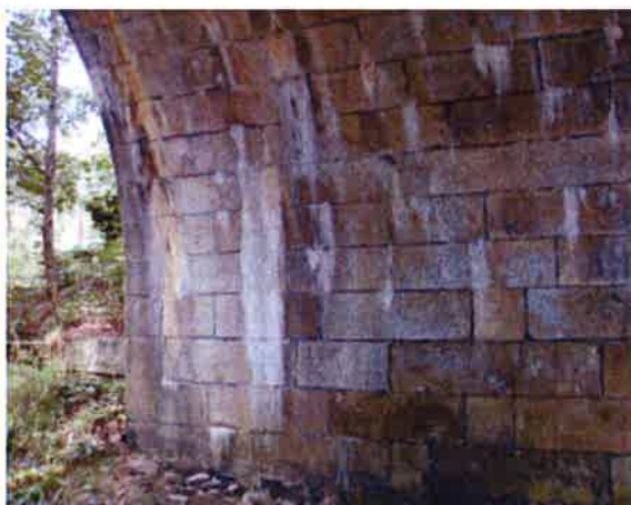
vápenité výluhy mezi kvádry opěry na konci mostu
