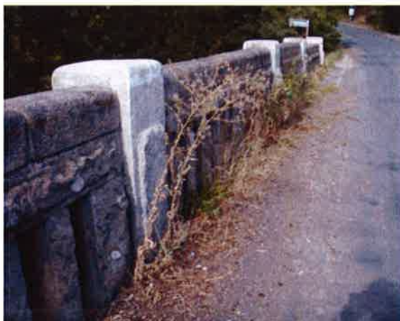
humínózní zemina a zakořeněná vegetace v kraji vozovky vlevo
