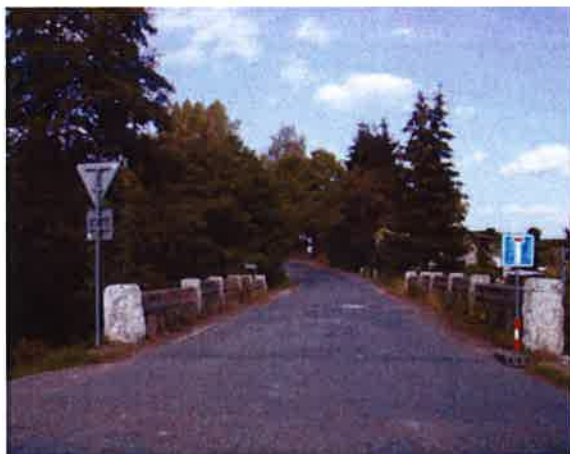
pohled ve směru staničení
