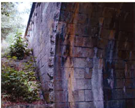
protékání mezi kvádry klenby na konci mostu vlevo
