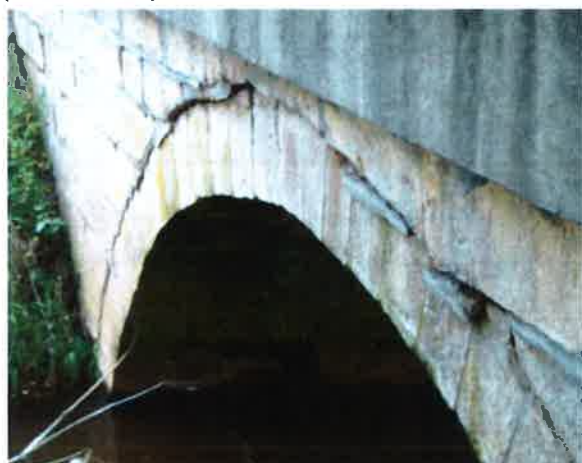
vypadané spárování a mírně vysunutě zdivo čelní zdi nad klenbou vpravo
