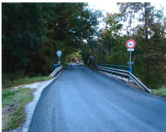
pohled ve směru staničení
