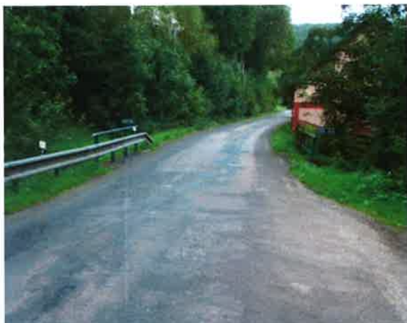
pohled ve směru staničení
