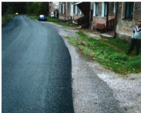
svažující se krajnice k obytnému domu před mostním objektem vlevo - nebezpečí nárazu do domu !!!
