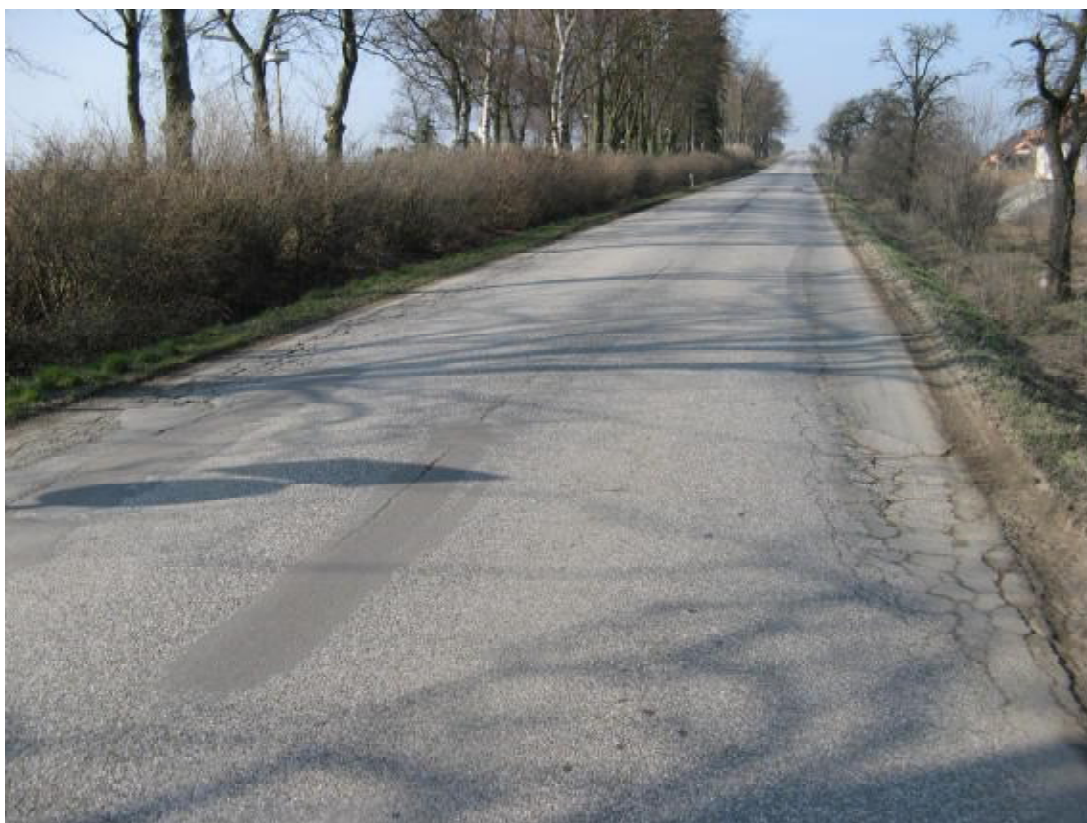
F44, km 5,390+ Výrazné plošné deformace a síťové trhliny podél obou okrajů.
