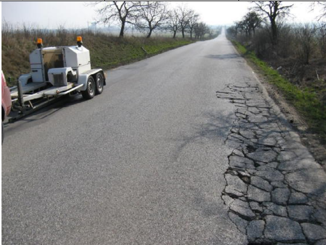
F80, km 7,110- Plošné deformace a síťové trhliny.
