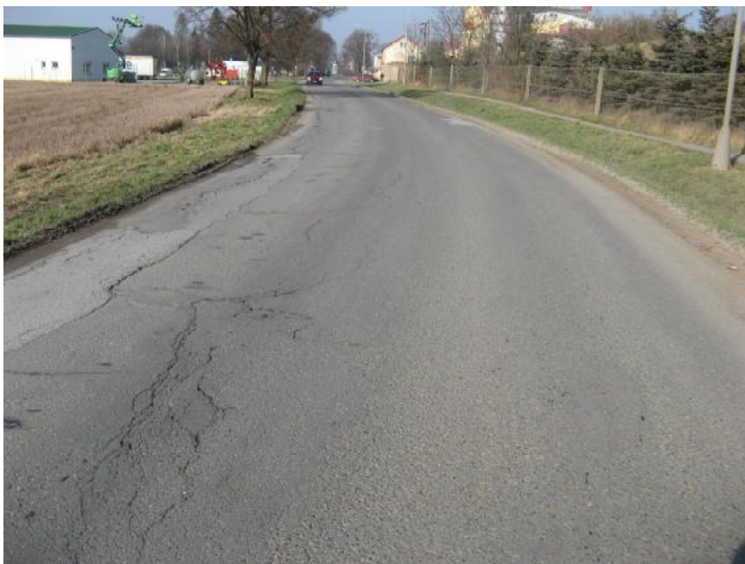
F08, km 4,310+ Vlevo plošné deformace.
