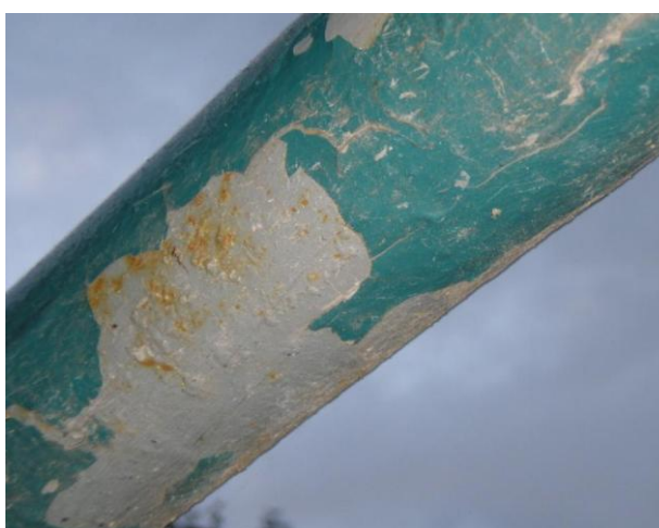
detail počínající koroze zábradlí
