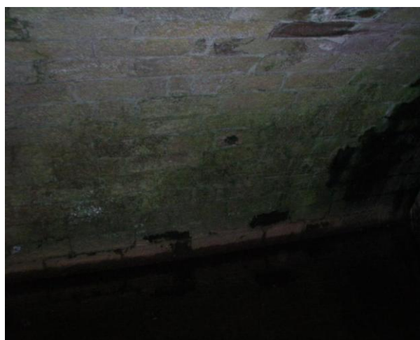
vypadané spárování mezi kvádry klenby
