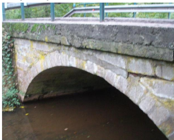
degradovaný beton římsy a chybějící spárování vpravo
