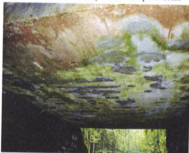
Podhled 1.části mostovky zleva
