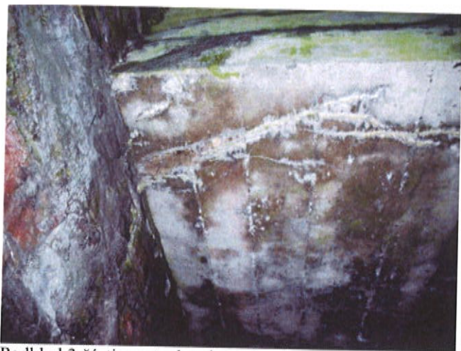
Podhled 3.části mostovky zleva-detail
