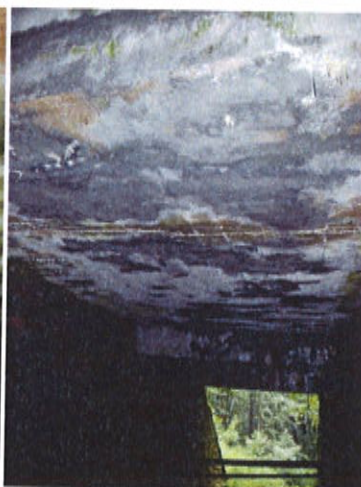
Podhled 2.části mostovky zleva
