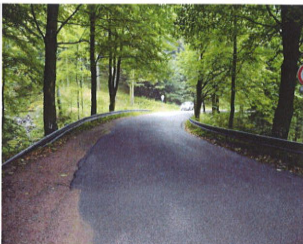
Pohled proti směru staničení
