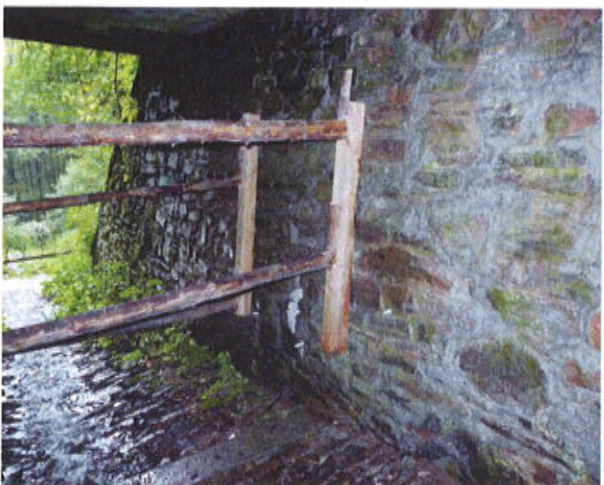
Rozepřené opěry vlevo-detail
