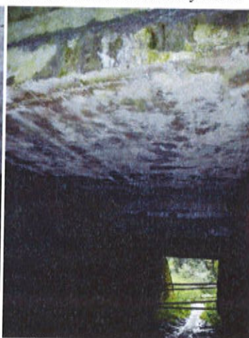
Podhled 3.části mostovky zleva
