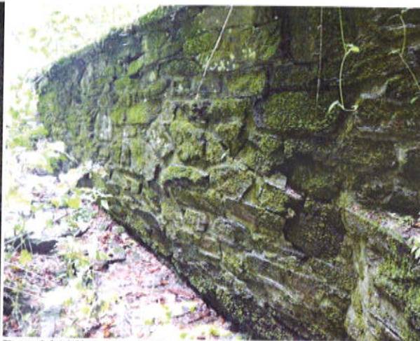
Pravé křídlo na začátku mostu
