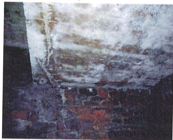
Podhled 2.části mostovky zprava-detail
