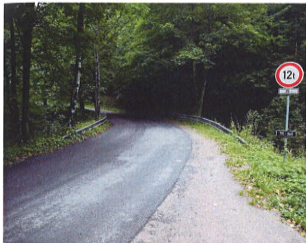
Pohled ve směru staničení
