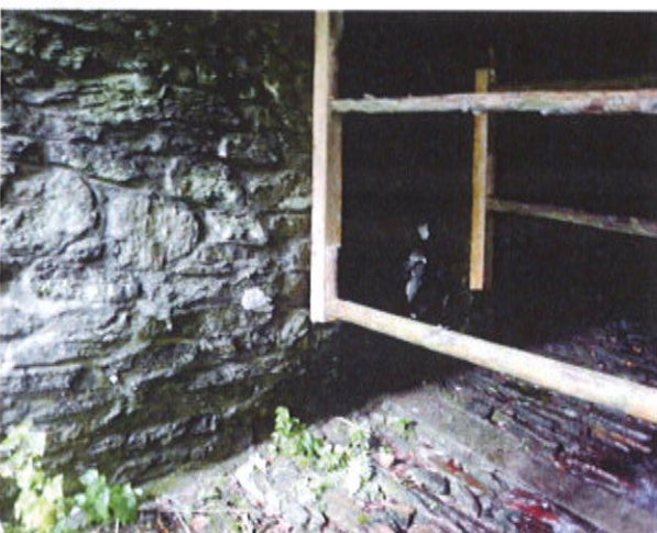
Rozepřené opěry vlevo-detail
