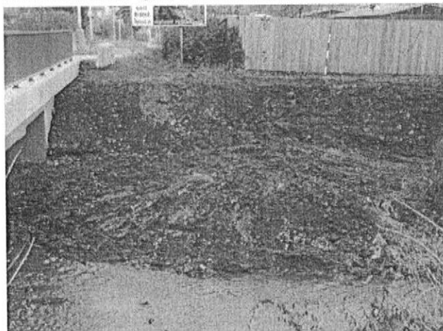
Terénní úpravy okolí stavby
