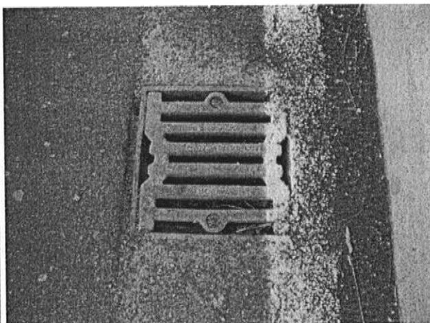
Vpust' odvodňovače na začátku mostu vpravo
