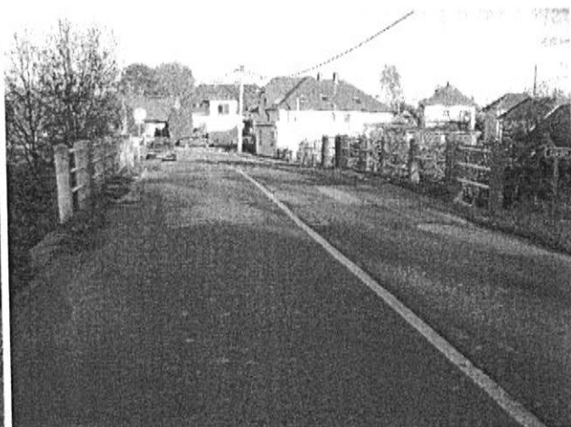
pohled ve směru staničení
