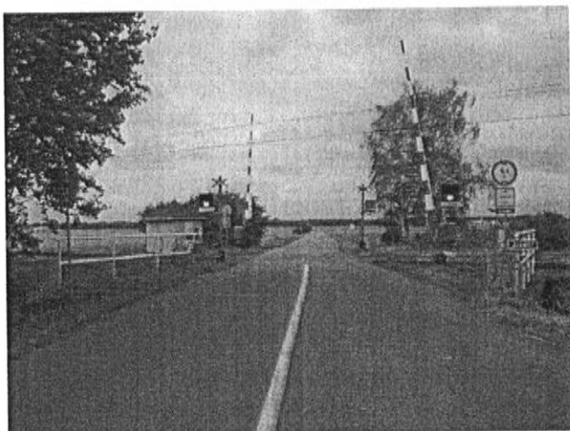
pohled ve směru staničení
