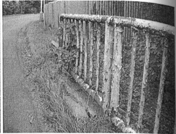
korozí zábradlí
