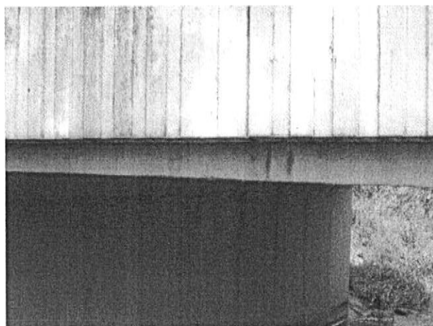
usazené rezavé výluhy na boku NK
