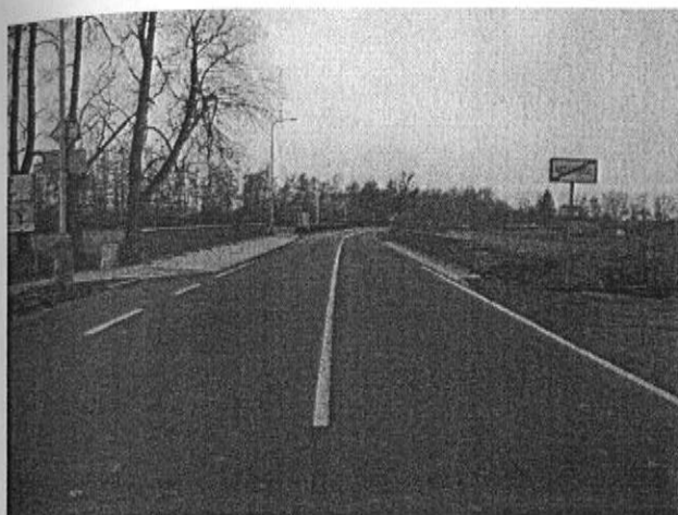
Pohled ve směru staničení
