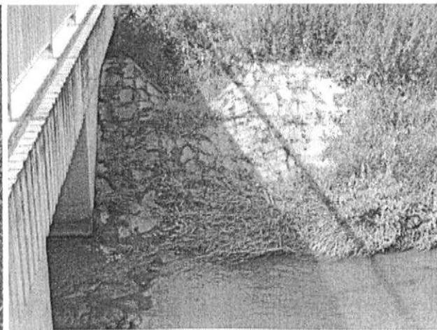
zakořeněná vegetace a mech v kamenném zpevnění svahu
