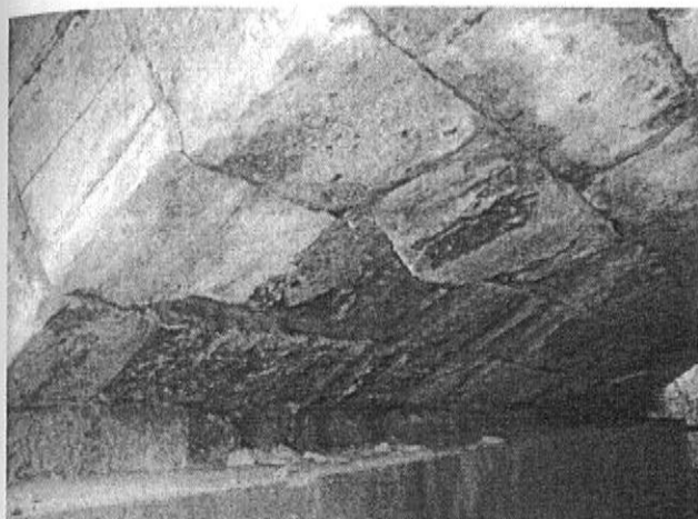
vysunutý kamenný kvádr v pohledu NK 1.most.pole
