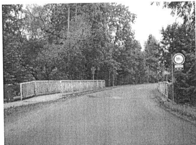
pohled ve směru staničení
