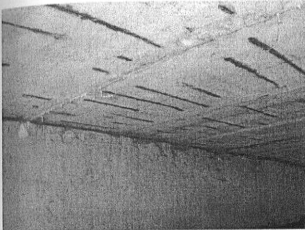
proteklé spáry mezi nosníky s váp.inkrustacemi a krápníky
