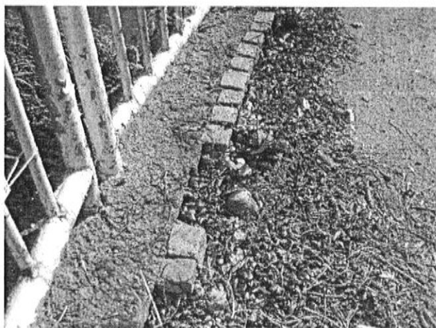
uchycený mech na horní ploše římse;
