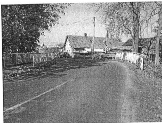
pohled ve směru staničení
