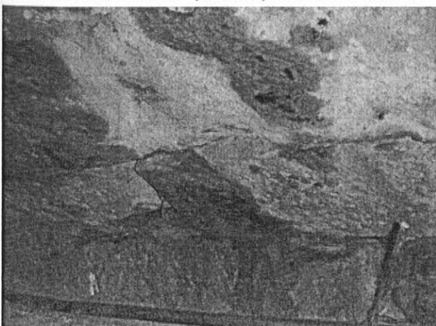
uvolněný ( vysunutý ) kamenný kvádr klenby
