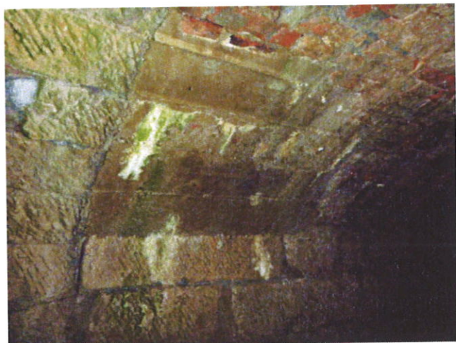
průsaky na začátku vpravo
