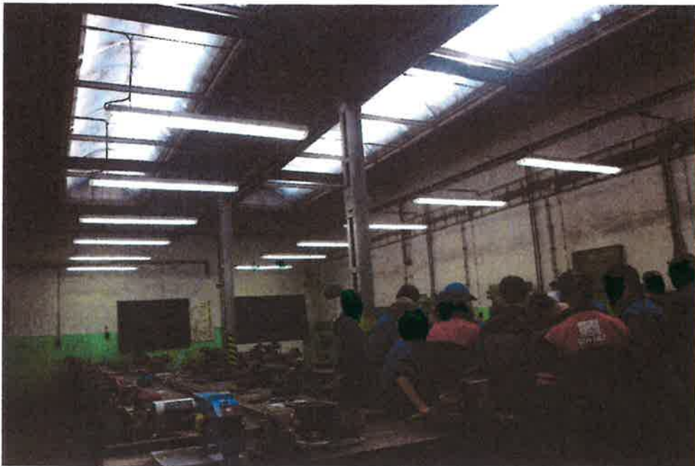
Provizorní nedostatečné zateplení stropů
