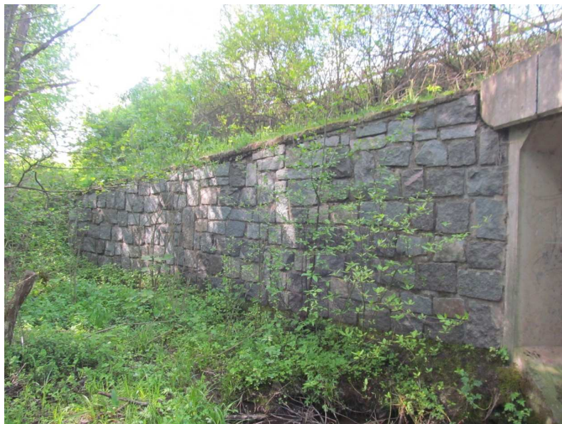
Křídlo vyžděné z kamenných kvádrů na pravé straně u opěry OP1.
