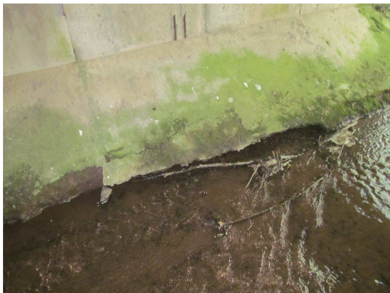
Poškozené betonové opevnění koryta.
