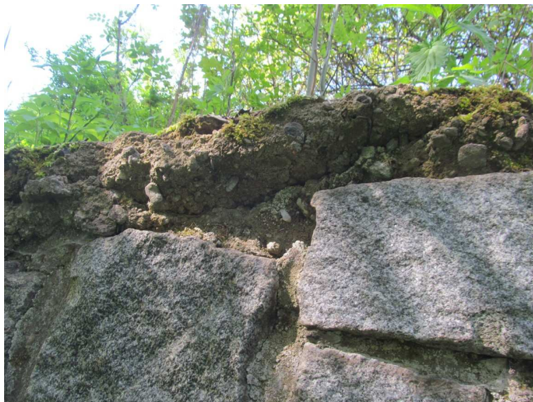
Rozpad monolitické betonové římsy na horním líci kamenných křídel.
