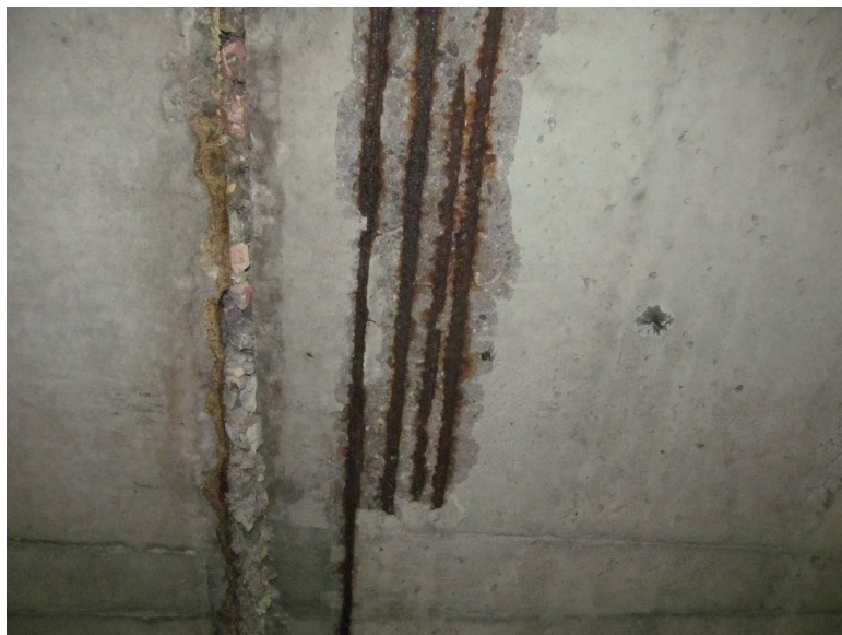
Odpadlá krycí vrstva, koroze betonářské výztuže.
