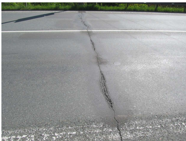
Příčná trhлина ve vozovce.
