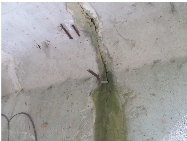
Stopy po průsacích ve sparách mezi prefabrikovanými rámy.
