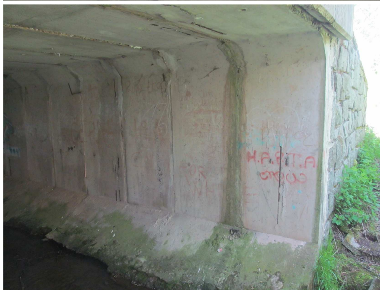
Zatékání ve spáře mezi segmenty, výluhy pojiva.
