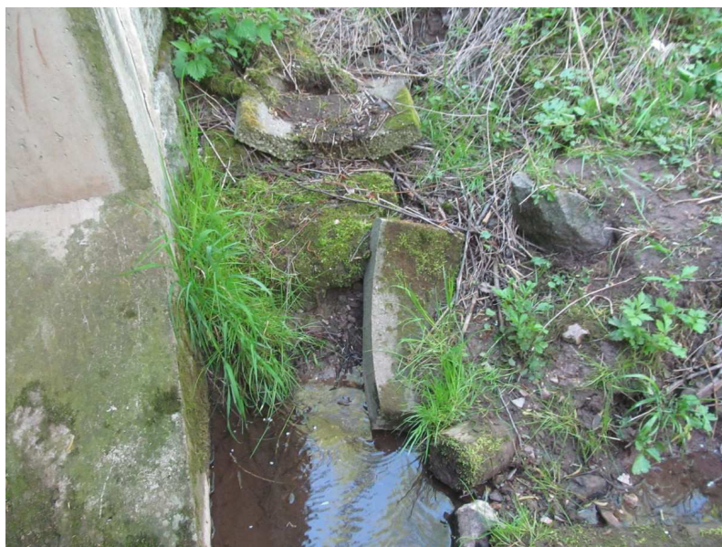
Rozpadlé odvodňovací žlabovky na levé straně mostu u opěry OP1.
