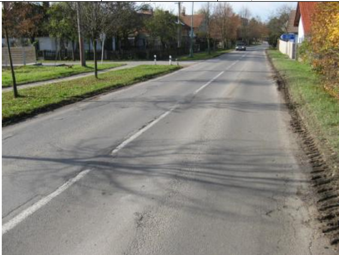
F13B, km 8,140- Vyjeté koleje, podélná, podélná trhlina uprostřed.
