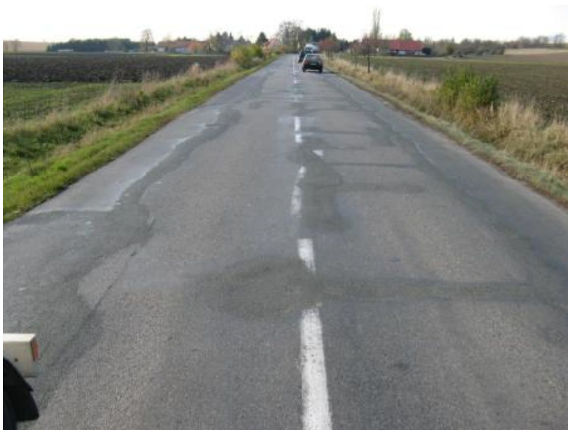
F18, km 12,860- Velkoplošné vysprávký podél okrajů vozovky, příčné trhliny ošetřené tryskovou metodou.
