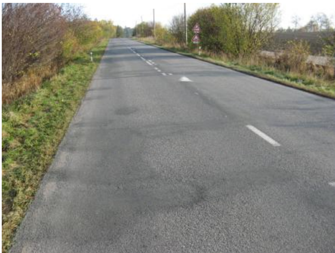
F09, km 4,210+ Příčné trhliny, koroze, rozvětvené trhliny podél okrajů.
