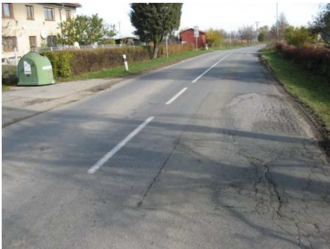
F19, km 8,420+ Síťové trhliny a plošné deformace ve vysprávce.
