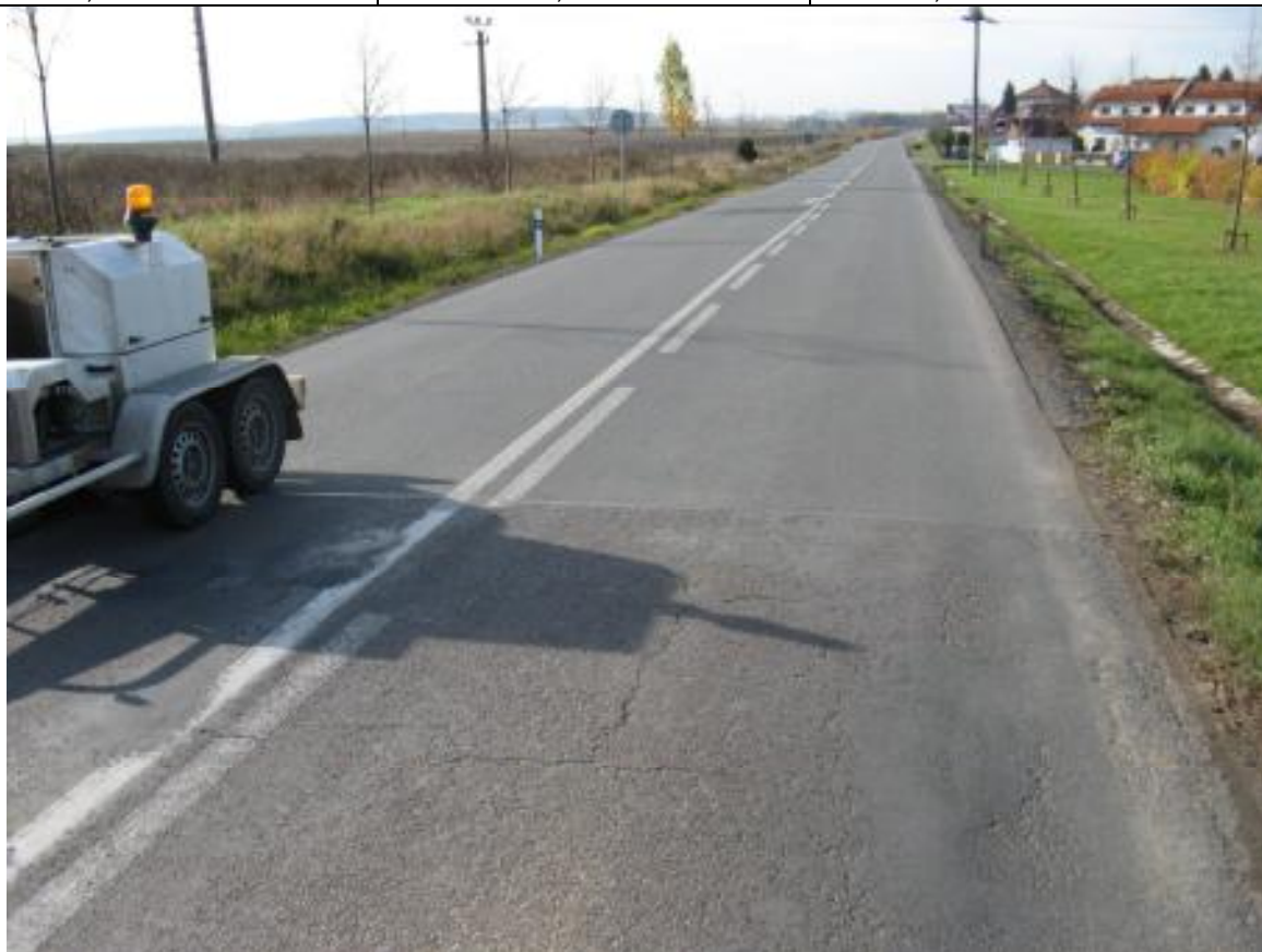
F01, km 7,510- Na začátku úseku. Nepravidelné – mozaikové trhliny.
