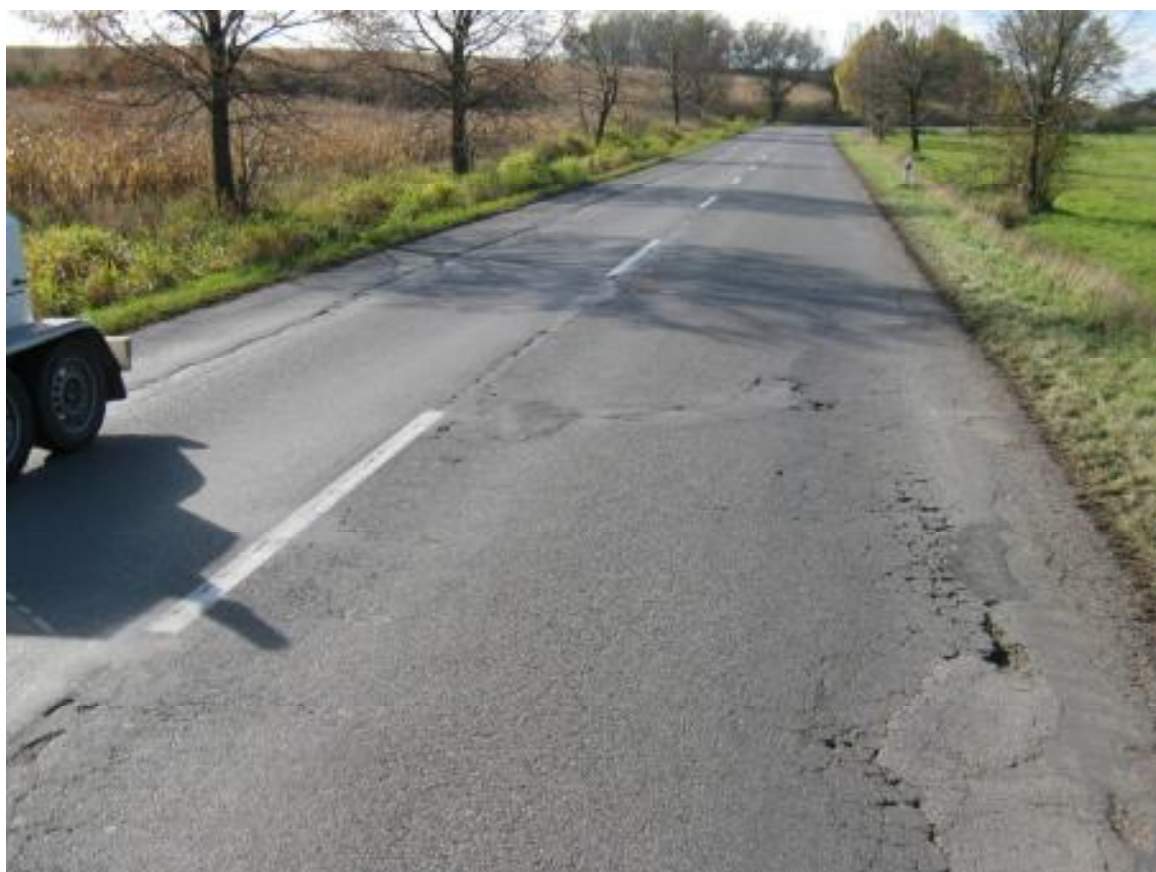
F07, km 9,205- Síťové trhliny a vysprávkky podél okrajů.
