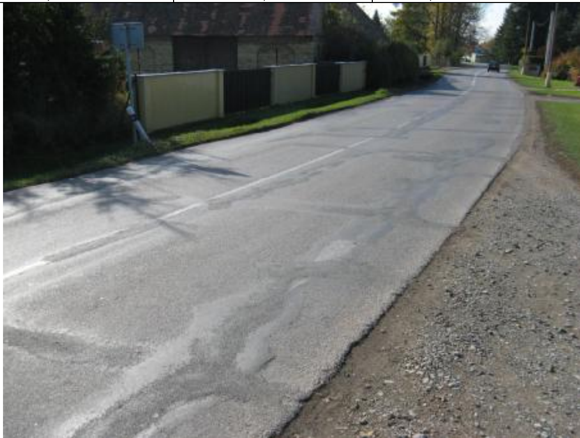
F12, km 12,560- Příčné a podélné trhliny ošetřené tryskovou metodou.
