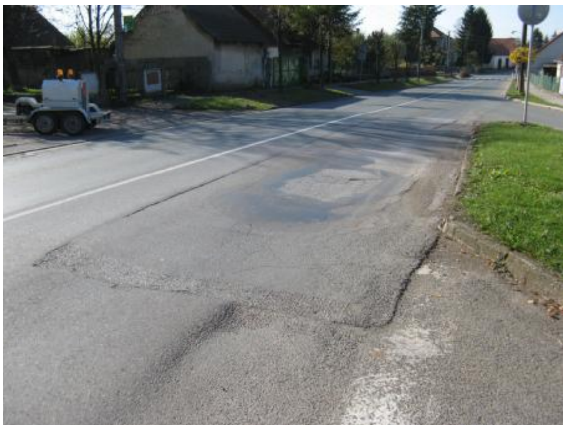
F02B, km 12,060- Vysprávka s plošnými deformacemi a síťovými trhlinami.
