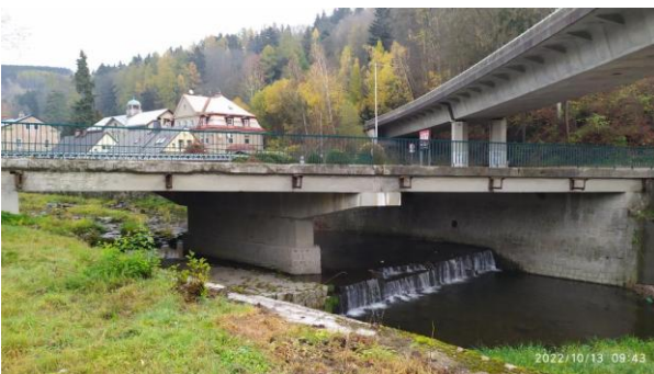
Pohled pravá strana mostu
