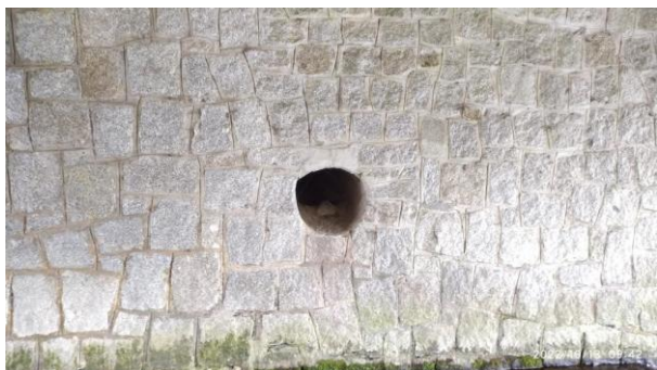
Trubka odvodnění v OP2
