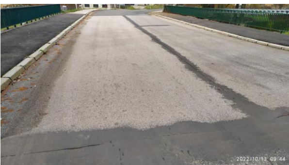
Vozovka na mostě
