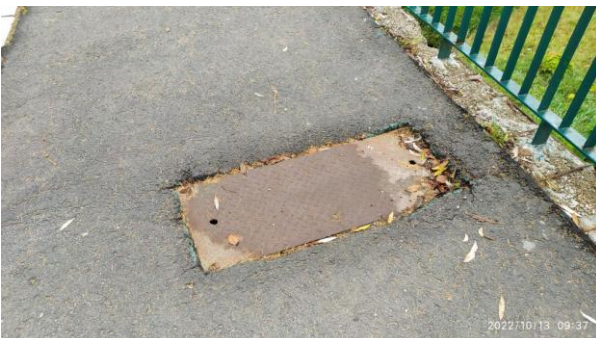
Kryt na chodníku v místě dilatace vpravo na začátku mostu
