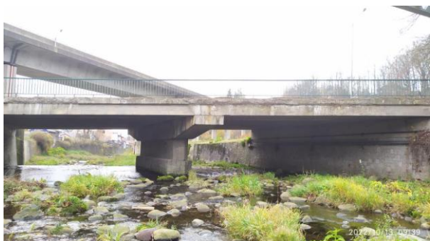
Pohled levá strana mostu
