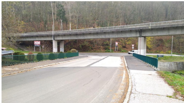
Pohled ve směru staničení
