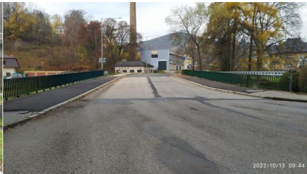
Pohled proti směru staničení
