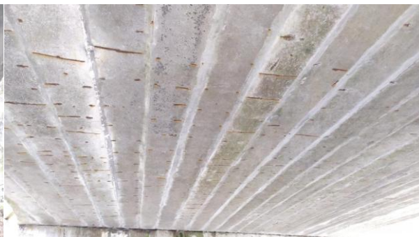
Podhled 2. mostní pole
