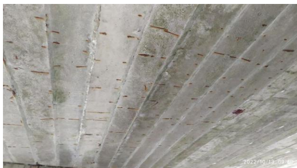
Pohled 1. mostní pole
