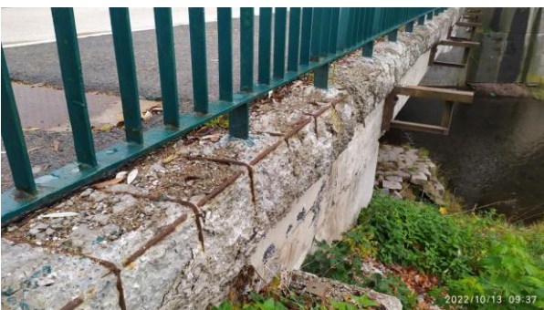
Rozpad římsy vpravo
