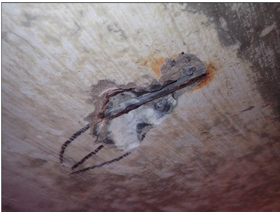
Foto 4: Detail sondy M1 – Semidestruktivní sonda do předpjetého nosníku v 1/2 rozpětí, viditelný 1 prut smykové výztuže (třmínek) o průměru 6 mm, hladká výztuž, krytí 0 až 10 mm, rozteč nedestruktivně 210 až 260 mm
