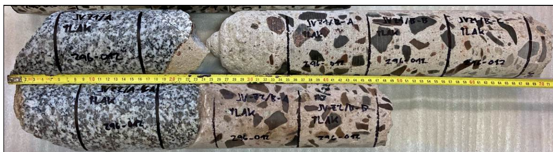
Foto 2: Pohled na vývrty Z1 a Z2 – první části vývrtnů tvořeny horninou, zbytek vývrtnu je tvořen betonem základů opěr
