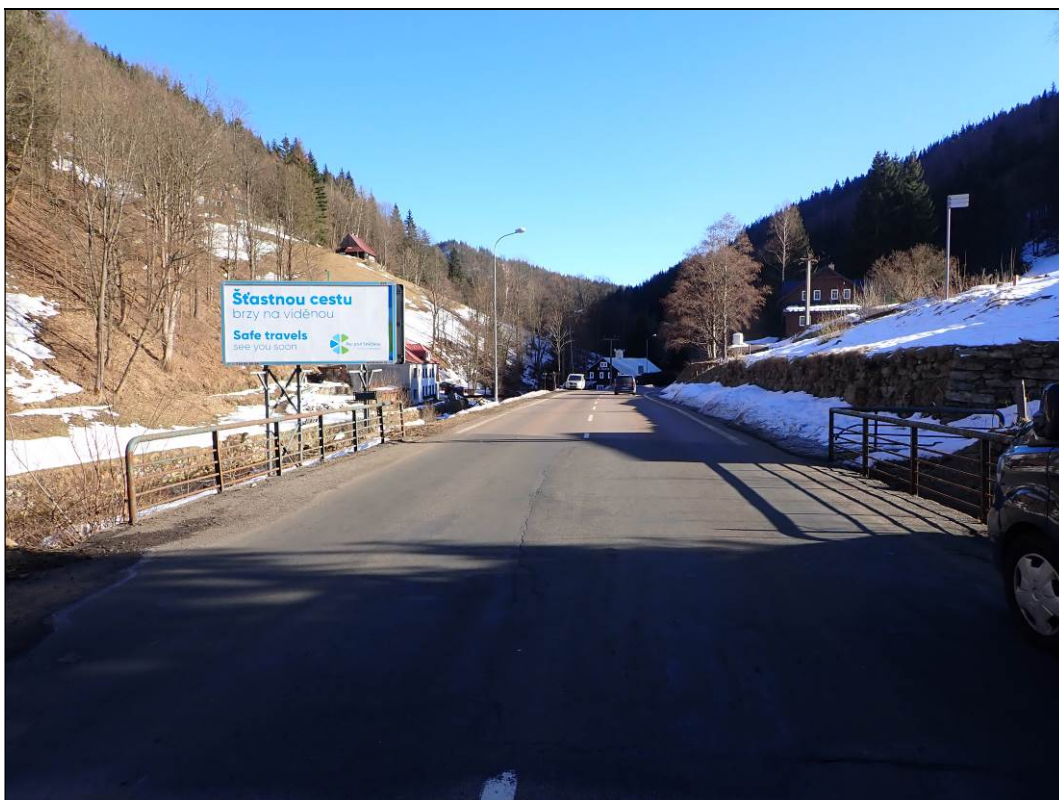
Foto. 1: Pohled na mostní konstrukci ev. č. 296-012 ve Velké Úpě.
