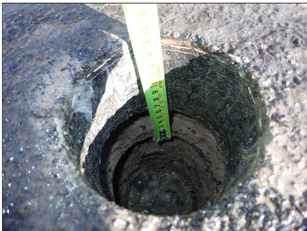
Foto 1: Pohled do vrtu V7 pro stanovení skladby vozovky v ½ délky mostní konstrukce (na fotografii měřeno po nalezenou hydroizolaci).
