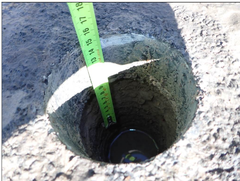
Foto 1: Pohled do vrtu V6 pro stanovení skladby vozovky na začátku mostní konstrukce (na fotografii měřeno po nalezenou hydroizolaci).
