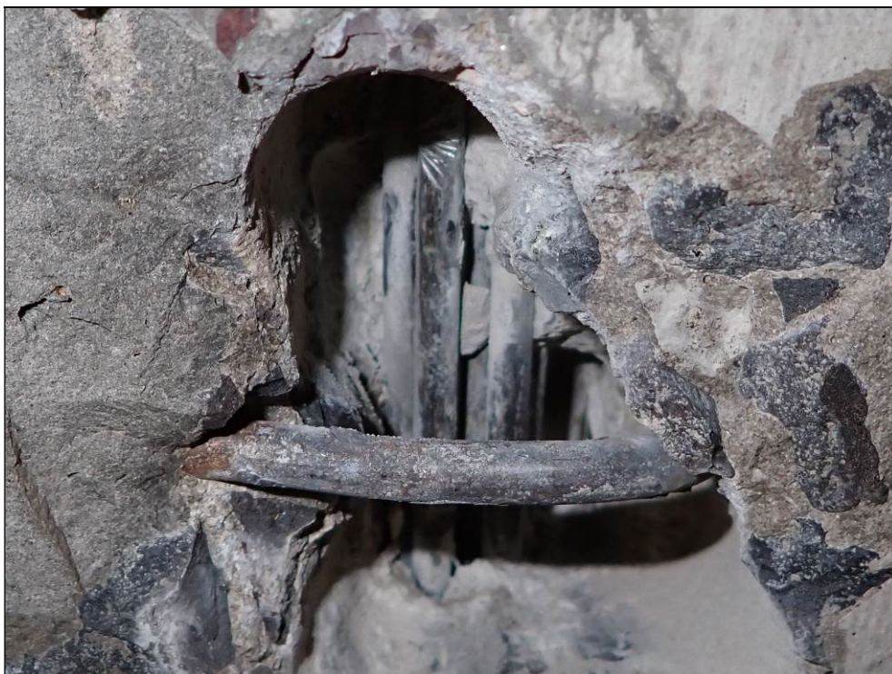
Foto 4: Detail sondy M2 – Semidestruktivní sonda do předpjatého nosníku v \frac{1}{2} rozpětí, viditelný 1 prut smykové výztuže (třmínek) o průměru 6 mm, hladká výztuž, krytí 10 mm
