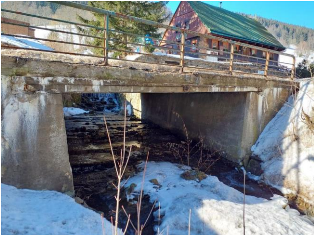
pohled na most zprava
