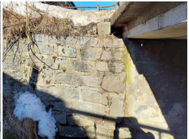
navazující opěrná zed vlevo na konci
