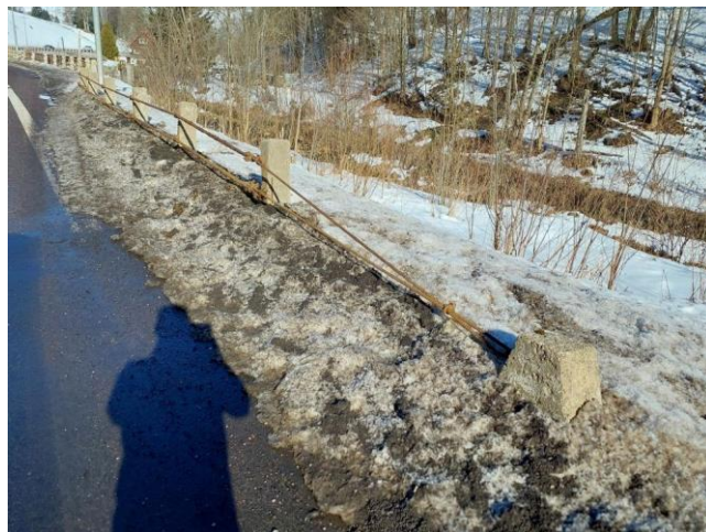
navazujici lanove svodidlo na konci mostu
