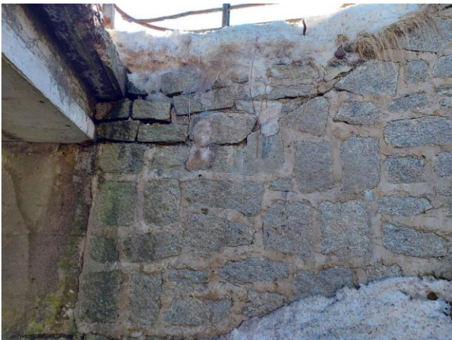
navazující opěrná zed vlevo na zacatku
