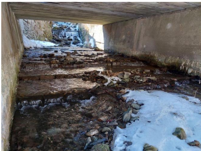
koryto vodotece pod mostem
