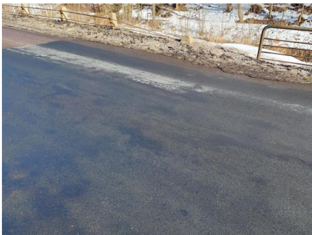
vozovka na konci mostu, podelna trhlina
