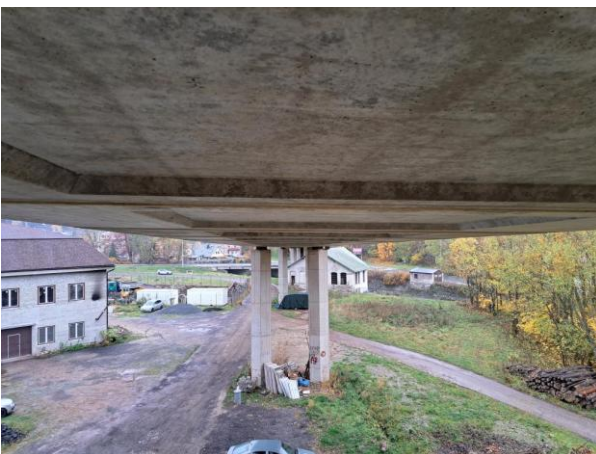
podhled nK_mostní pole č. 3
