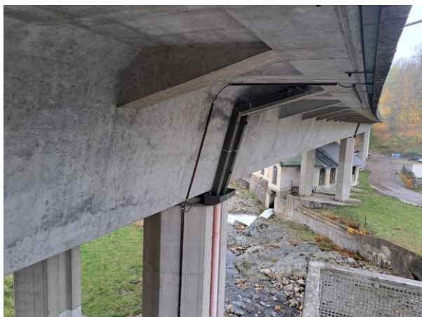
svod odvodnění_pilř P6_vlevo
