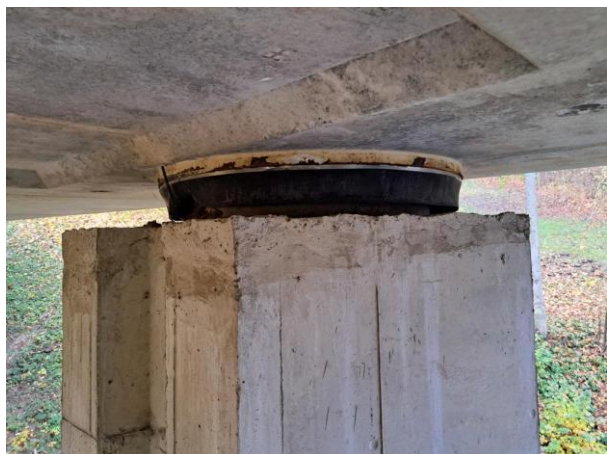
ložisko_pilíř P2_vlevo
