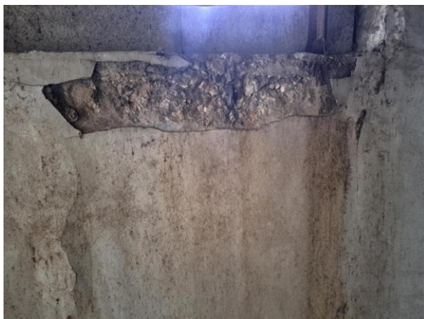
závěrná zídka_vlevo_degradace
