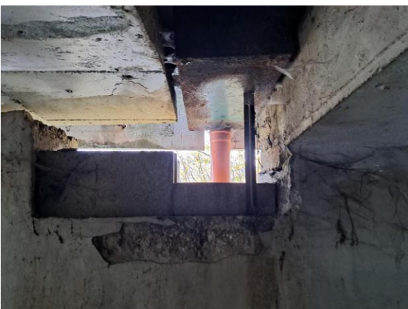
OP8_odvodnění závěru vlevo
