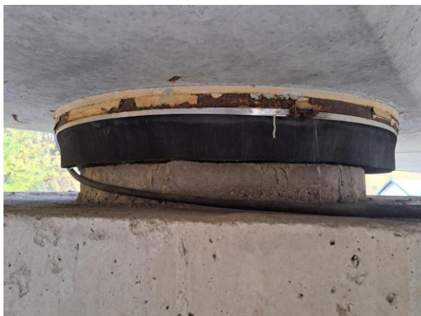
ložisko_pilíř P6_vlevo
