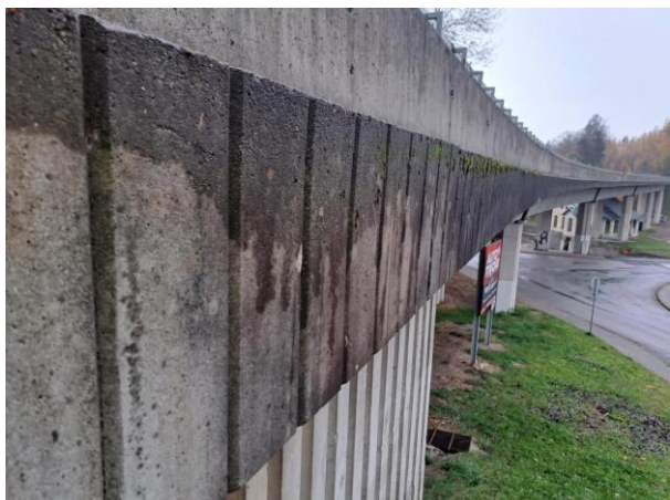
boční líc římsy_levá strana_proti směru staničení
