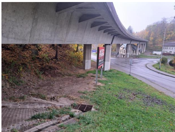
mostní pole č. 7_vlevo_proti směru staničení
