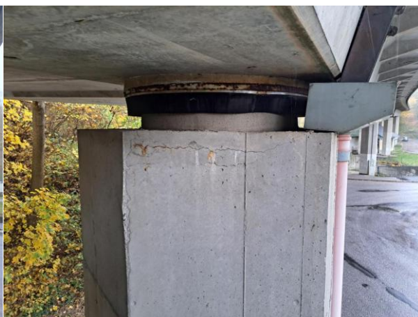
ložisko_P7_vlevo_trhlina_hlava pilíře
