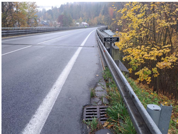
pohled po směru staničení
