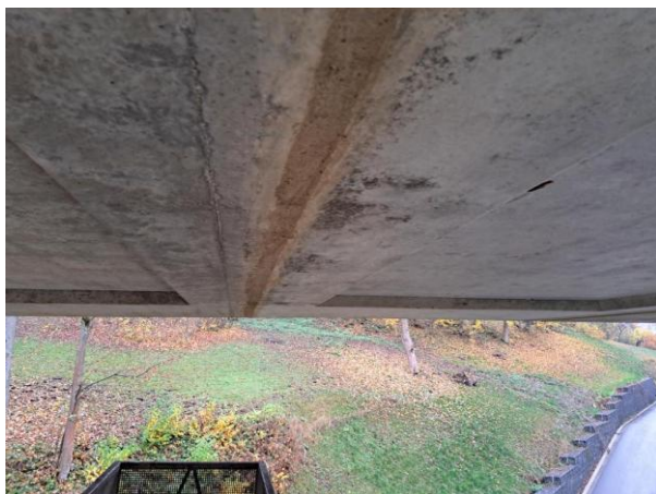
detail příčné spáry prefabrikátů _mostní pole č. 3
