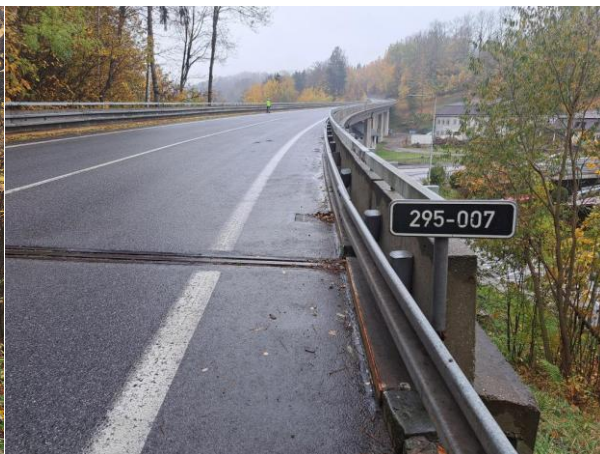
pohled proti směru staničení
