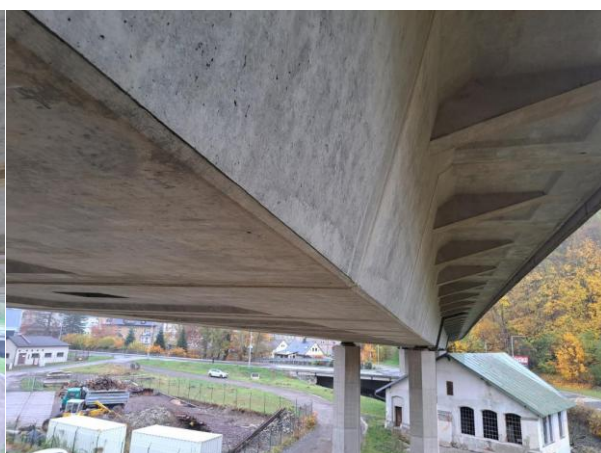
podhled NK _mostní pole č.4_vpravo
