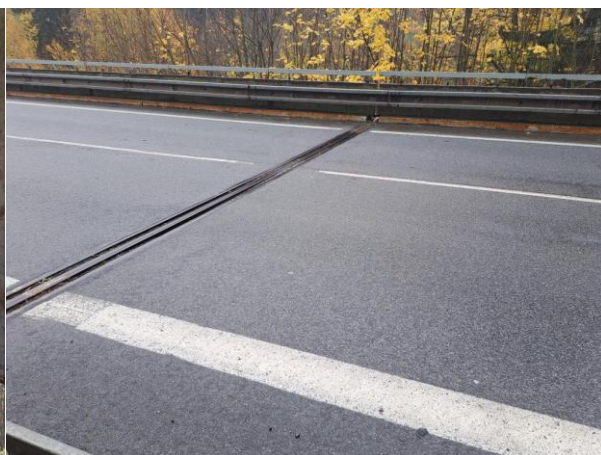
mostní závěr nad OP1
