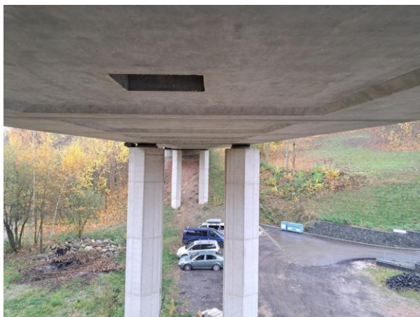
podhled NK_mostní pole č. 4
