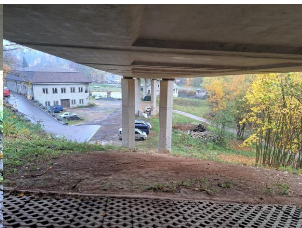
podhled NK_mostní pole č. 1
