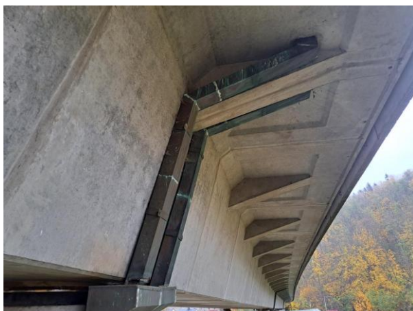
svod odvodnění _pilíř P3_vpravo
