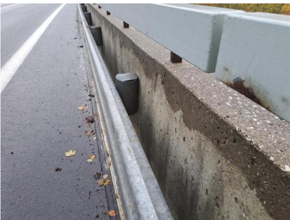
zábradelní svodidlo vpravo
