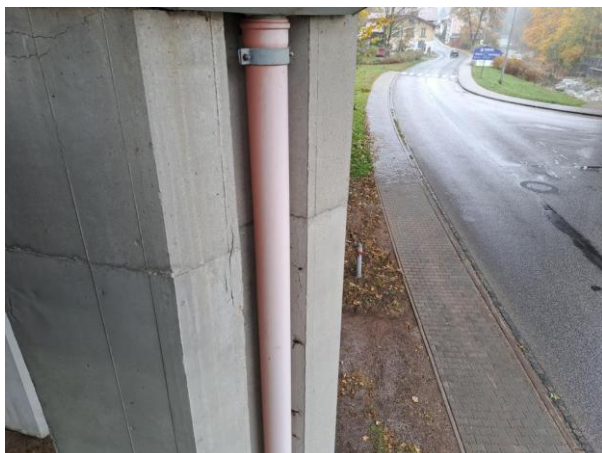
svod odvodnění_pilř P7_vlevo
