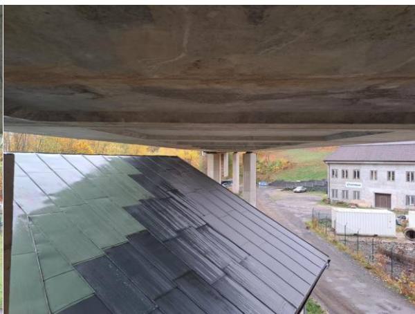
podhled NK_mostní pole č. 4
