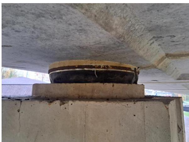
ložisko _pilíř P3_vlevo
