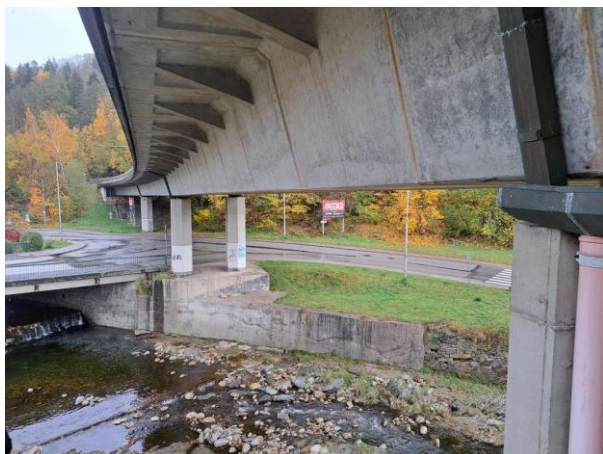
lic NK_mostní pole č. 5_vlevo
