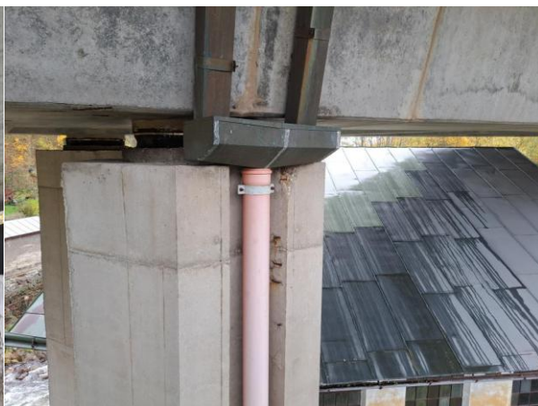
svod odvodnění_pilíř P5_vlevo
