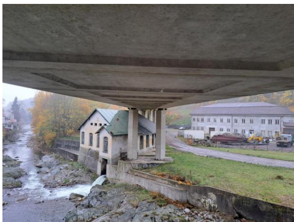
podhled NK_mostní pole č. 5
