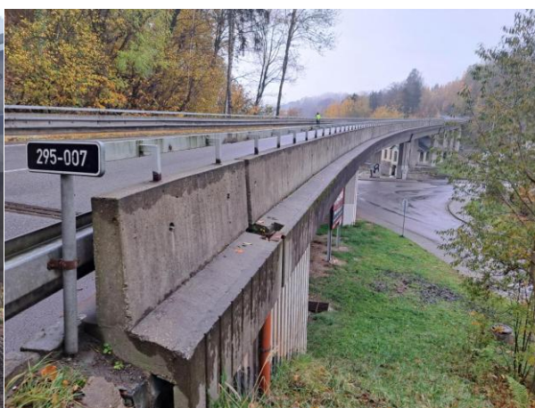
boční pohled_levá strana_proti směru staničení
