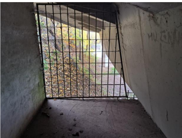
OP8_líc NK_pravá strana_proti směru staničení
