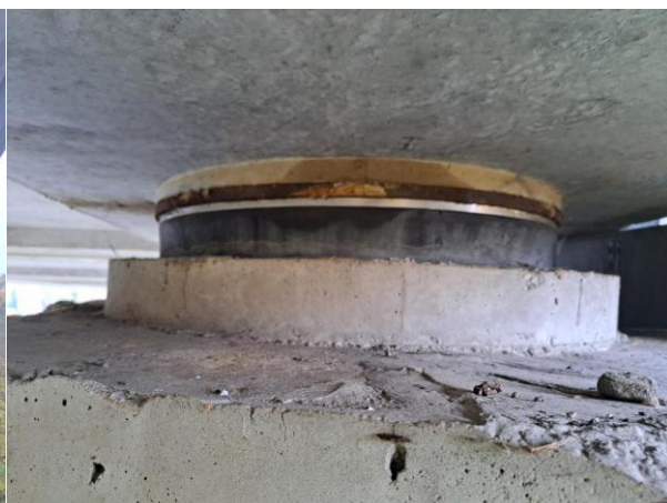
ložisko _pilíř P3_vpravo
