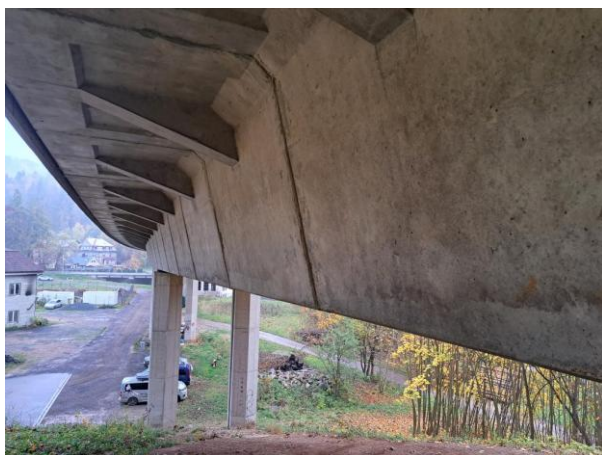
podhled NK_mostní pole č. 1_levá strana
