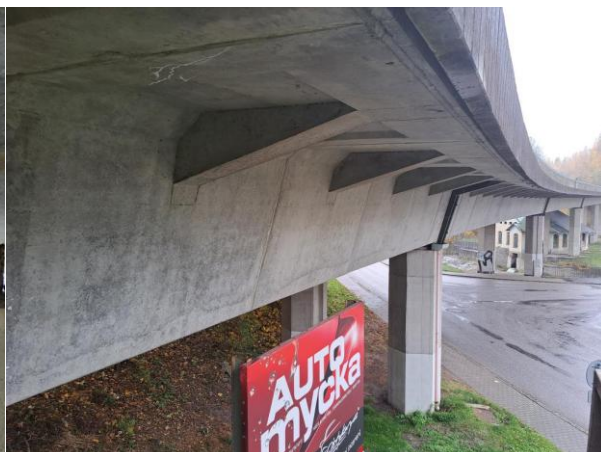
podhled NK_mostní pole č. 7_vlevo
