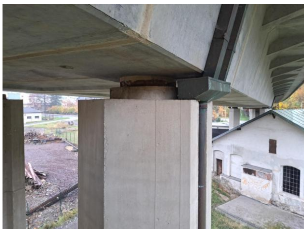
svod odvodnění_pilíř P4_vpravo
