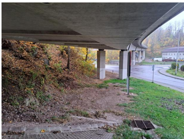
podhled NK_mostní pole č. 7
