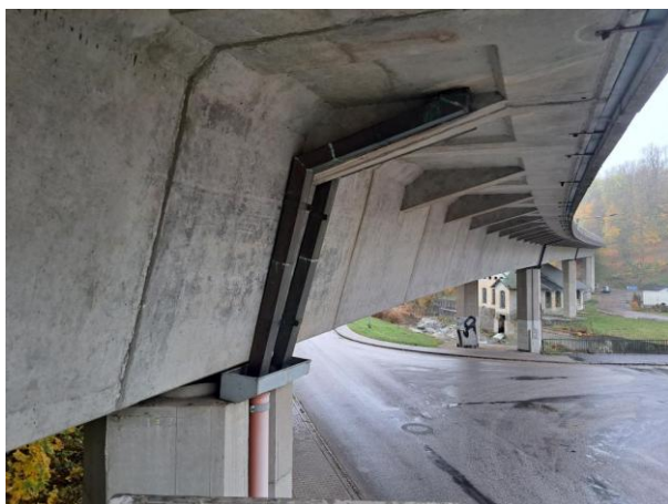
sovd odvodnění_pilíř P7_vlevo
