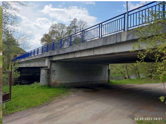
Pohled na pravý bok proti směru staničení
