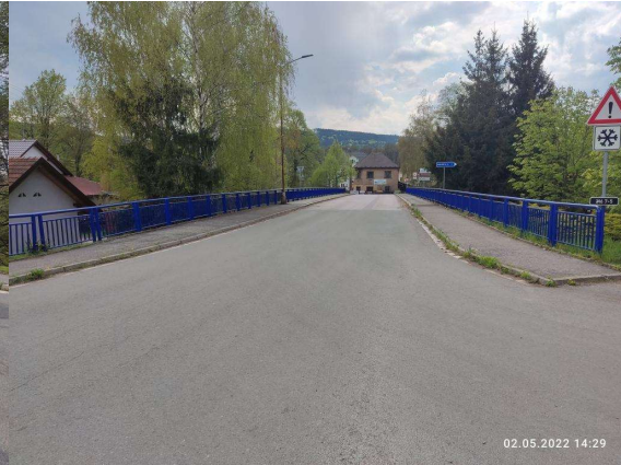
Pohled proti směru staničení
