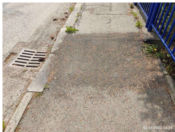
Levý chodník na konci mostu
