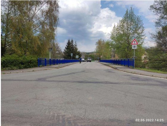
Pohled ve směru staničení
