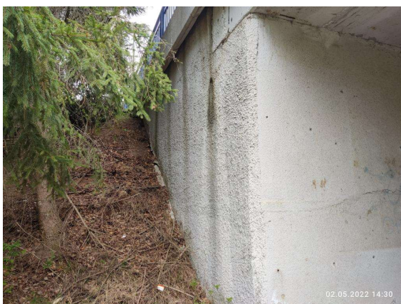
Levé křídlo na konci mostu (K2)
