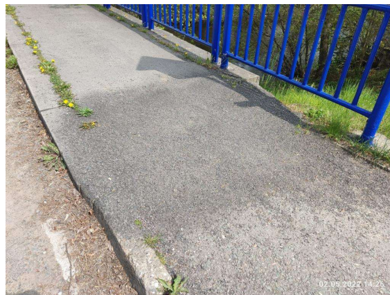
Pravý chodník na začátku mostu
