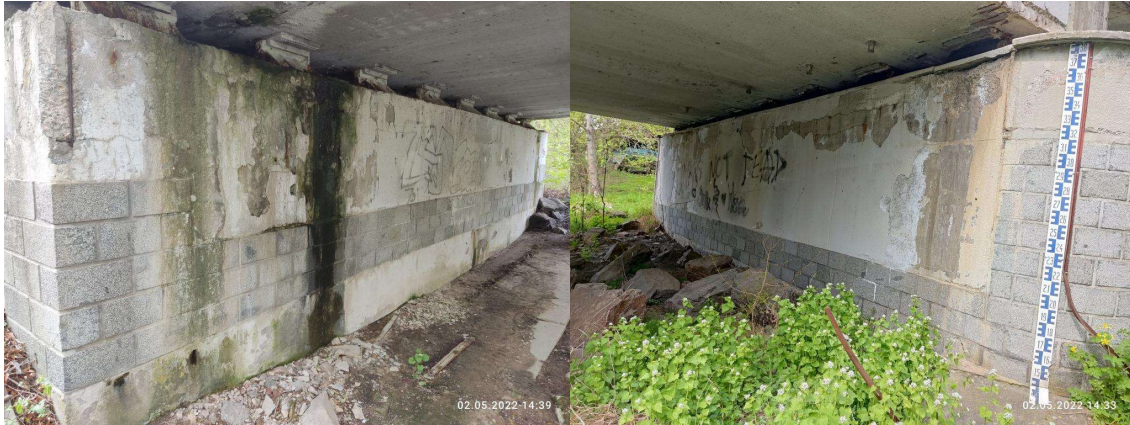
Pohled na opěru OP1 na začátku mostu zprava
