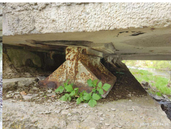
Ložiska na opěře OP1
