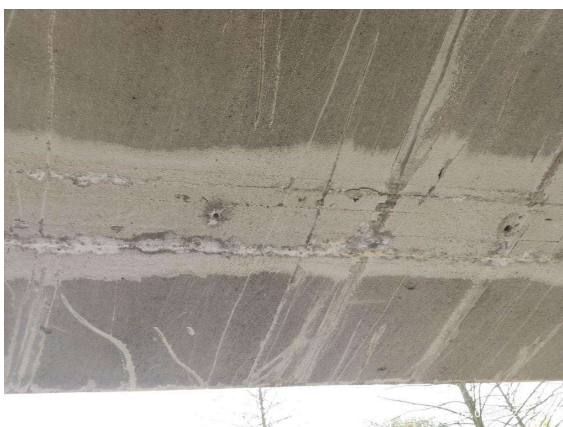
Podhled NK vlevo 2.pole
