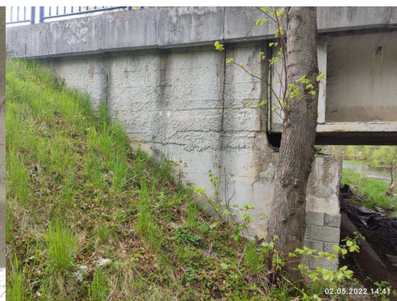
Pravé křídlo na začátku mostu (K3)
