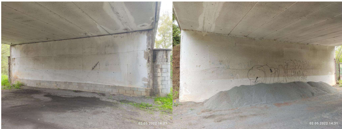
Pohled na podpěru P2 zleva proti směru staničení
