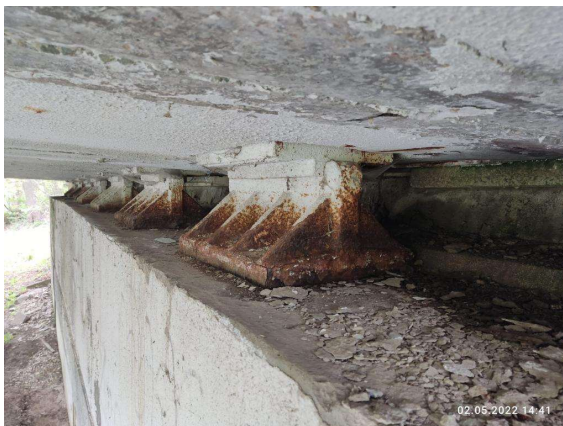
Stav ložisek na opěře OP1
