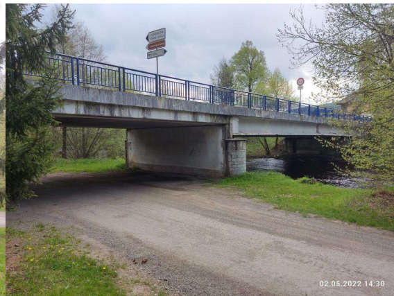
Pohled na levý bok proti směru staničení
