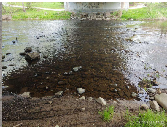
Stav koryta pod mostem ve směru staničení
