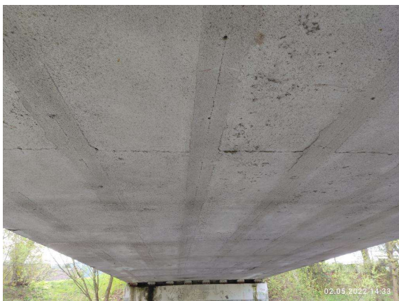
Podhled NK 1.pole proti směru staničení
