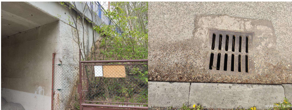
Pravé křídlo na konci mostu (K4)
