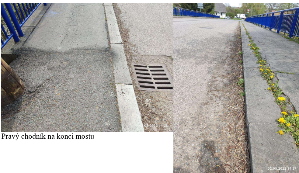
Nános nečistot na pravé krajnici
