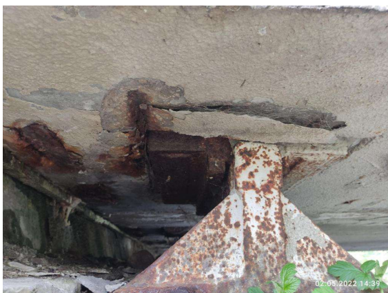
Detail krajního ložiska vpravo
