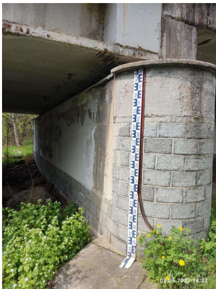
Vodočetná lať vpravo na podpěře P2
