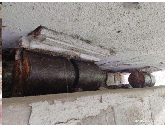
Ložiska na podpěře P2 vpravo
