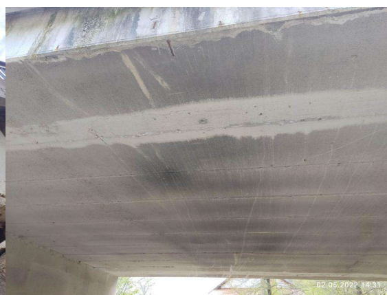
Podhled NK zleva 2.pole
