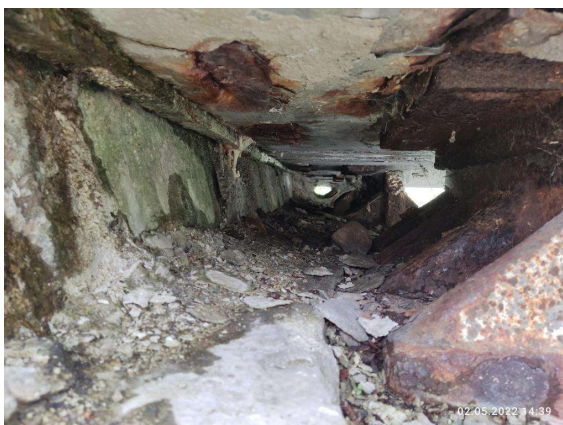
Stav úložného prahu na OP1
