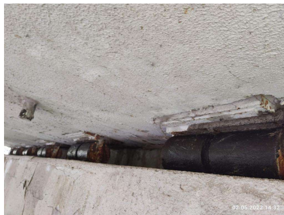
Ložiska na podpěře P2
