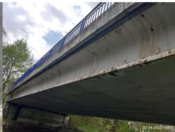
Krajní nosník vpravo 1.pole
