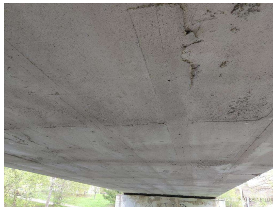
Podhled NK 1.pole ve směru staničení
