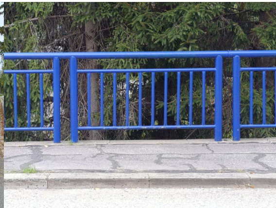
Levé zábradlí 40 ks
