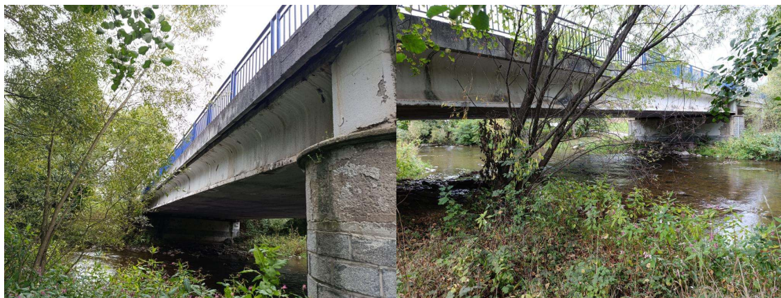
Pravá strana mostu (7)
