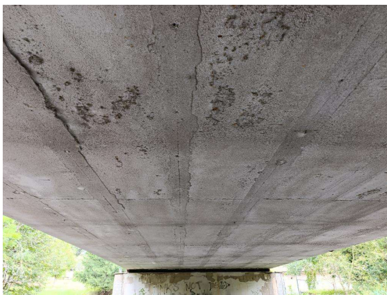
Podhled nosné konstrukce (4)
