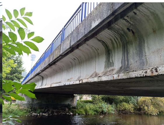
Levá strana mostu
