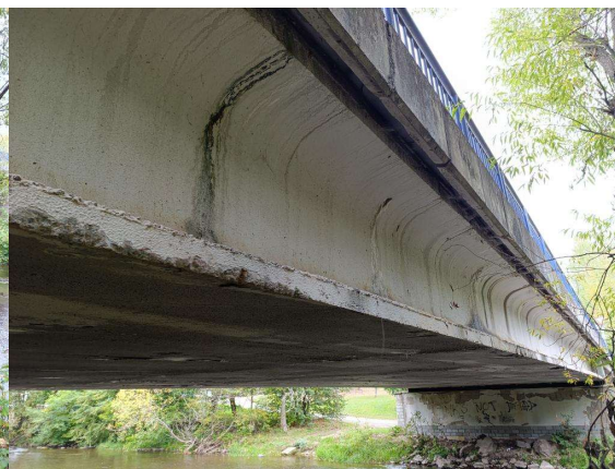
Pravá strana mostu (2)
