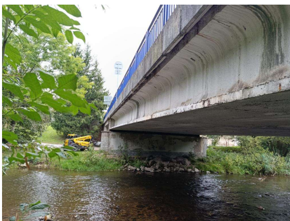
Levá strana mostu (2)
