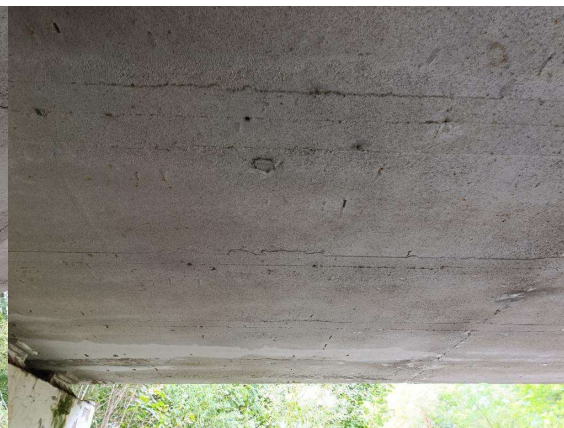
Podhled nosné konstrukce (3)
