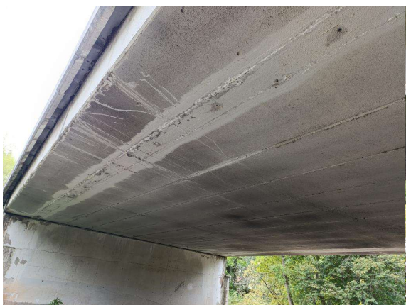
Podhled pole II_
