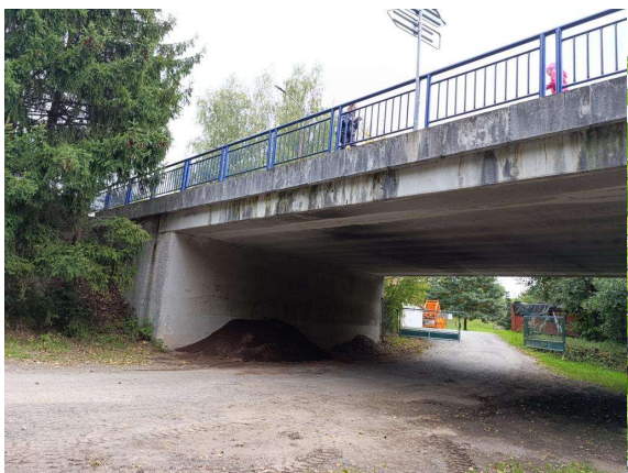
Levá strana mostu (4)
