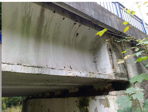
Levá strana mostu (1)
