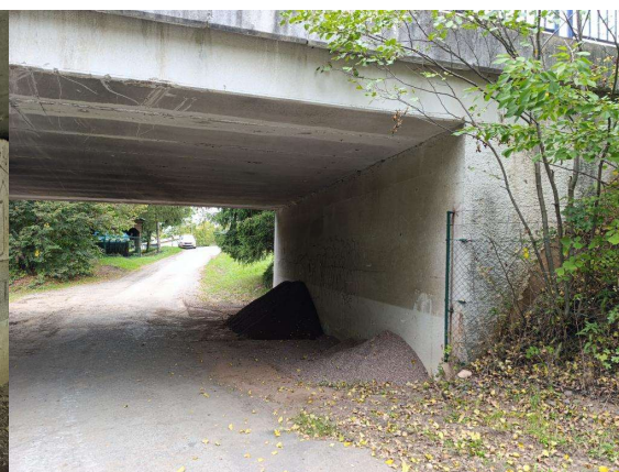
Opěra na konci mostu (1)
