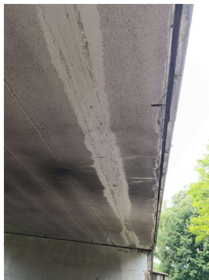
Podhled pole II_ (1)
