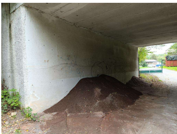
Opěra na konci mostu
