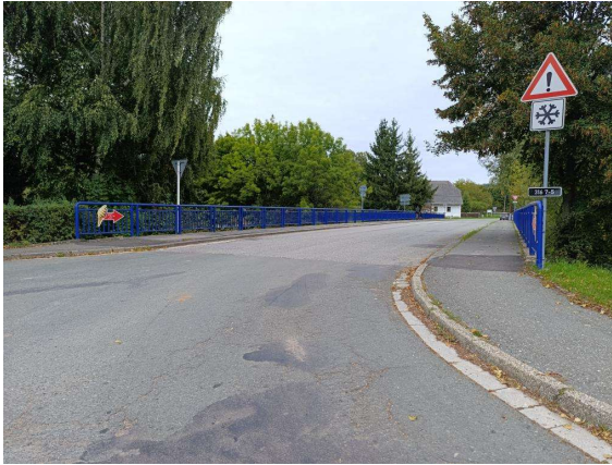
Pohled ve směru staničení
