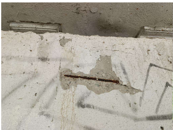
Opěra na začátku mostu (3)
