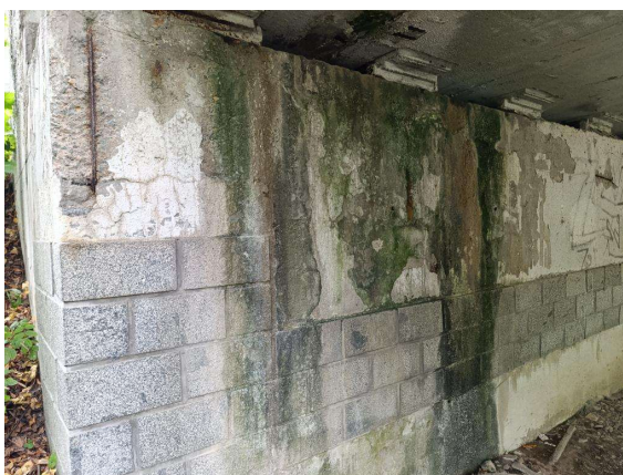
Opěra na začátku mostu
