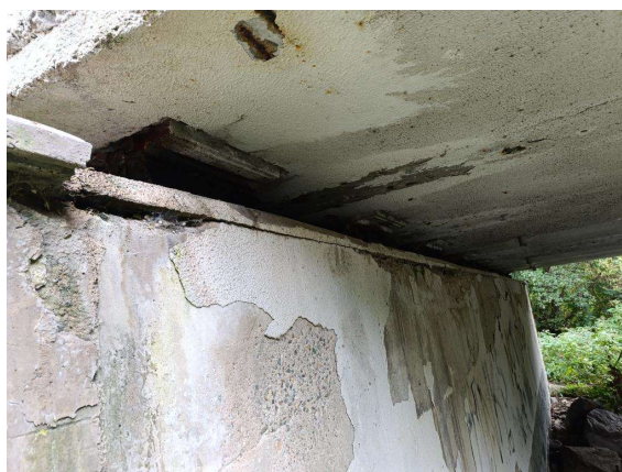
Ložiska nad podperou
