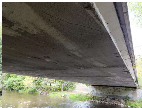
Podhled nosné konstrukce
