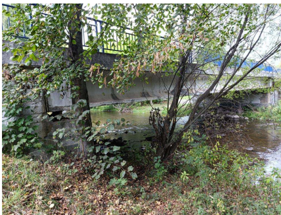
Pravá strana mostu (1)
