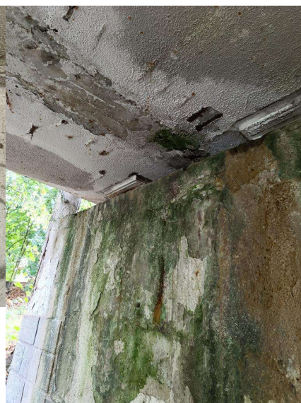
Opěra na začátku mostu (4)
