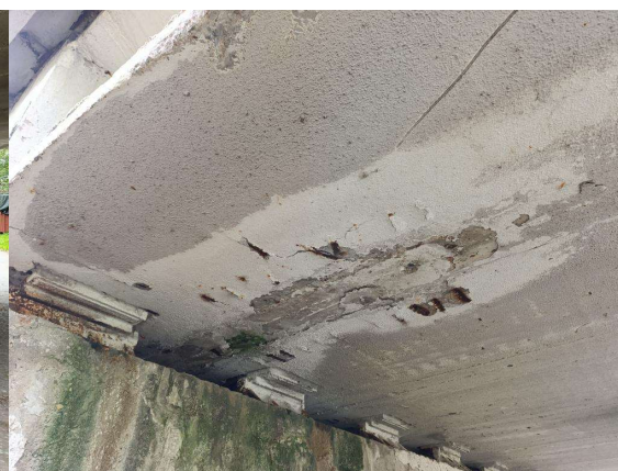
Podhled nosné konstrukce (1)
