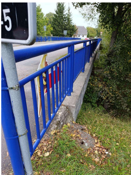
Pravá strana mostu (3)
