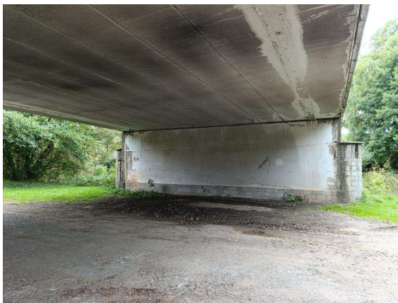
Pohled na podpěru (1)
