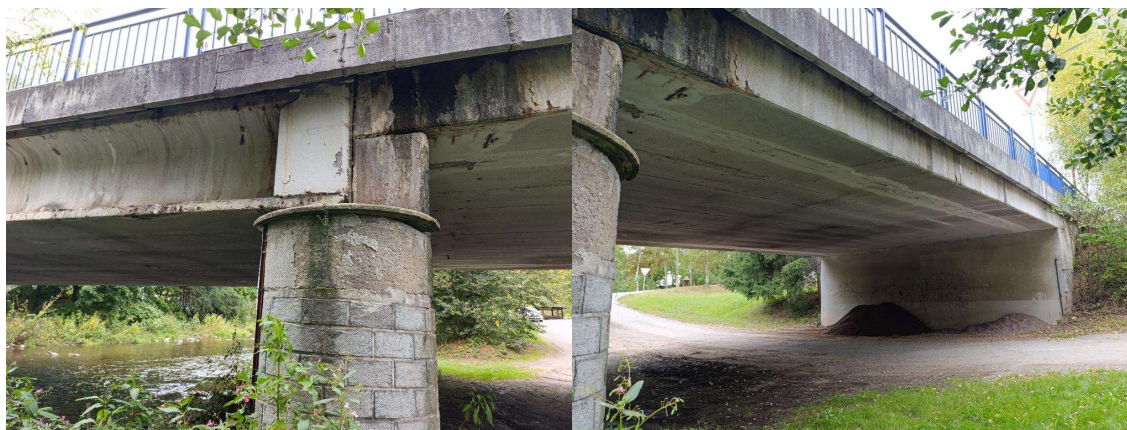
Pravá strana mostu (5)
