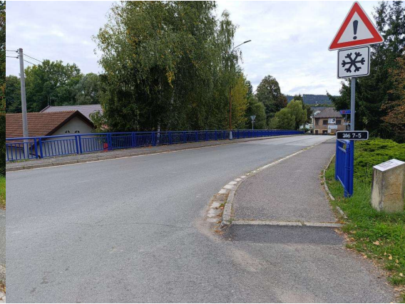
Pohled proti směru staničení
