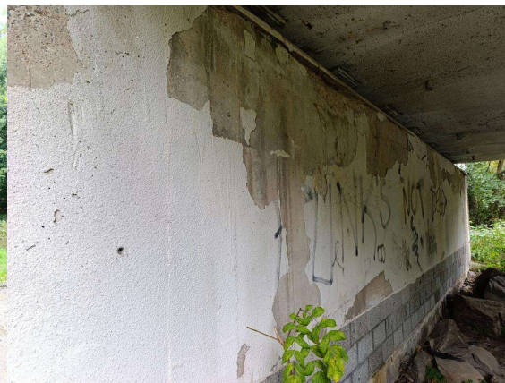
Pohled na podpěru (2)
