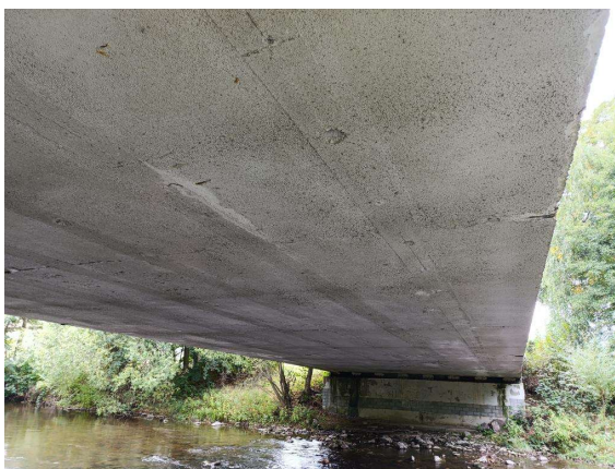
Podhled nosné konstrukce (6)
