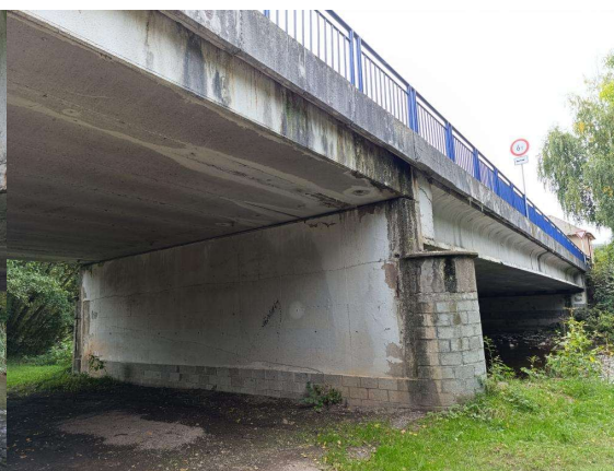
Levá strana mostu (3)
