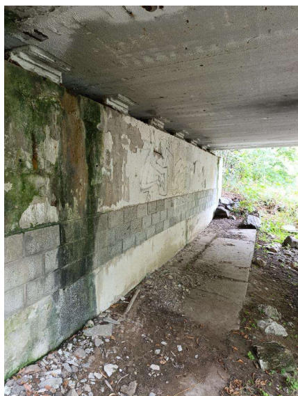
Opěra na začátku mostu (1)
