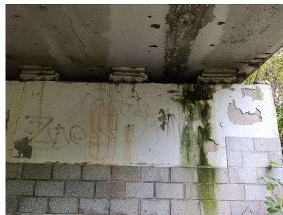
Opěra na začátku mostu (2)
