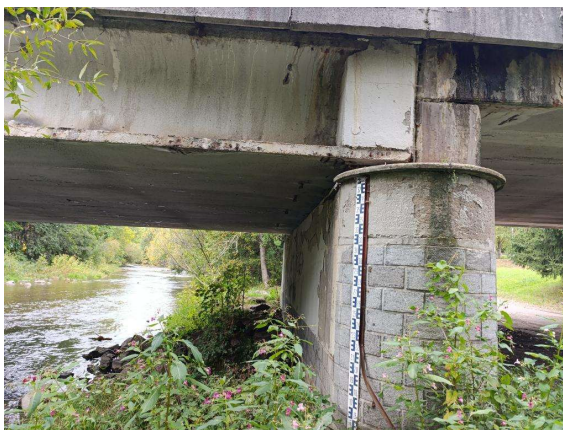
Pohled na podpěru (3)
