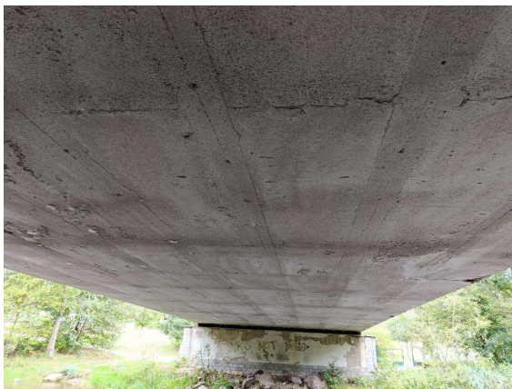
Podhled nosné konstrukce (2)
