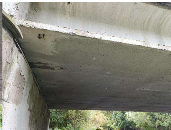
Podhled nosné konstrukce (5)
