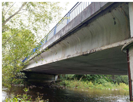
Pravá strana mostu (4)
