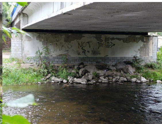
Pohled na podpěru
