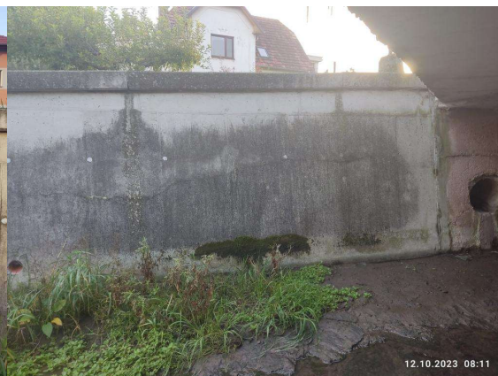
Levé křídlo na konci mostu (K3)
