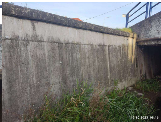
Pravé křídlo na začátku mostu (K2)
