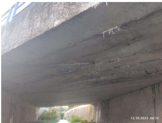
Podhled mostu zleva
