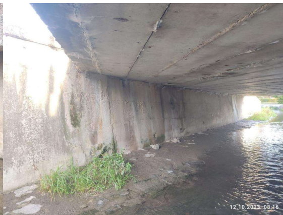
Pohled na opěru OP1 na začátku mostu zprava
