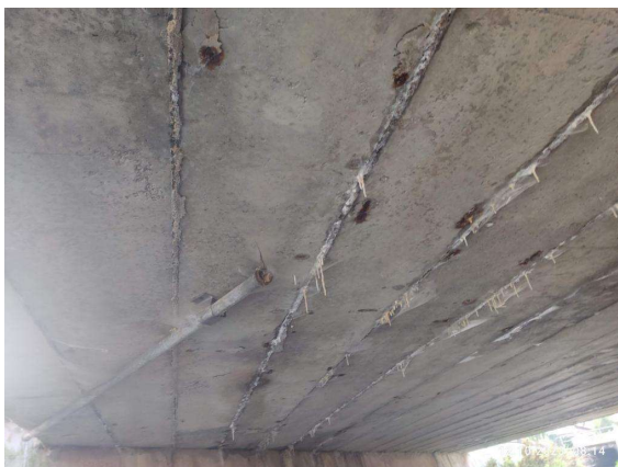
Podhled mostu ve směru staničení
