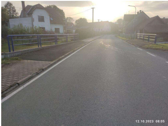
Pohled ve směru staničení
