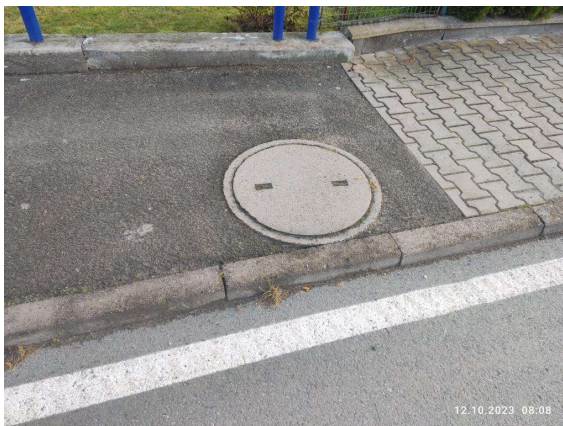
Uliční vpust' na konci mostu vlevo
