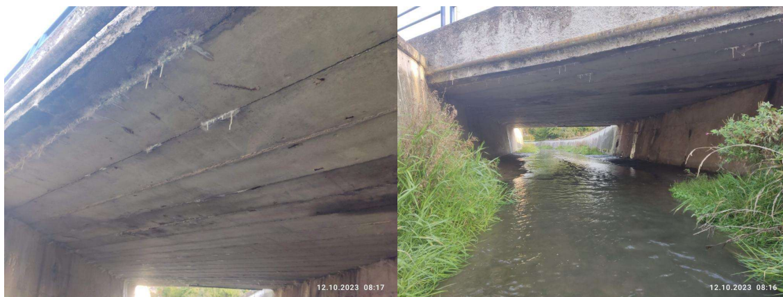
Pohled mostu zprava
