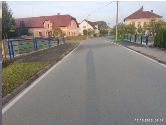
Pohled proti směru staničení
