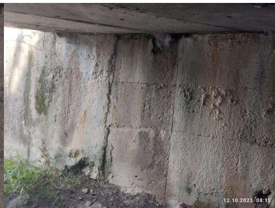
Mokrý průsaky mezi NK a opěrou OP1 vpravo_
