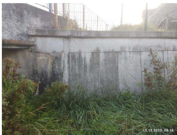
Pravé křídlo na konci mostu (K4)
