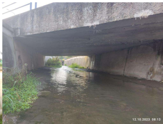
Pohled do mostu zleva
