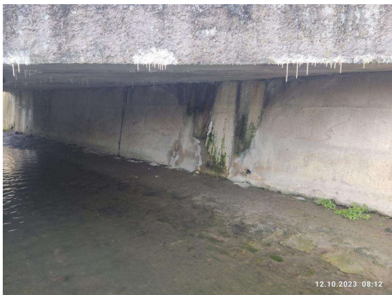
Pohled na opěru OP1 na začátku mostu zleva
