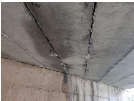
Podhled NK vpravo
