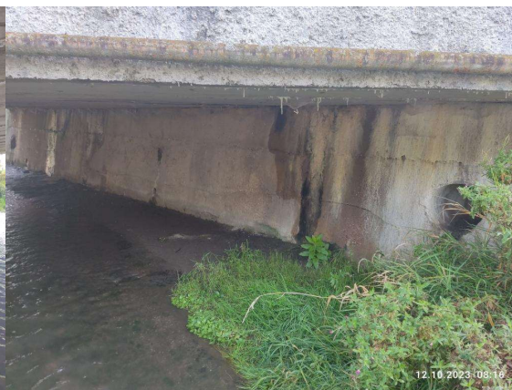
Pohled na opěru OP2 na konci mostu zprava
