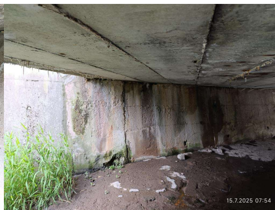
Opěra na začátku mostu (2)
