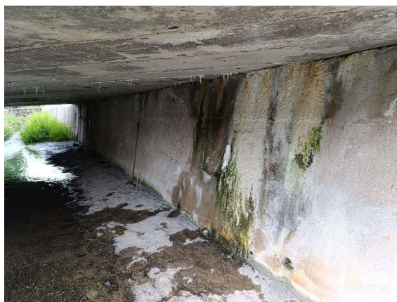
Opěra na začátku mostu (1)
