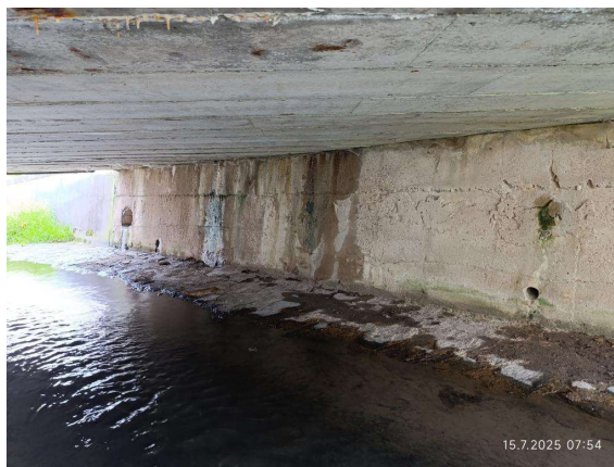
Opěra na konci mostu (2)
