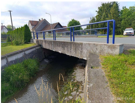
Levá strana mostu
