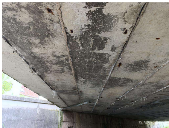
Podhled nosné konstrukce
