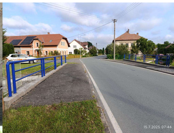
Pohled proti směru staničení
