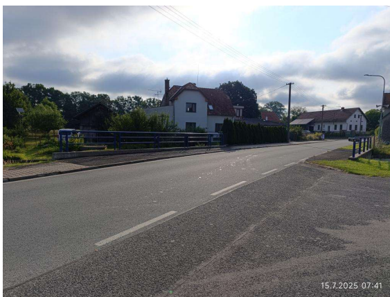
Pohled ve směru staničení
