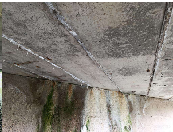
Podhled nosné konstrukce (1)
