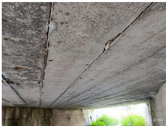
Podhled nosné konstrukce (2)
