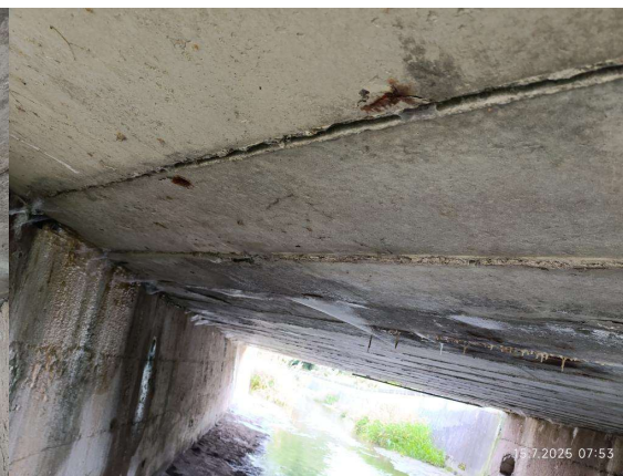
Podhled nosné konstrukce (3)
