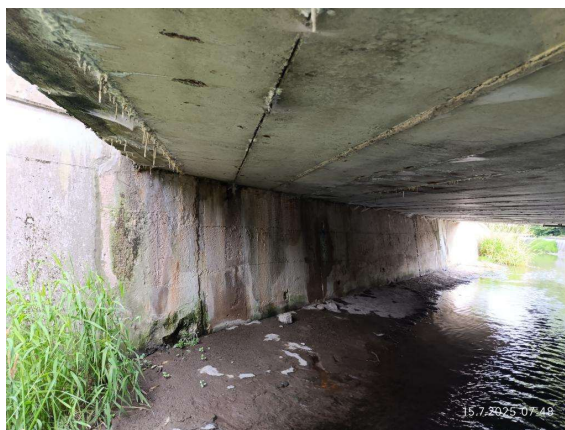
Opěra na začátku mostu
