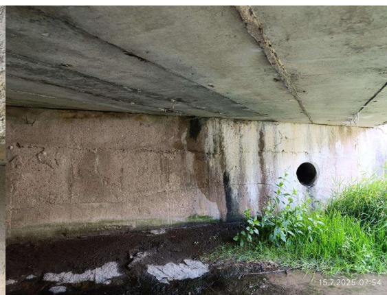
Opěra na konci mostu (1)
