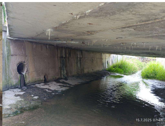
Opěra na konci mostu
