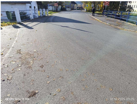
Stav krytí vozovky na mostě
