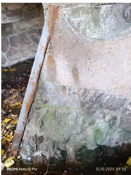
Pohled na podpěru (4)
