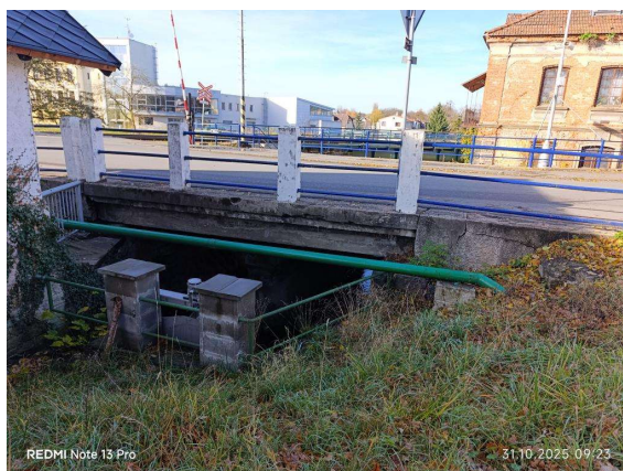
Pravá strana mostu
