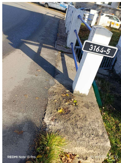
Horní plocha pravé římsy
