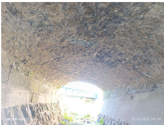
Podhled nosné konstrukce (1)
