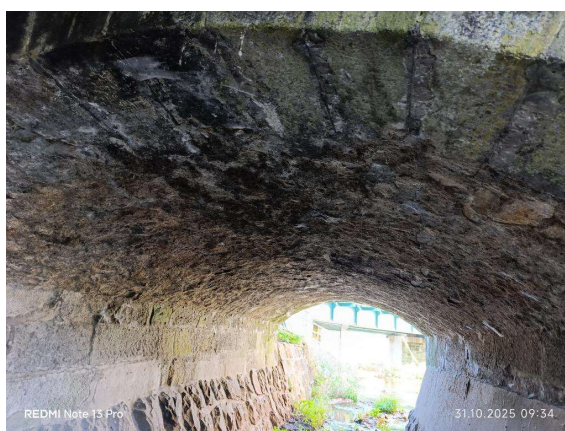
Pohled nosné konstrukce
