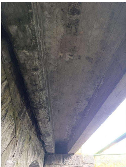
Podhled nosné konstrukce (3)
