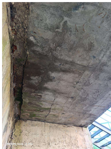
Pohled nosné konstrukce (6)
