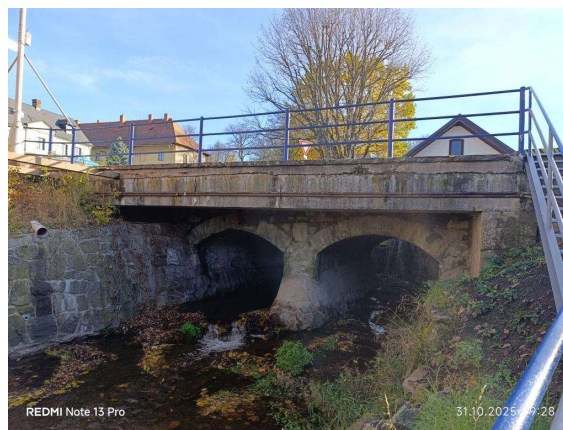
Levá strana mostu
