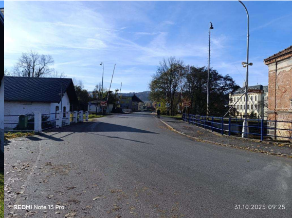
Pohled proti směru staničení
