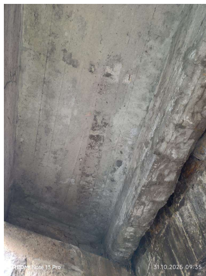
Podhled nosné konstrukce (4)
