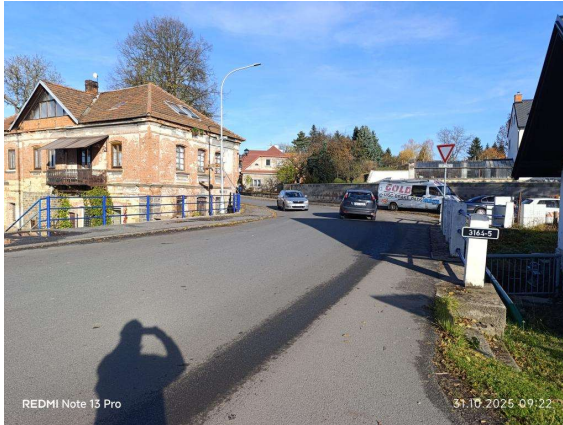
Pohled ve směru staničení
