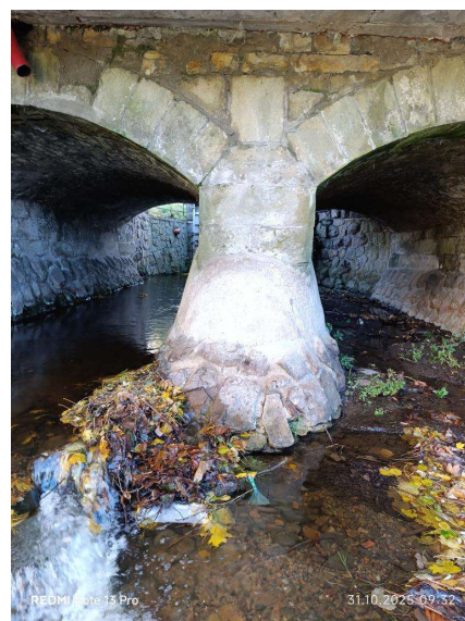
Pohled na podpěru
