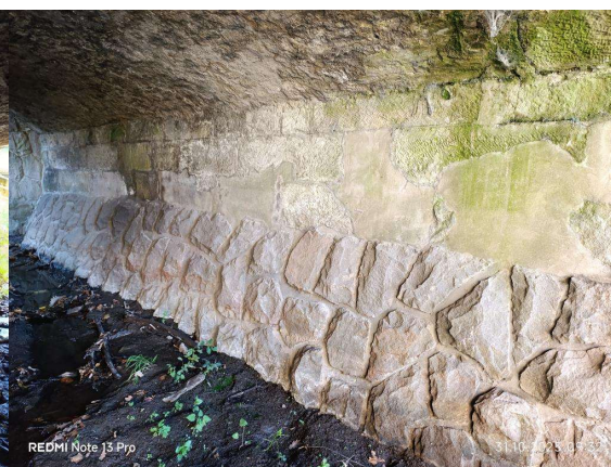
Opěra na začátku mostu
