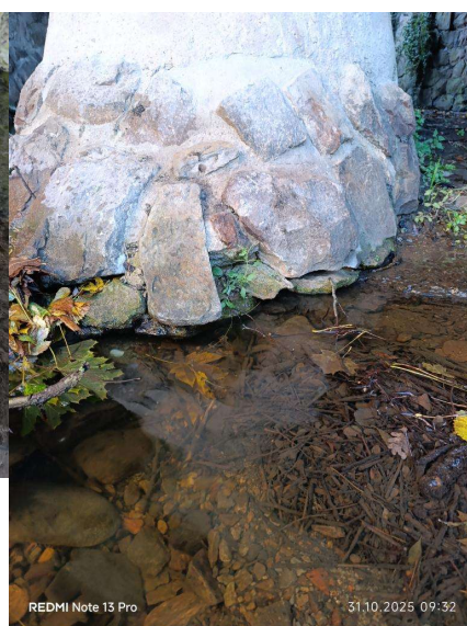
Pohled na podpěru (1)
