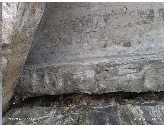
Podhled nosné konstrukce (2)
