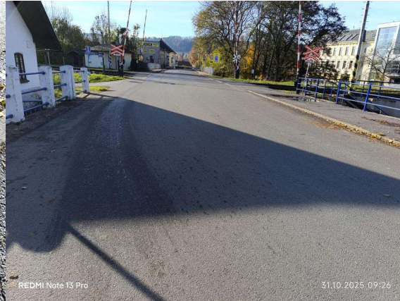
Stav krytí vozovky na mostě (1)
