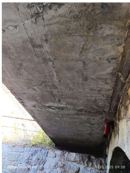
Pohled nosné konstrukce (5)
