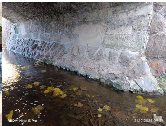
Opěra na konci mostu
