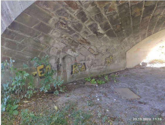
Pohled na opěru OP2 na konci mostu zleva
