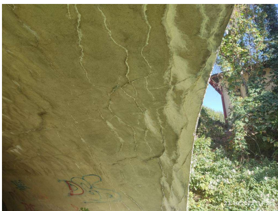
Podhled mostu vpravo
