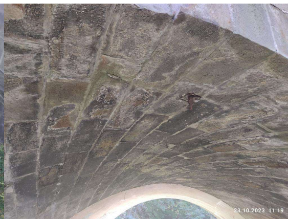
Podhled mostu zleva
