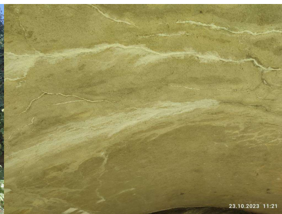
Podhled mostu vpravo_
