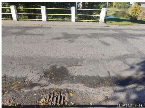
Uliční vpust' na konci mostu vpravo_
