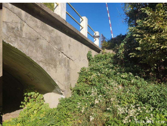
Pravé křídlo na konci mostu (K4)
