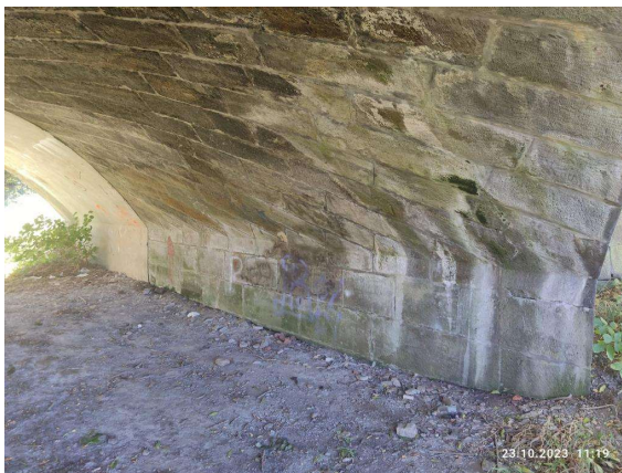
Pohled na opěru OP1 na začátku mostu zleva
