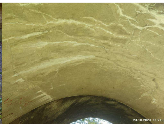
Podhled mostu zprava
