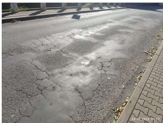
Stav krytu vozovky proti směru staničení
