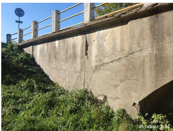
Pravé křídlo na začátku mostu (K2)
