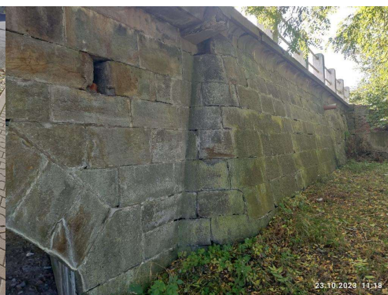
Levé křídlo na začátku mostu (K1)
