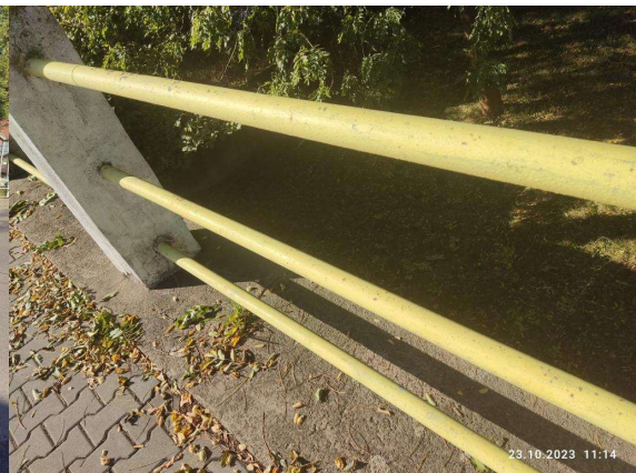
Stav nátěru levého zábradlí
