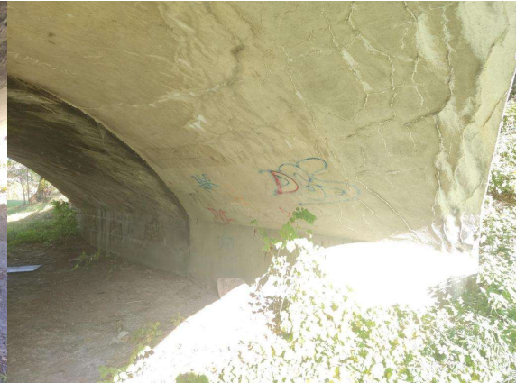
Pohled na opěru OP2 na konci mostu zprava
