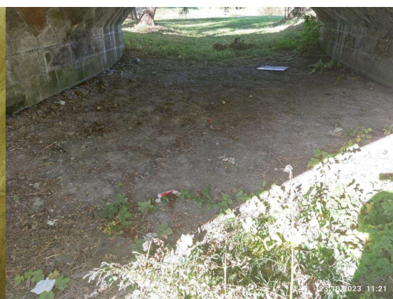
Stav koryta pod mostem zprava
