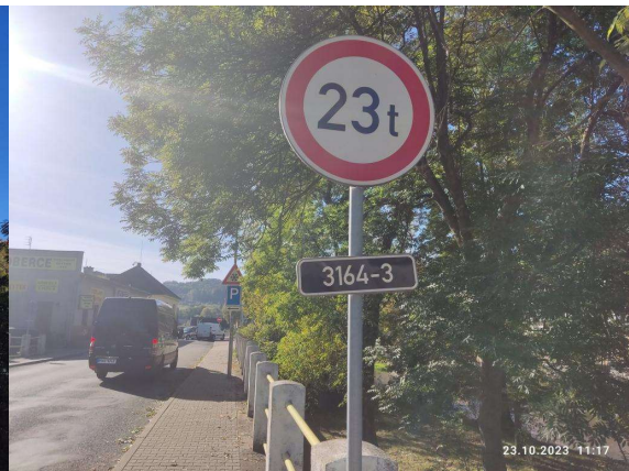
DZ umístěné na mostě na konci mostu
