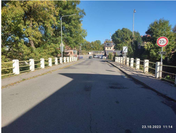
Pohled ve směru staničení
