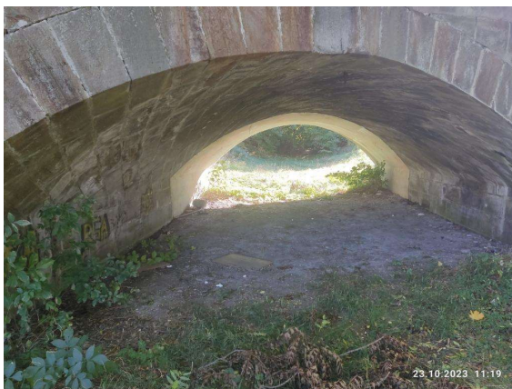
Pohled do mostu zleva
