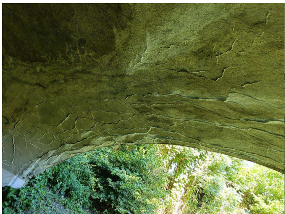
Podhled nosné konstrukce (3)
