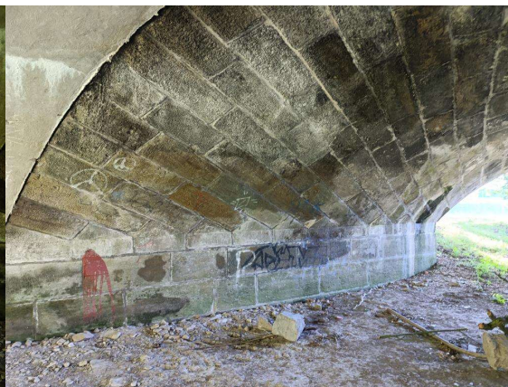
Opěra na začátku mostu
