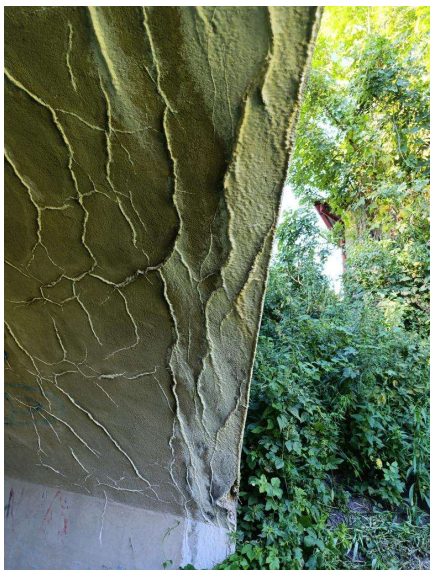
Lokální vápenné výluhy (2)
