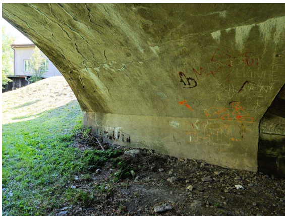
Opěra na začátku mostu (1)
