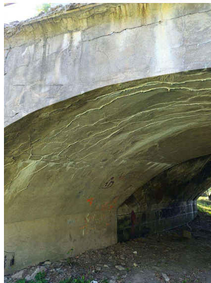
Lokální vápenné výluhy
