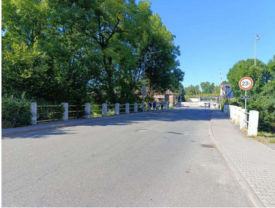
Pohled ve směru staničení
