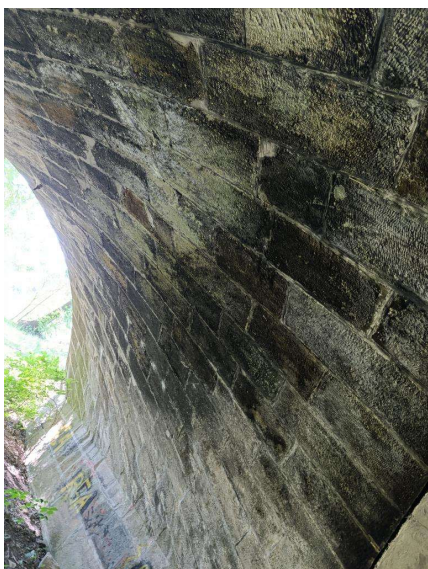
Podhled nosné konstrukce (1)
