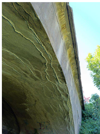
Lokální vápenné výluhy (1)
