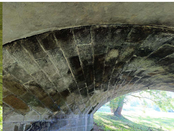
Podhled nosné konstrukce
