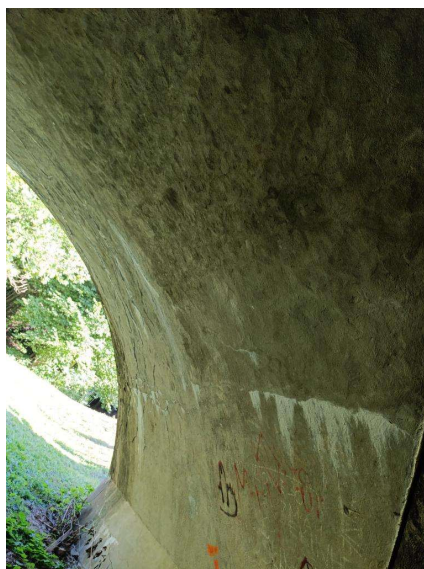
Podhled nosné konstrukce (2)
