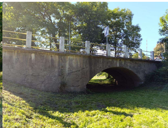
Pravá strana mostu
