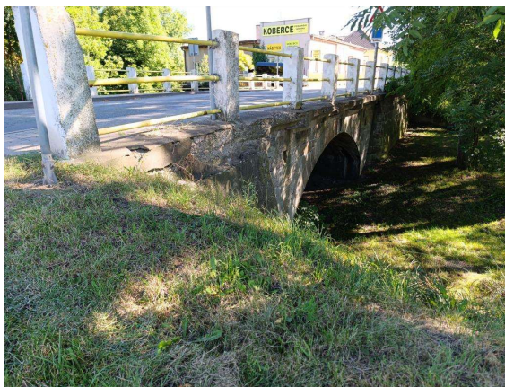
Levá strana mostu
