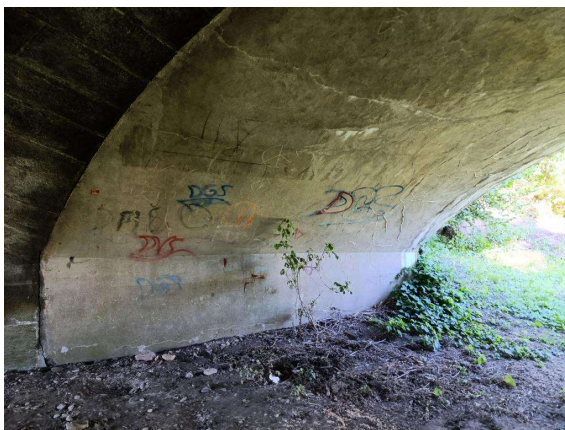
Opěra na konci mostu (1)
