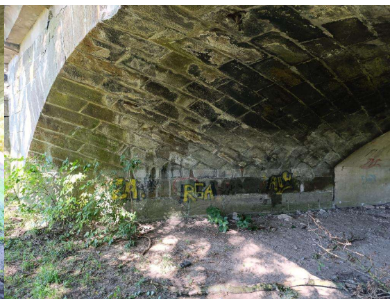
Opěra na konci mostu
