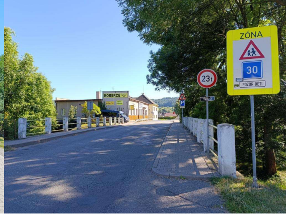
Pohled proti směru staničení
