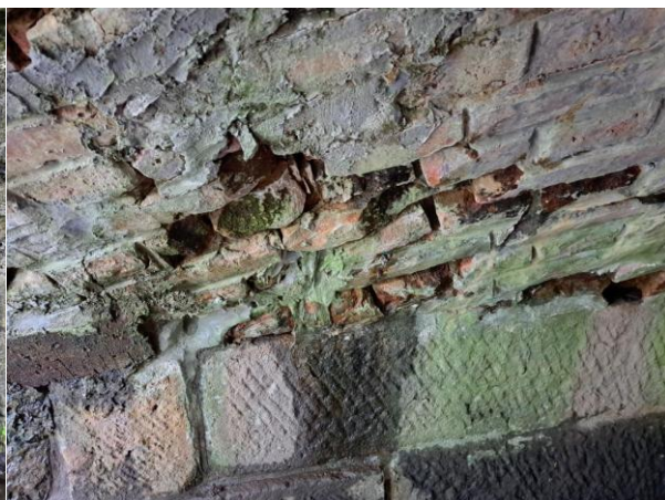
Detail zdiva_degradace cihel_rozvolnění_povodní strana
