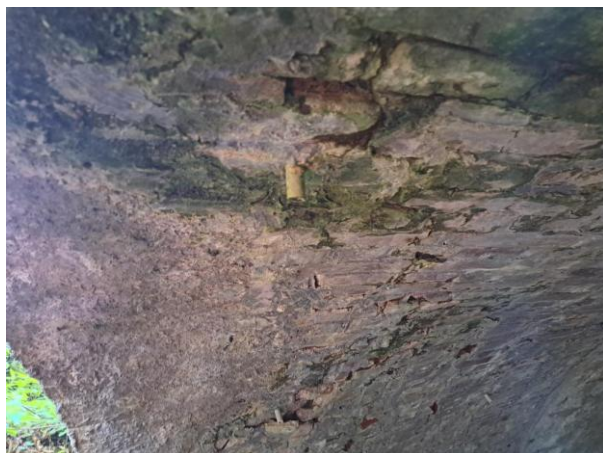
Detail odvodnění rubu klenby_povodní strana
