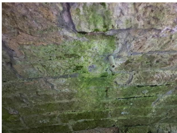
Detail odvodnění rubu klenby
