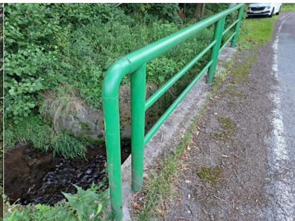
Zábradlí a římsa_návodní strana
