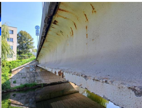
Krajní nosník_ návodní strana_ pohled od OP1
