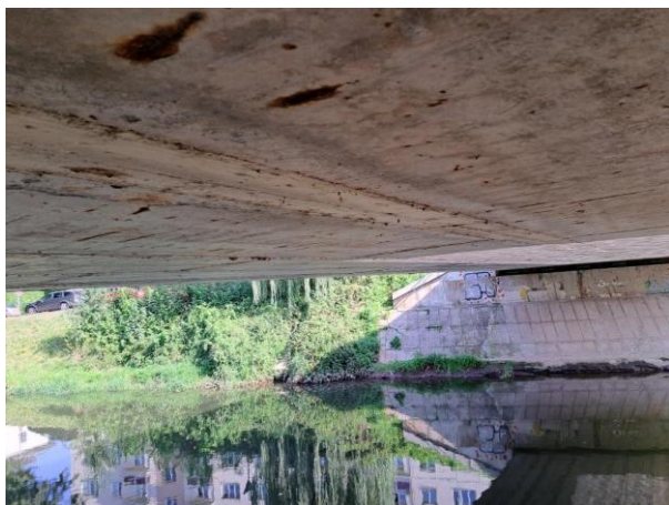
Podhled nosné konstrukce ve směru k OP2
