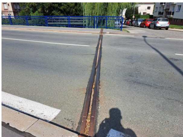
MZ nad OP2_proti směru toku
