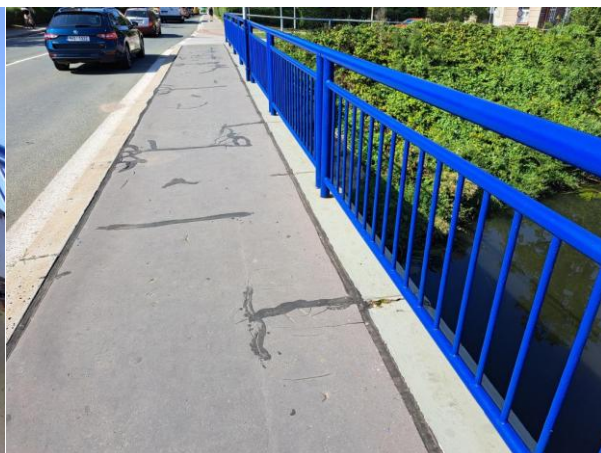
Chodník a zábradlí_ návodní strana
