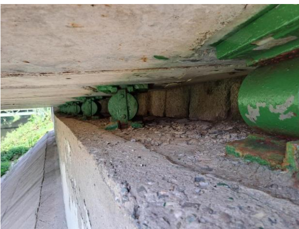
OP2_pohled na ložiska_proti směru toku
