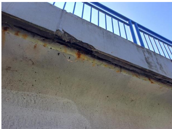
Detail gegardace římsovky_ návodní strana
