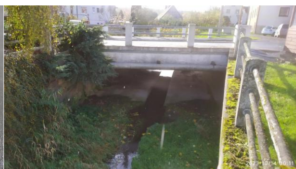
Pohled levá strana mostu
