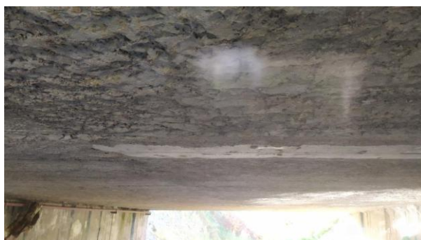
Podhled nosné konstrukce
