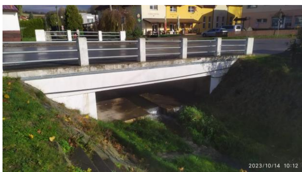
Pohled pravá strana mostu
