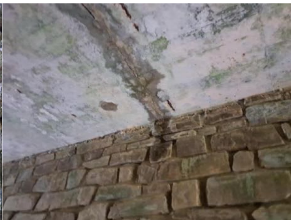
trhlina zdiva_přechod OP1 na křídlo na povodní straně průsaky_trhlina na podhledu NK_osa mostu
