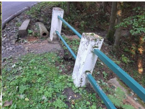
zábradlí povodní strana
