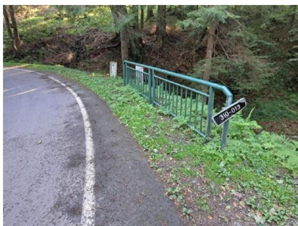
zábradlí návodní strana
