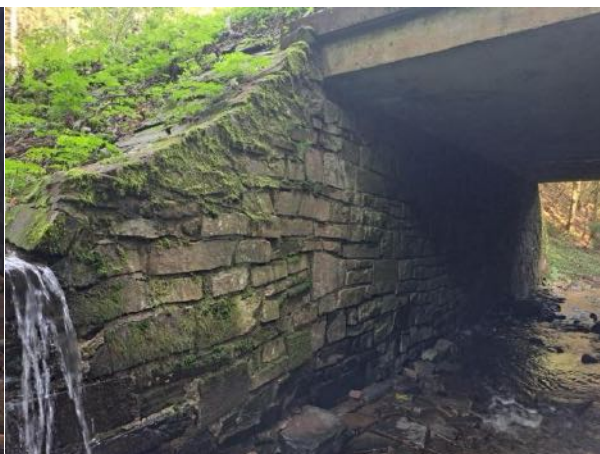
křídlo OP2_návodní strana
