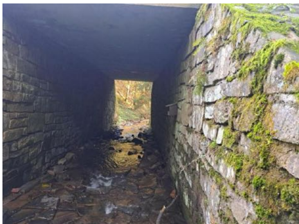
křídlo OP1_návodní strana
