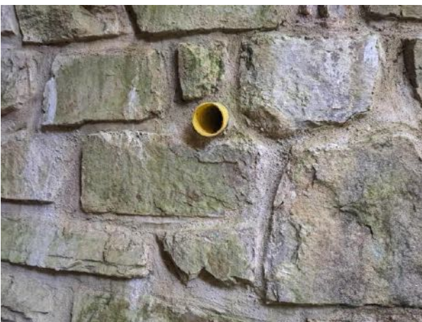
vyústění drenáže_zdivo OP2_povodní strana
