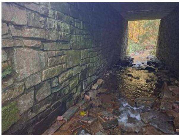
pohled na spodní stavbu po směru toku
