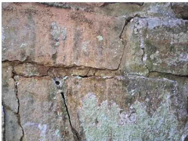
trhlina zdiva_přechod OP1 na křídlo na povodní straně průsaky_trhlina na podhledu NK_osa mostu
