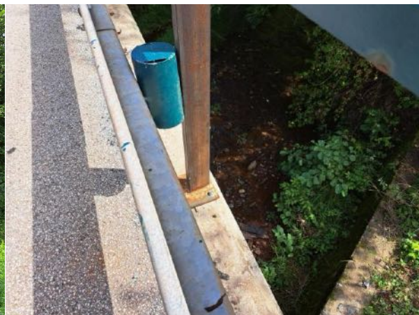
sloupek ZS po provedené opravě
