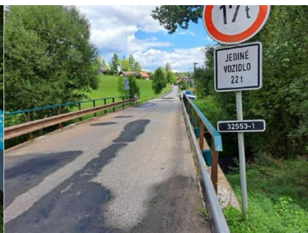
pohled po směru staničení
