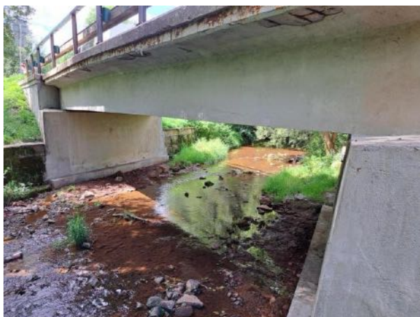
krajní nosník pravá strana
