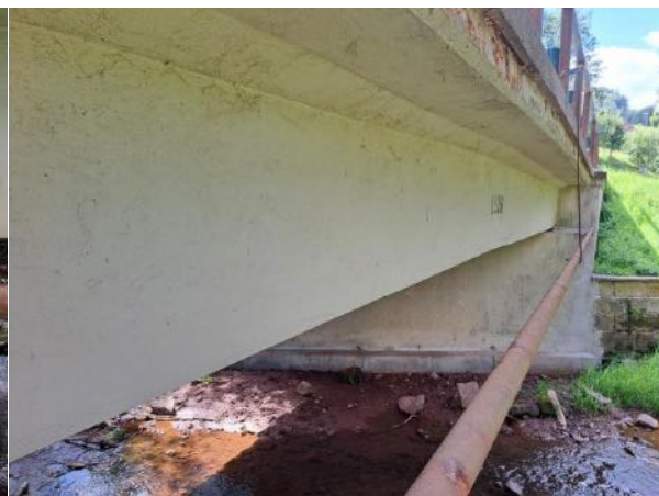
krajní nosník_levá strana od OP2
