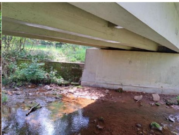
OP1 a podhled nosné konstrukce
