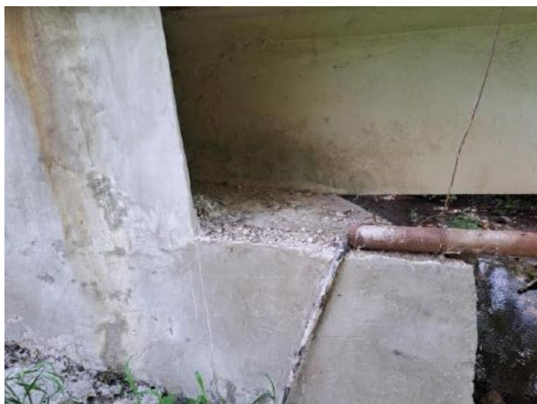
uložení nosníku_OP2_levá strana
