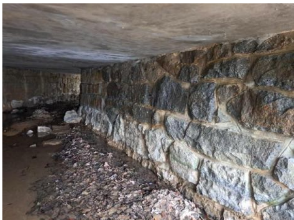
OP2_proti směru toku
