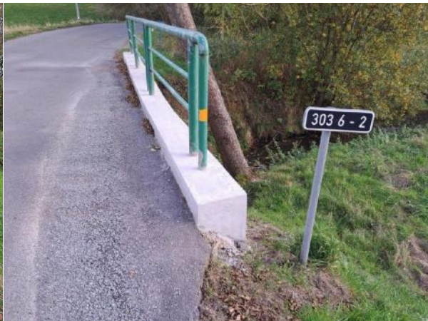
římса a zábradlí_povodní strana
