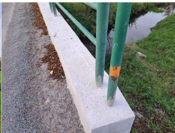
římса a zábradlí_návodní strana
