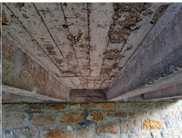
podhled nosné konstrukce
