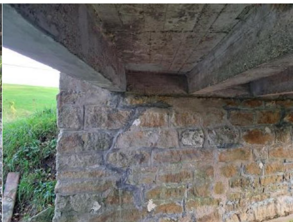
zdivo OP2_návodní strana_po opravě
