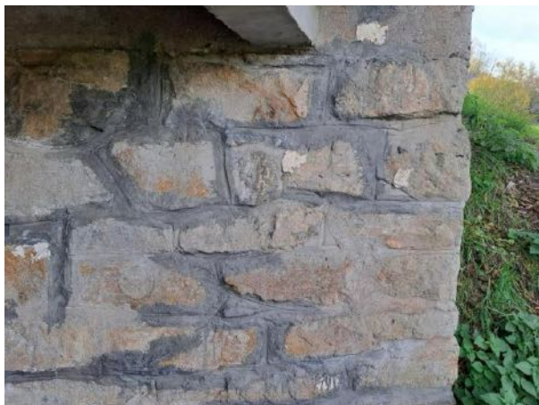
zdivo OP1_návodní strana_po opravě
