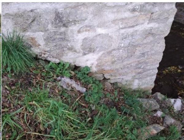
křídlo OP2_návodní strana
