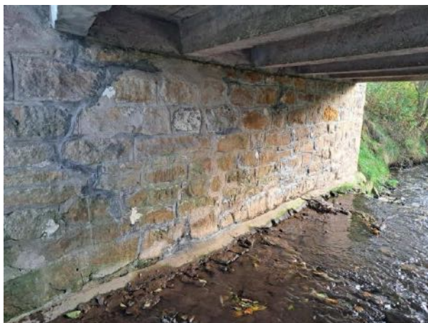
zdivo OP2 po opravě
