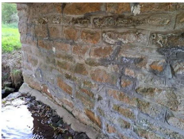
zdivo OP1_povodní strana_po opravě
