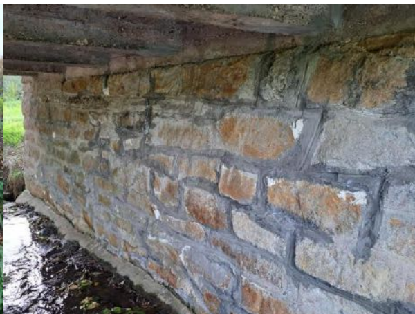
zdivo OP1_po opravě
