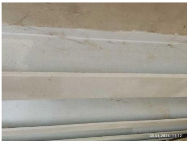
Podhled nosné konstrukce
