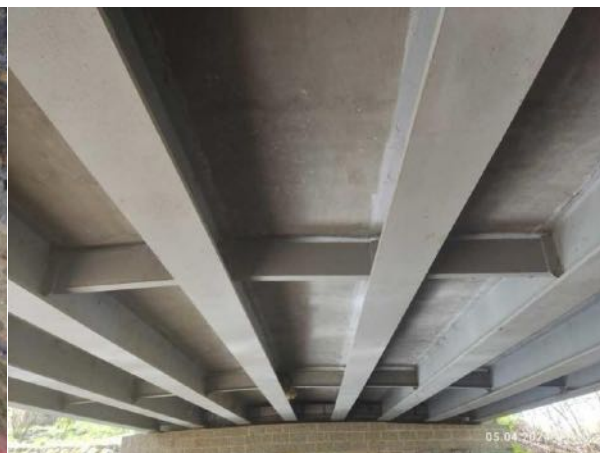
Podhled nosné konstrukce
