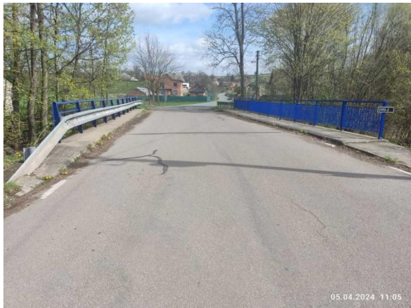
Pohled ve směru staničení
