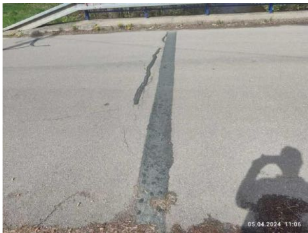
Mostní závěr na začátku mostu
