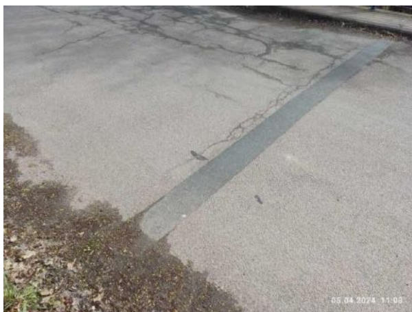
Mostní závěr na konci mostu
