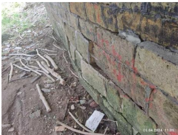
Opěra na konci mostu
