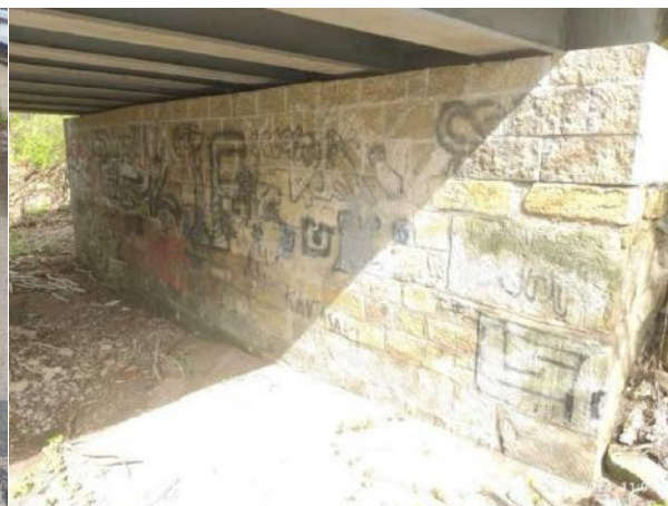
Opěra na konci mostu
