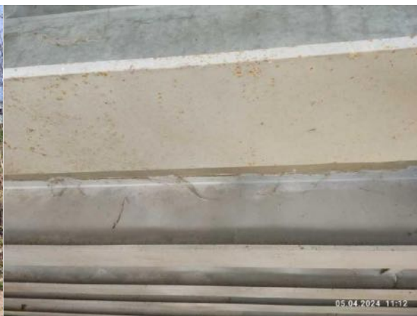
Podhled nosné konstrukce
