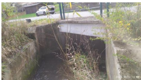
Pohled levá strana mostu
