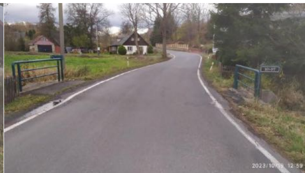
Pohled proti směru staničení
