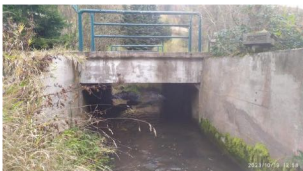
Pohled pravá strana mostu
