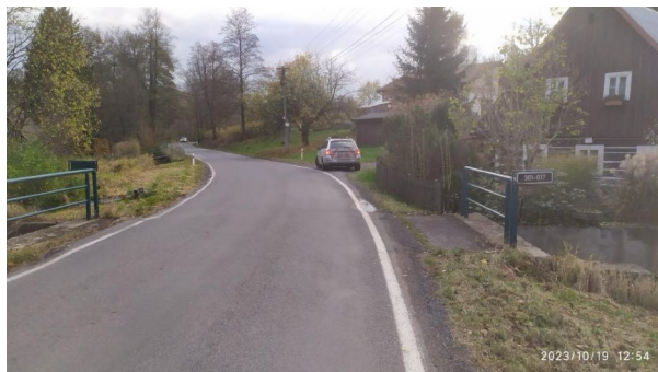
Pohled ve směru staničení
