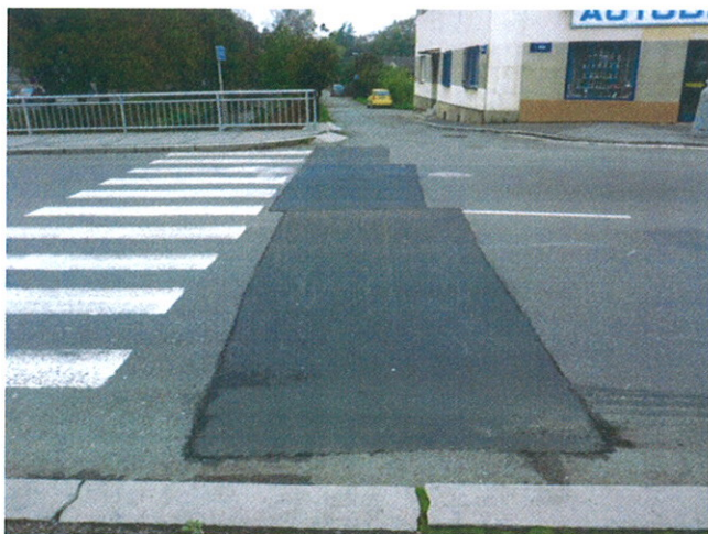
opravy na konci mostu
