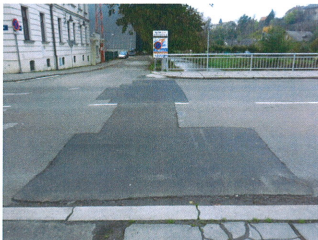
opravy na začátku mostu
