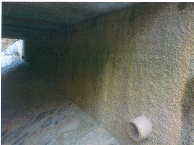
opěra na konci mostu
