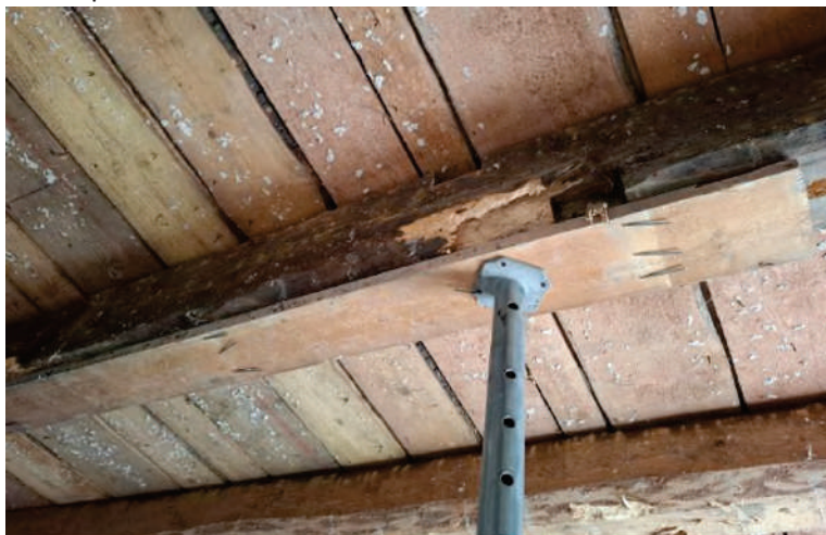
8. Strop nad místností č. 109
