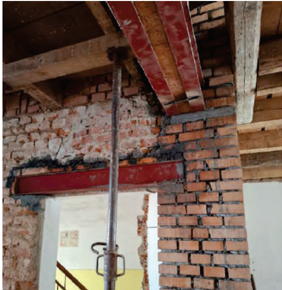
9. Uložení stropní konstrukce v 2.NP
