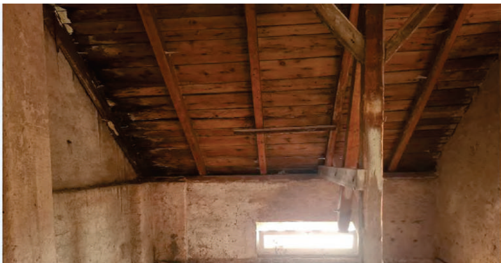
16. Místnost č. 302 – střešní konstrukce
