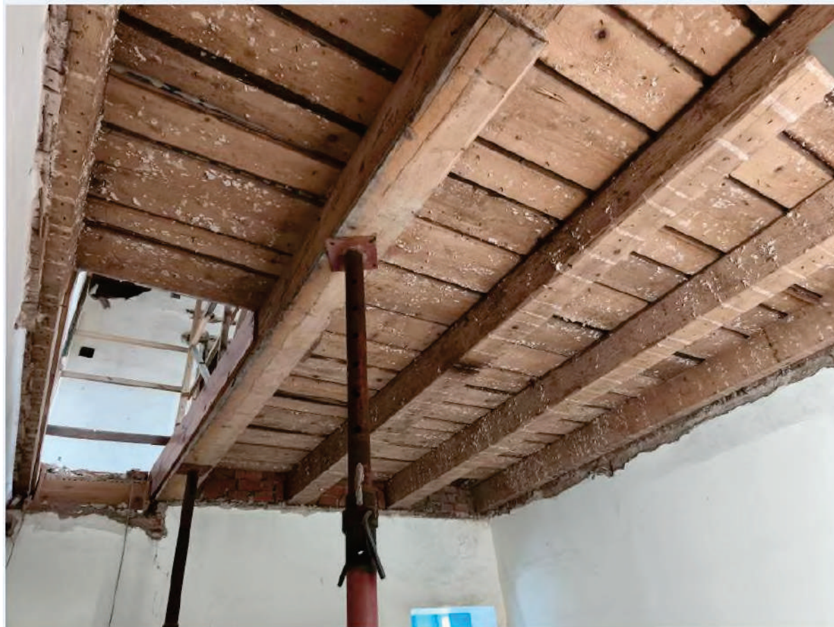
4. Strop nad místností č. 103 a 110
