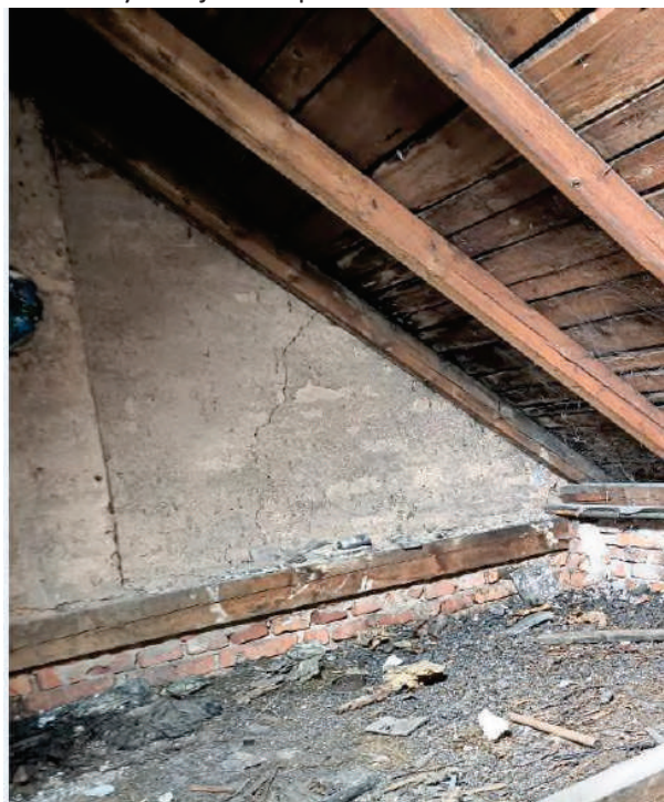
5. Trhliny v objektu – podkroví
