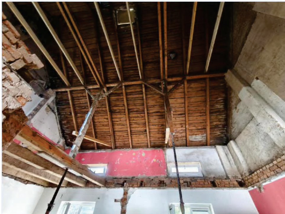
6. Stropní nad místností č. 105 včetně podpírání stropních trámů
