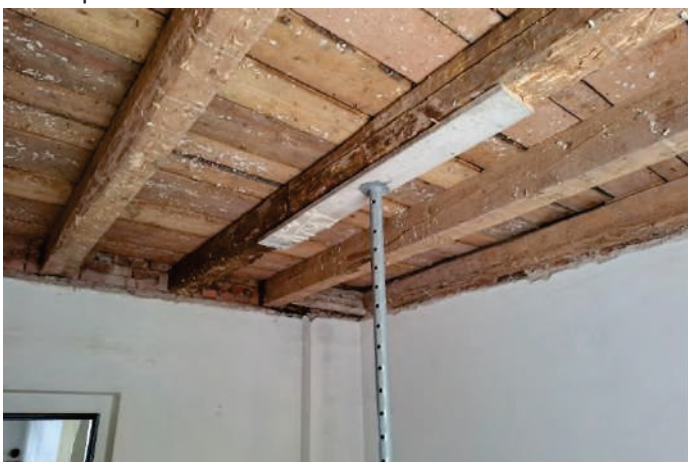
6. Strop nad místností č. 108
