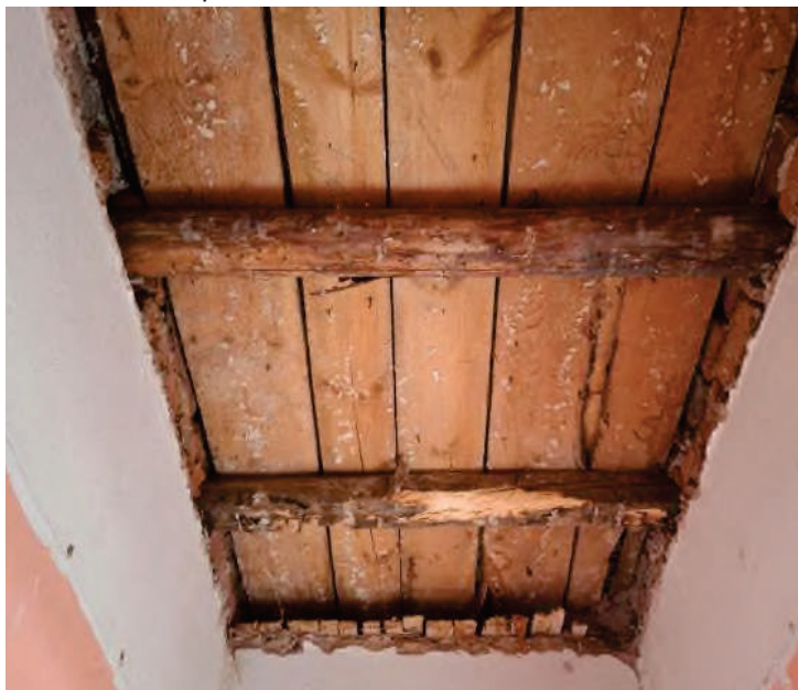
12. Strop nad místností č. 209
