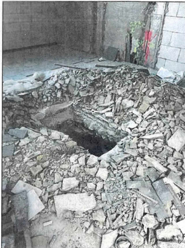
Obr. č. 1 a 2: výkop sodny a výnos deskovitých hornin
