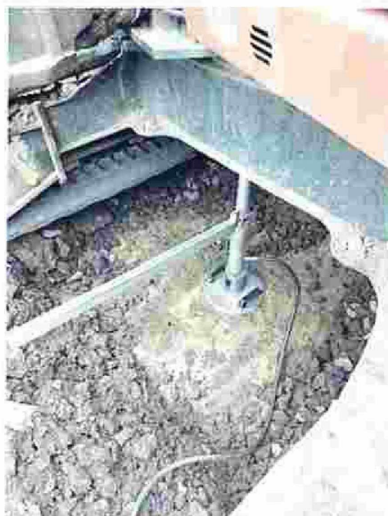
Obr.4 – zvýšená vlhkost na rozhraní pláňe a KV
