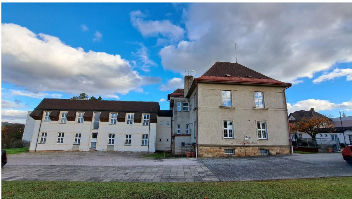
západní pohled - přístavba a stará část
