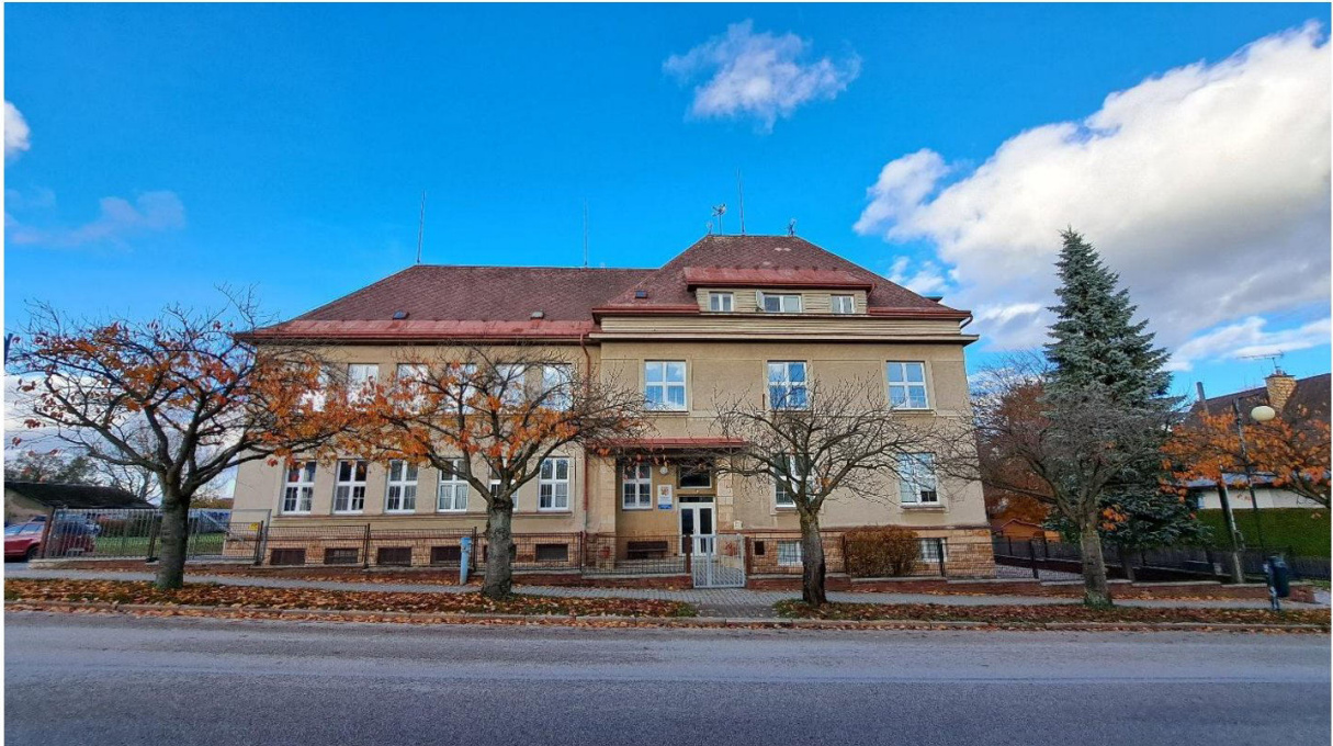
jižní pohled - stará část
