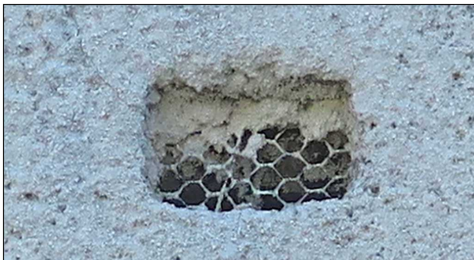
Ventilační otvo- ry jsou v obvo- dovém zdivu utěsněny kovo- vými mřížkami různých typů.
