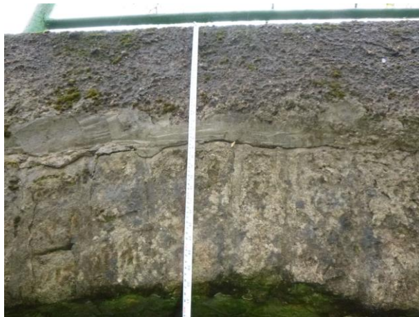
Na prstenci ve vrcholu navazuje betonová římsa.
