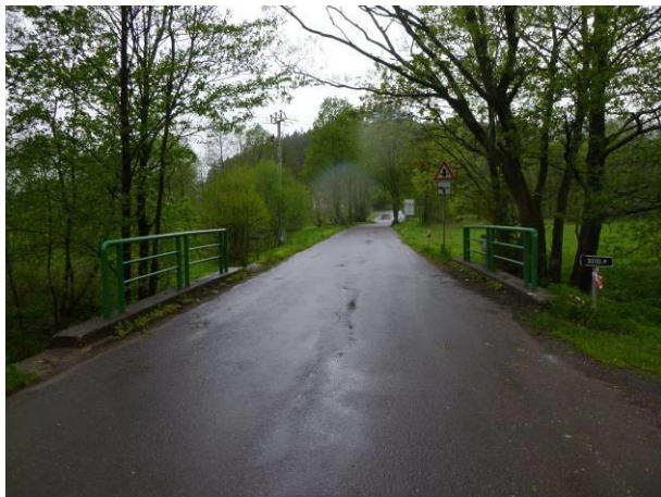
Pohled na vozovku v místě mostu ve směru staničení.
