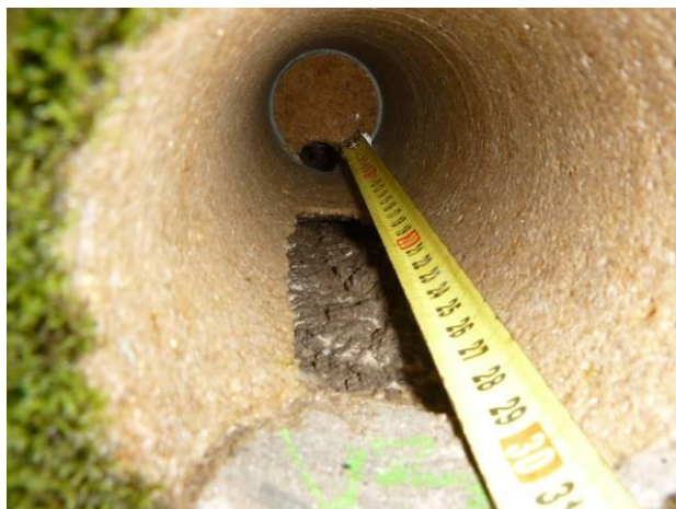
Pohled do vývrtu V3, viditelná ložná malta.
