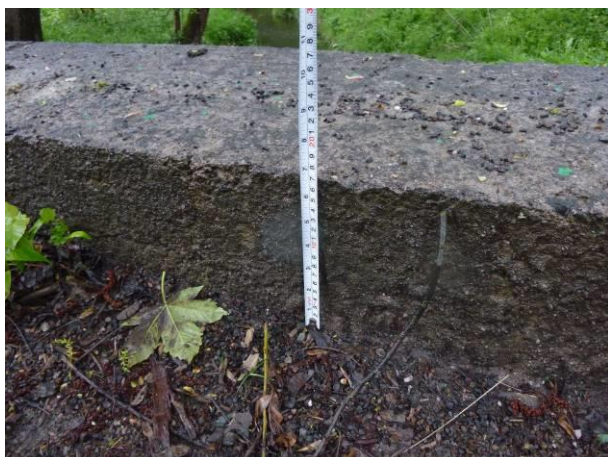
Výška římsy od vozovky byla naměřena 170 mm.
