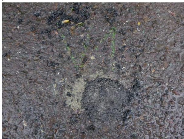
Zapravení vývrtu V1 studenou asfaltovou směsí.
