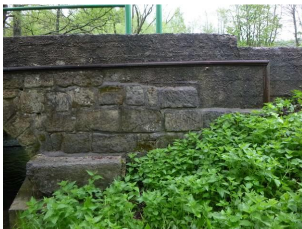
Detailní pohled na levé křídlo OP2.
