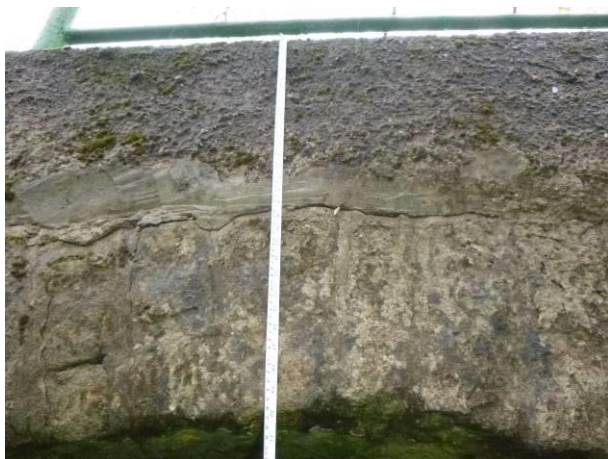
Pohled na vrchol klenby. Viditelný prstenec a betonová římsa.
