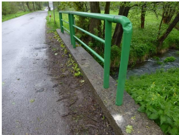
Pohled na betonovou pravou římsu.
