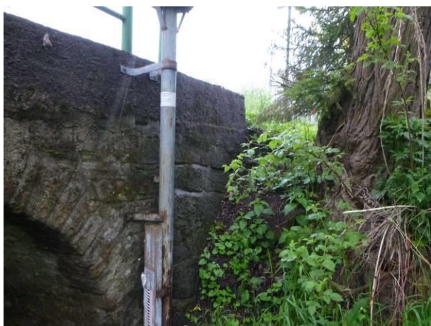
Detailní pohled na levé křídlo OP1.
