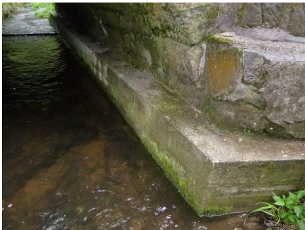
Pohled na betonový práh pravé strany klenby.
