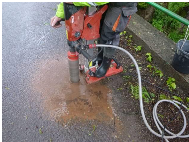
Pohled na jádrové vrtání do vozovky.
