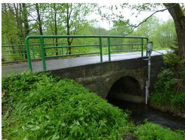
Pohled na konstrukci ze strany vtoku.
