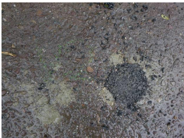
Zapravení vývrtu V2 studenou asfaltovou směsí.
