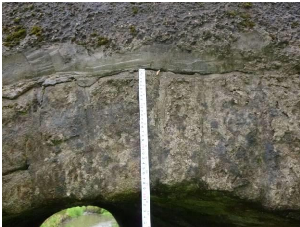
Ověřená tloušťka odpovídá tloušťce kamene prstence, která byla naměřena 300 mm.
