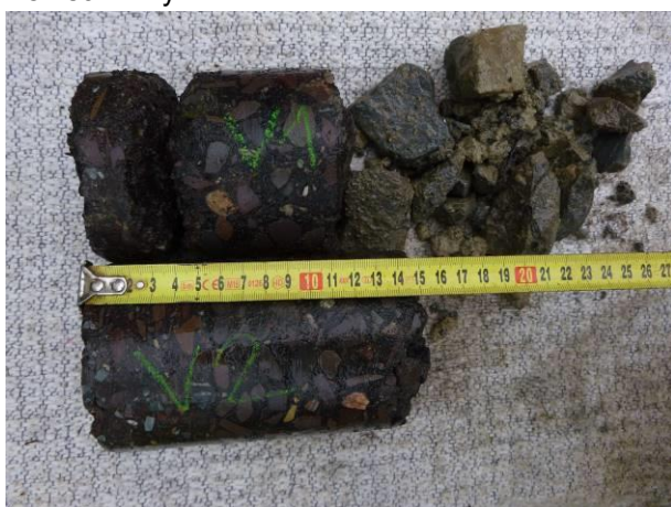
Pohled na skladbu vozovky z vývrtů V1 a V2.
