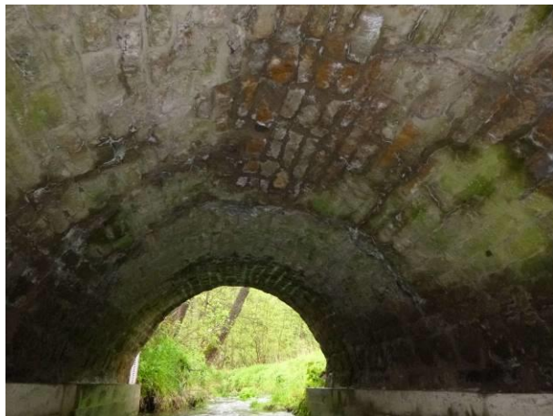
Pohled na klenbu proti proudu.
