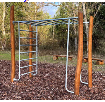
Venkovní cvičební prvky - žebříky vertikální a horizontální a 2 vertikální špihací tyče, konstrukce z akátových kůlů, fošen a ohybných ocelových trubek, (referenční foto)
