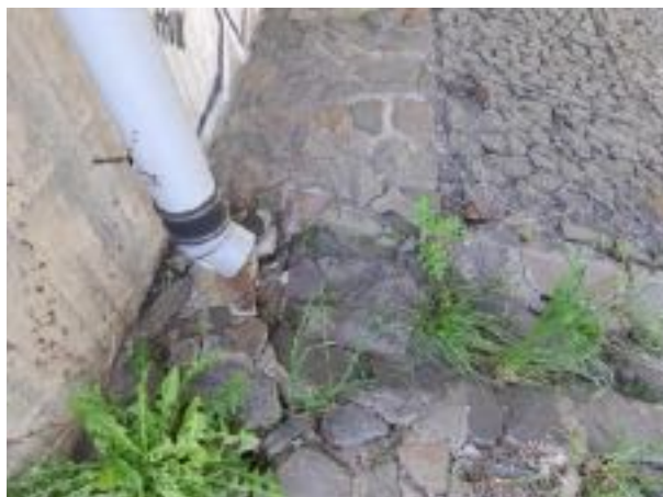
svod odvodnění u OP1
