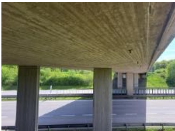
podhled nosné konstrukce proti směru staničení
