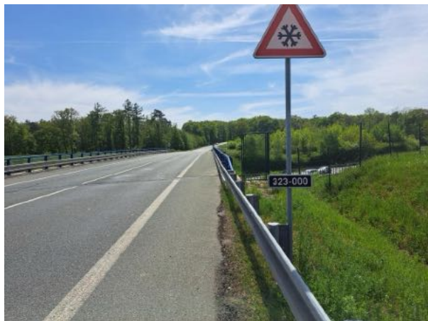
pohled proti směru staničení
