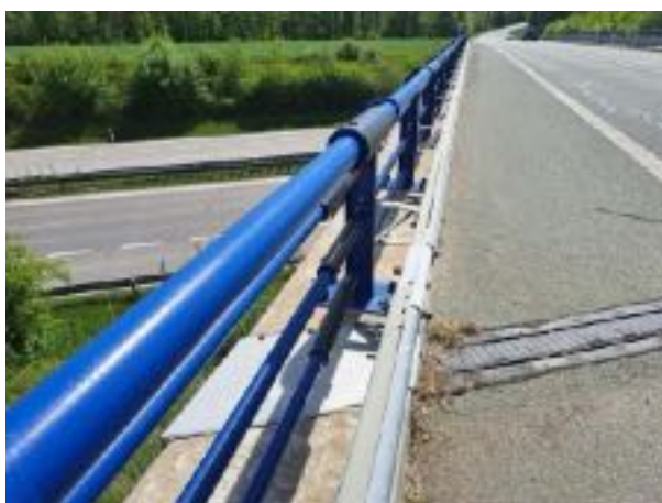
zábradelní svodidlo vpravo
