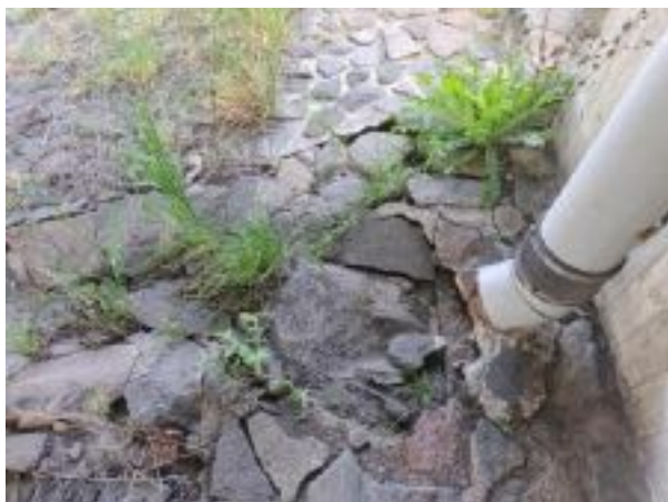
vyústění odvodňovače u OP1_vlevo
