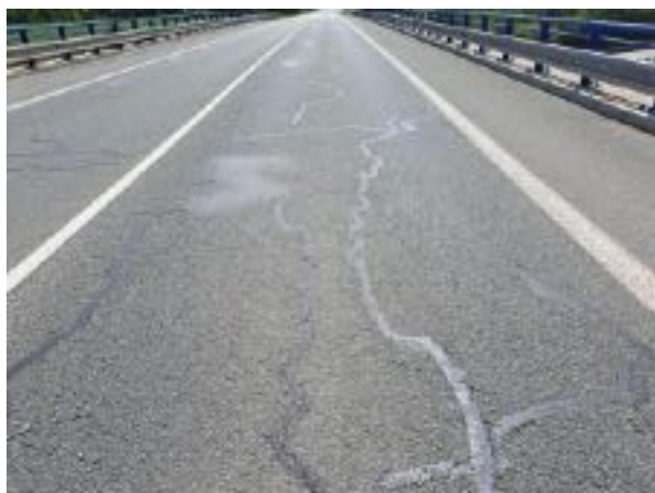
kryt vozovky_trhliny
