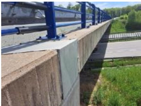
boční líc římsy_vpravo proti směru staničení
