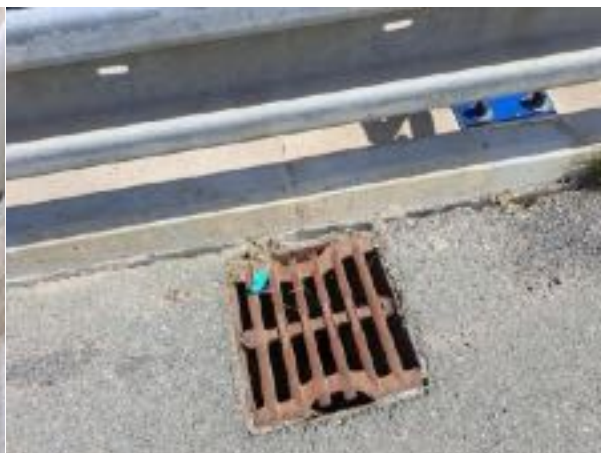
vpust' odvodňovače_vlevo začátek mostu
