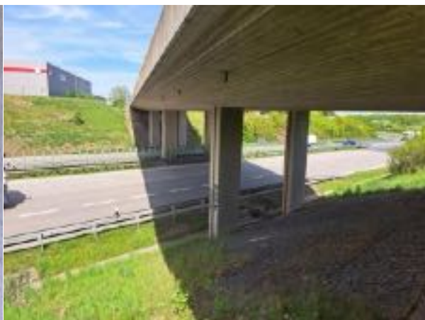
podhled nosné konstrukce_po směru staničení_vlevo
