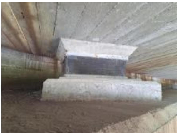
detail ložiska_opěra konec mostu_směr HK
