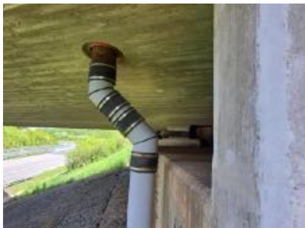
detail vyústění mostního odvodňovače_OP1 vlevo
