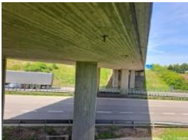
podhled nosné konstrukce _po směru staničení _pravá strana
