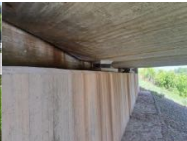
ložiska_opěra_konec mostu
