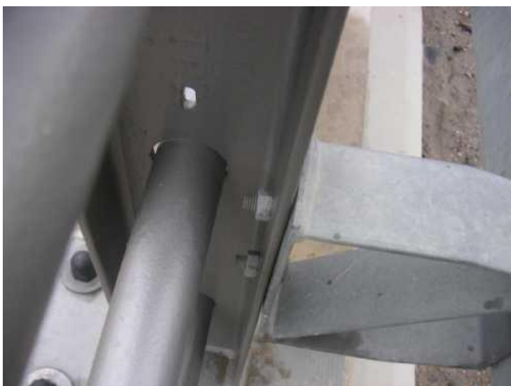
Chybějící podložky.
