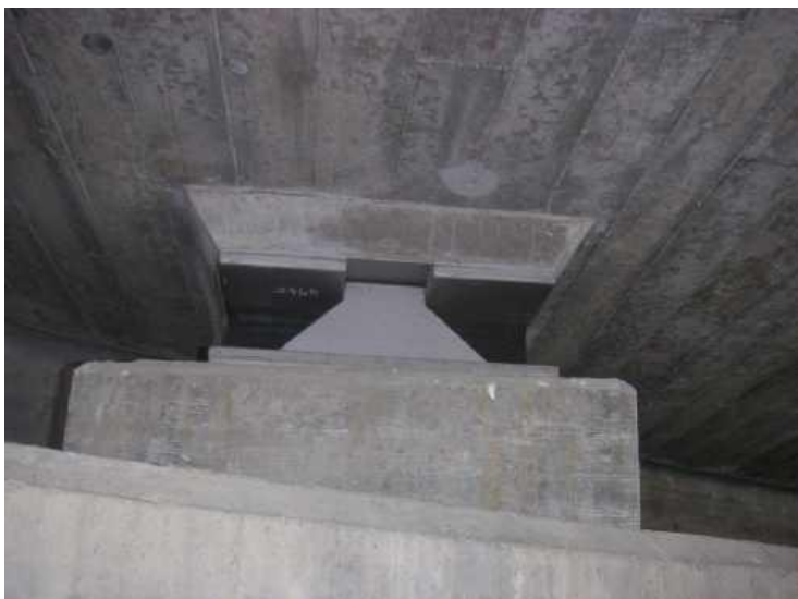
Nesymetricky osazené ložisko na betonový blok.
