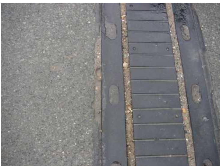
Vytržená zálivka na konci mostu vpravo.
