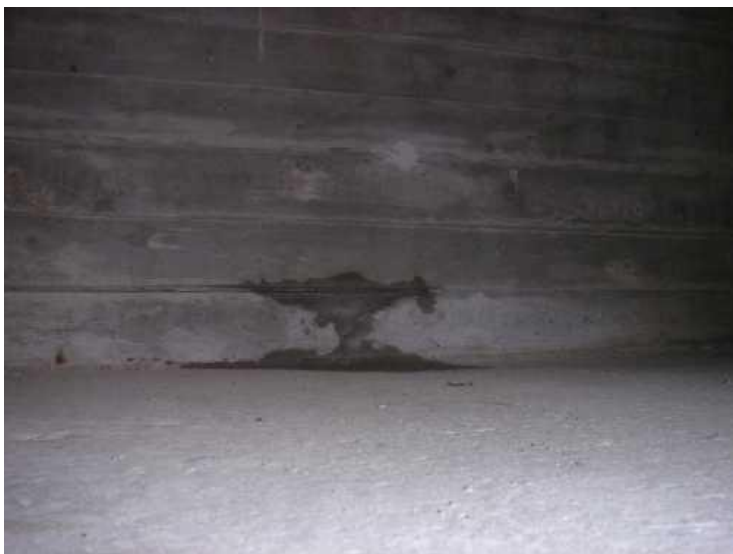
Průsak závěrnou zídkou na konci mostu vpravo.
