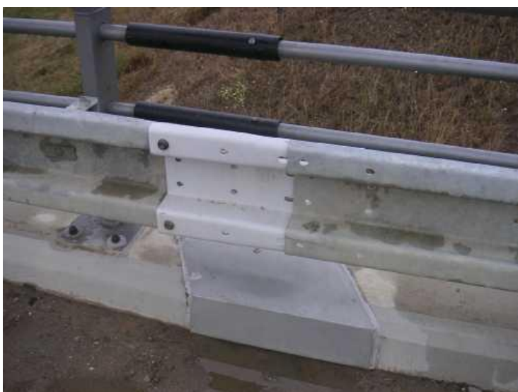
Nedokončená montáž dilatačních prvků svodidel.
