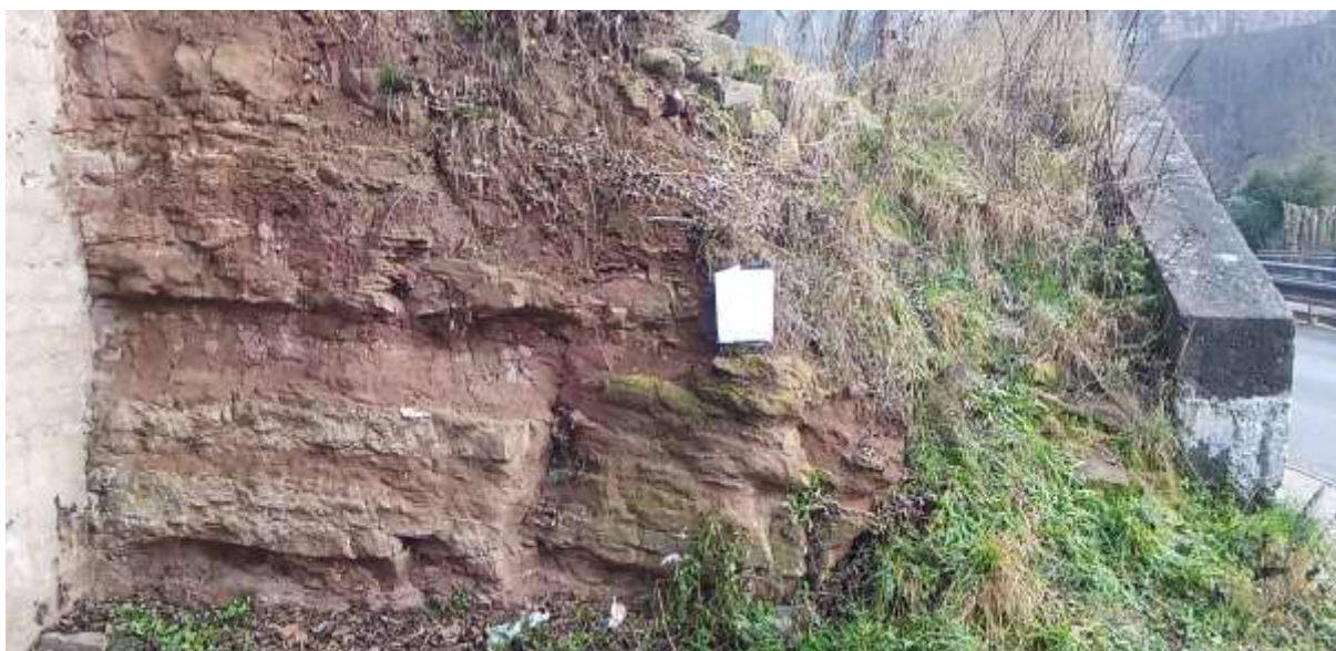
Obr. 2: Fotografická dokumentace výchozu KS-2 AB128 m s lavicemi odolnějšího pískovce a hlouběji vyvětrávajícími jemnozrnnějšími pískovci s vložkami aleuropelitů
