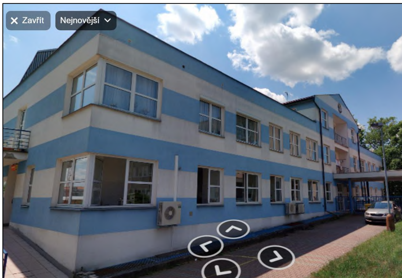
Severní pohled pavilonu E část 2
