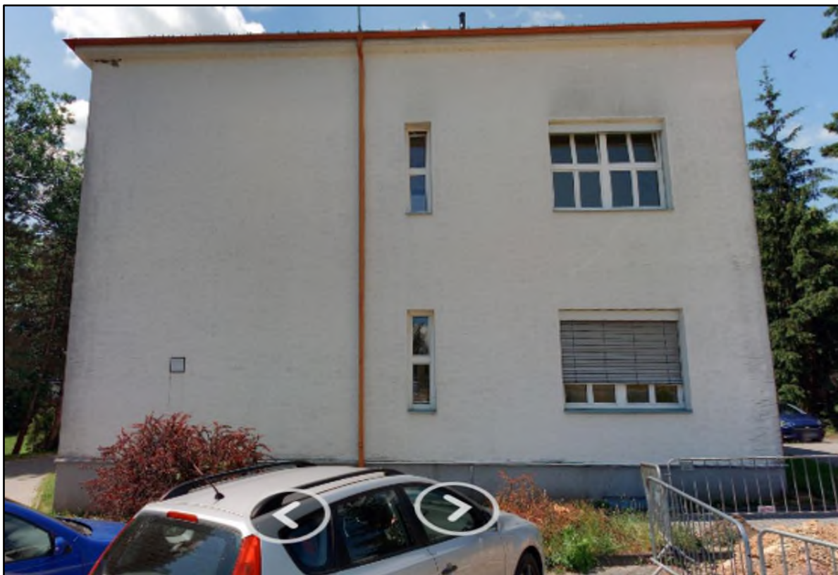
Východní pohled pavilonu D
