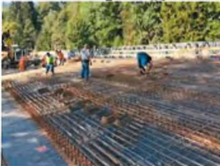
Montáž bednění mostovky
