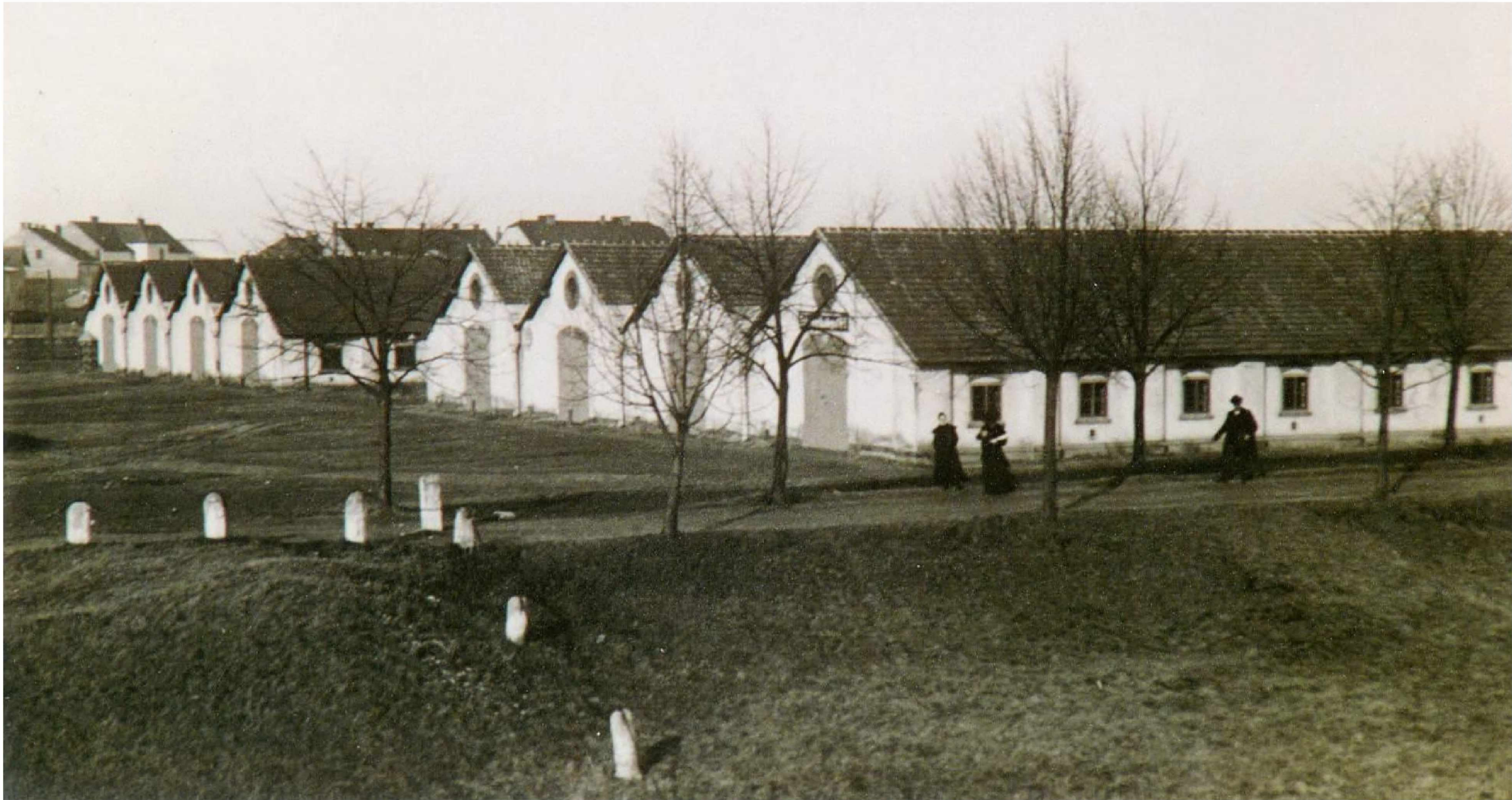
Obr. 5: Historická fotografie vozatajských kůlen Pohled na vozatajské dílny před rokem 1914, Zdroj: Fotoarchiv NPÚ, ÚOP v Josefově
