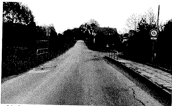
pohled proti směru staničení
