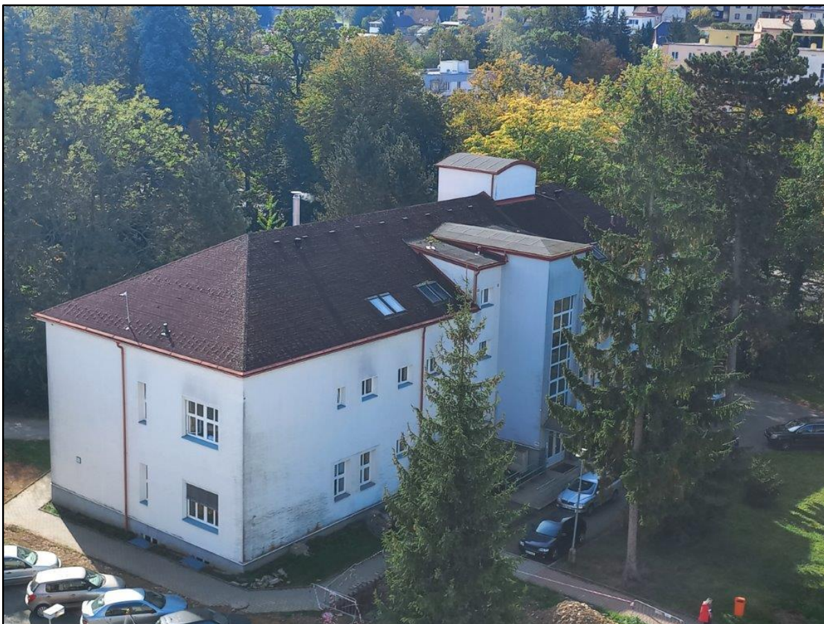
Severo východní pohled pavilonu D
