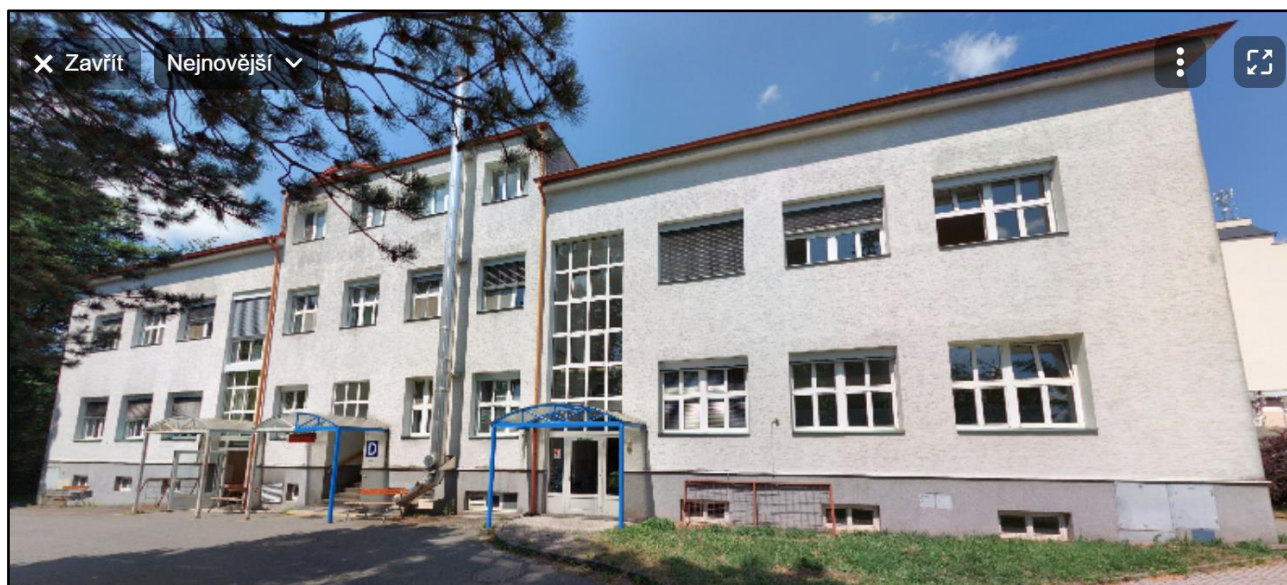
Jižní pohled pavilonu D
