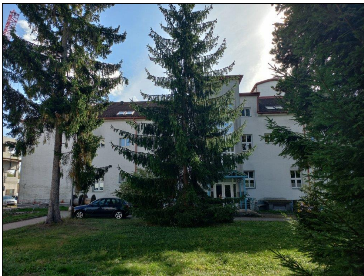
Severní pohled pavilonu D
