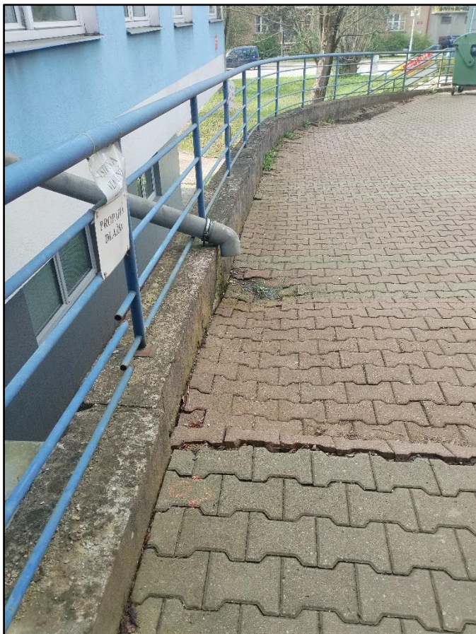
Severní odvodnění u opěrné stěny
