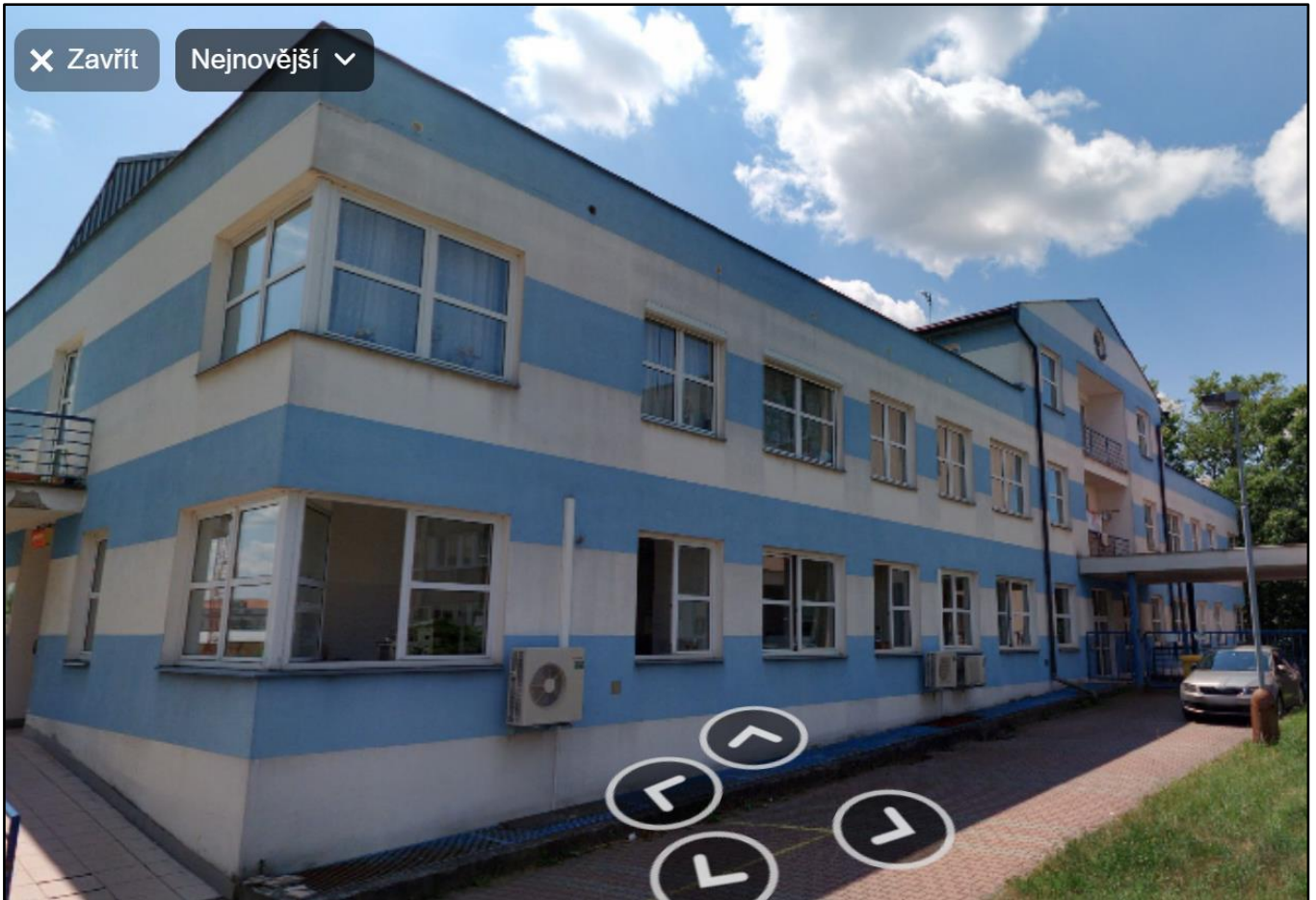
Severní pohled pavilonu E část 2
