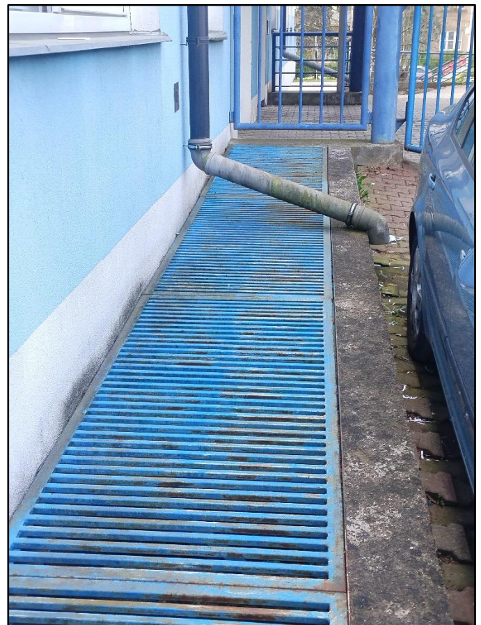
Severní odvodnění u anglických dvorků
